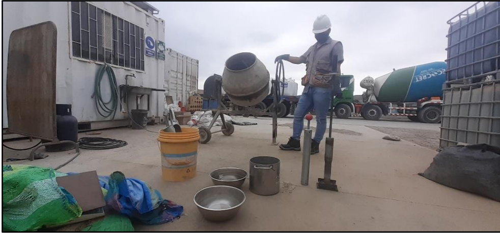
Preparación de las mezclas de concreto permeable
