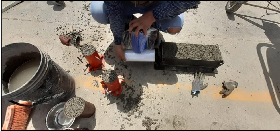
Colocación de plástico para cubrir los cilindros y vigas de concreto permeable recién moldeados
