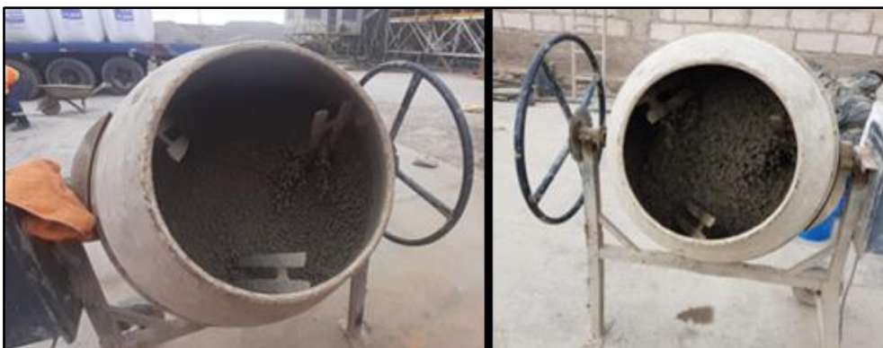
Preparación de las mezclas de concreto permeable
