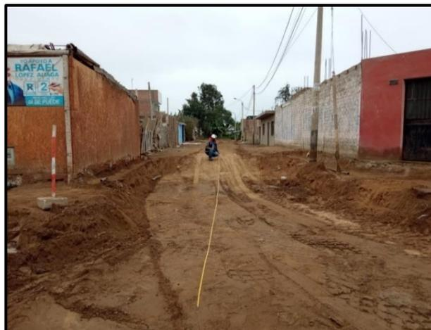
**Paso 3)** Se adjunta protocolo de Trazo y Replanteo en veredas, corroborando lo establecido en las especificaciones técnicas del proyecto.
