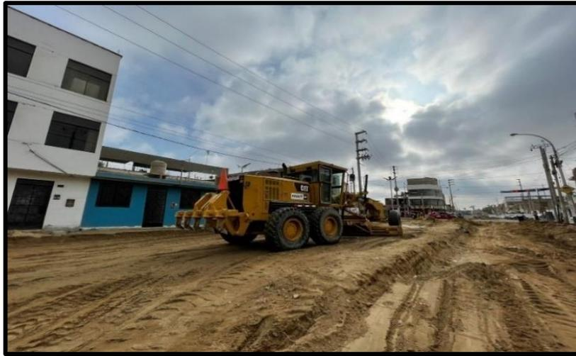
**Paso 2)** Se procede a verificar trabajos de excavación y nivelación de las zonas del proyecto según trazado del perfil longitudinal de ciclovía en berma central.
