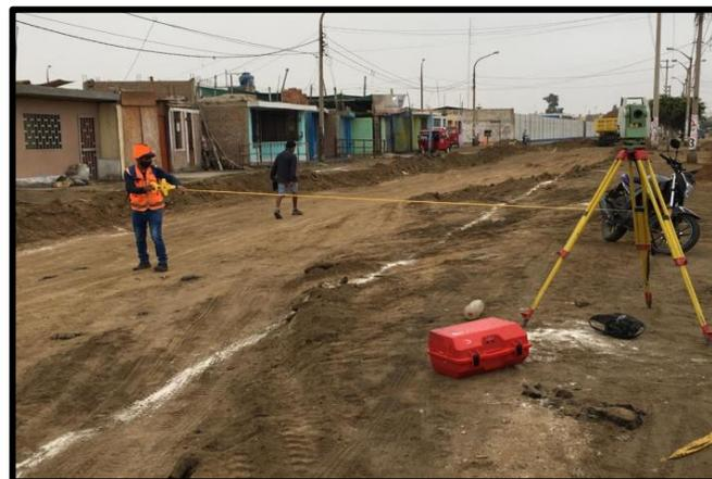
**Paso 2)** Se verifica colocación sobre el terreno, las medidas y ubicación de todos los elementos que se encuentran involucrados en sus niveles y alineamientos, estableciendo marcas y señales fijas en referencia. Se utilizaron wincha y cal.
