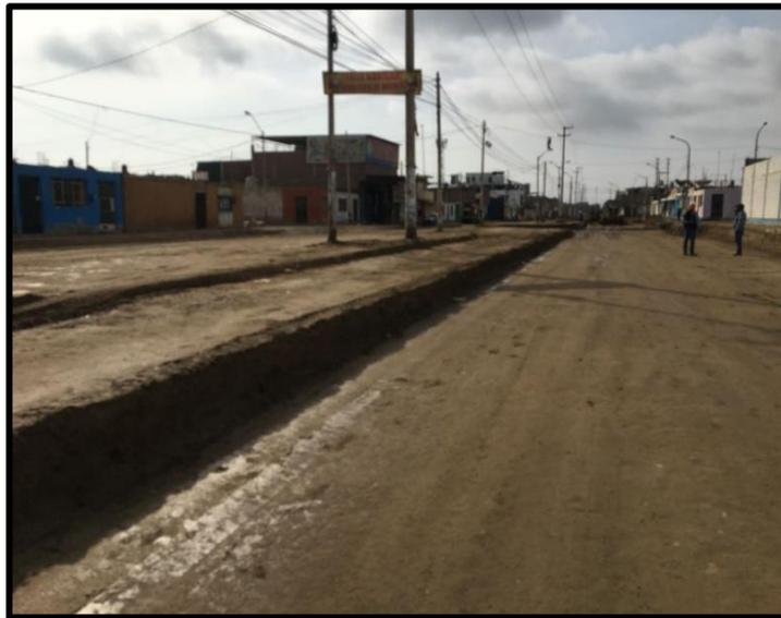
**Paso 3)** Se procede a realizar los ensayos de compactación – densidad de campo, para verificar grado de compactación en sub base1 y sub base 2.
