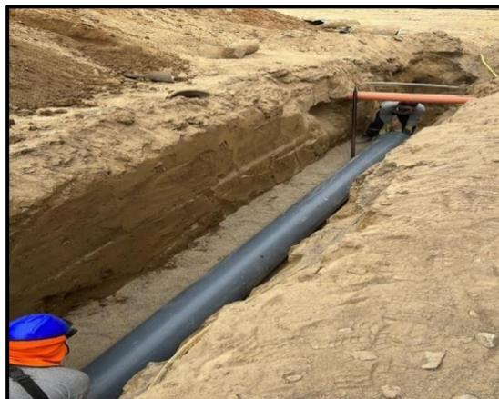
b) Especificaciones técnicas – Suministro e instalación tubería PVC – UF ISO 145 C-7.5
