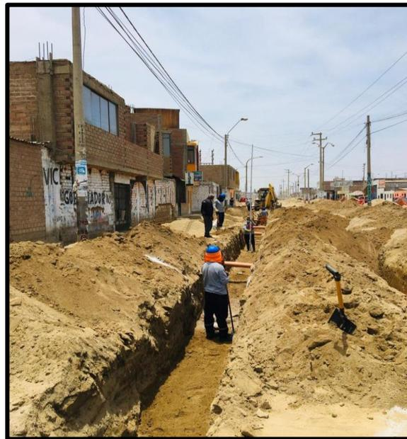
**Paso 2)** Se verifica la colocación de cama de arena con el fin de mejorar el fondo de zanja e= 0.10 m, se extendió el material seleccionado hacia los costados de la tubería, se verificó que el fondo de zanja sea constantemente plano.
