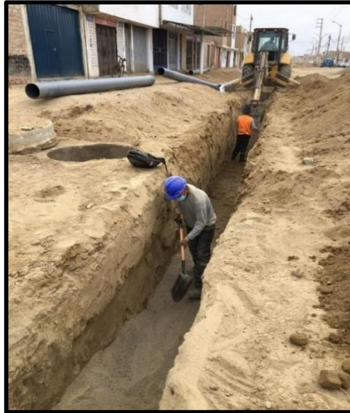
**Paso 2)** Se verifica y controla el perfilamiento de las paredes de fondo de la excavación, quedando seco y firme para proceder a la colocación de tubería de red troncal de diámetro 315 mm.
