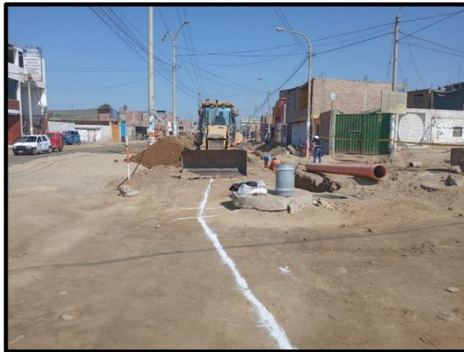
**Paso 2)** Se verifica colocación sobre el terreno, las medidas y ubicación de todos los elementos que se encuentran involucrados en sus niveles y alineamientos, estableciendo marcas y señales fijas en referencia. estableciendo marcas y señales representativas usando, tizas, cal, wincha.
