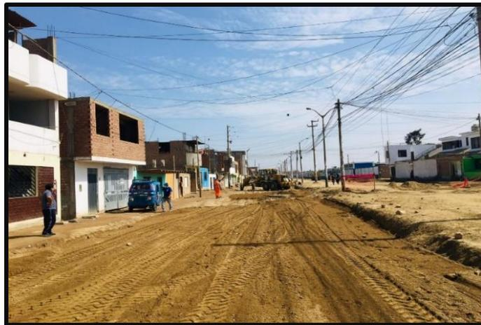
**Paso 2)** Se verifica el suministro, transporte, colocación y compactación de sub base (1era capa y 2da capa) conforme al alineamiento, dimensiones aprobadas en subrasante.
