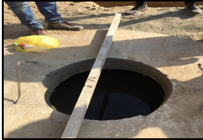
**Paso 2)** Se adjunta Protocolo de control de calidad - Prueba Hidráulica en red troncal de alcantarillado 355 mm, y se verifica y controla la correcta ejecución de dicha partida.
