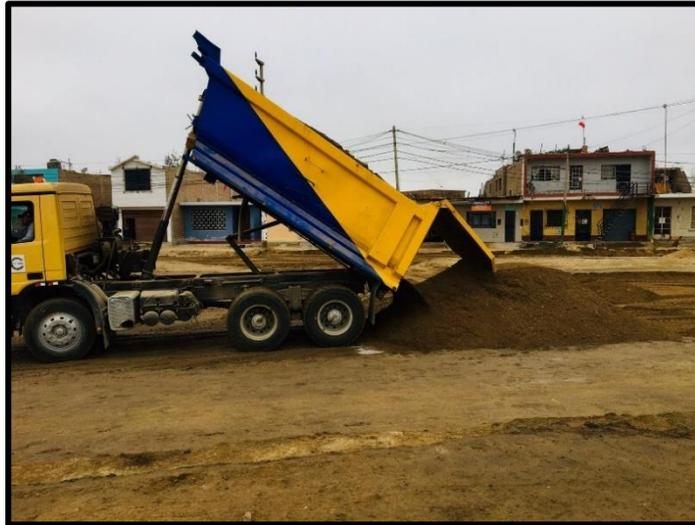
**Paso 5)** Se verifica el suministro, transporte, colocación y compactación de base en ciclovía, conforme al alineamiento, dimensiones aprobadas en subrasante.
