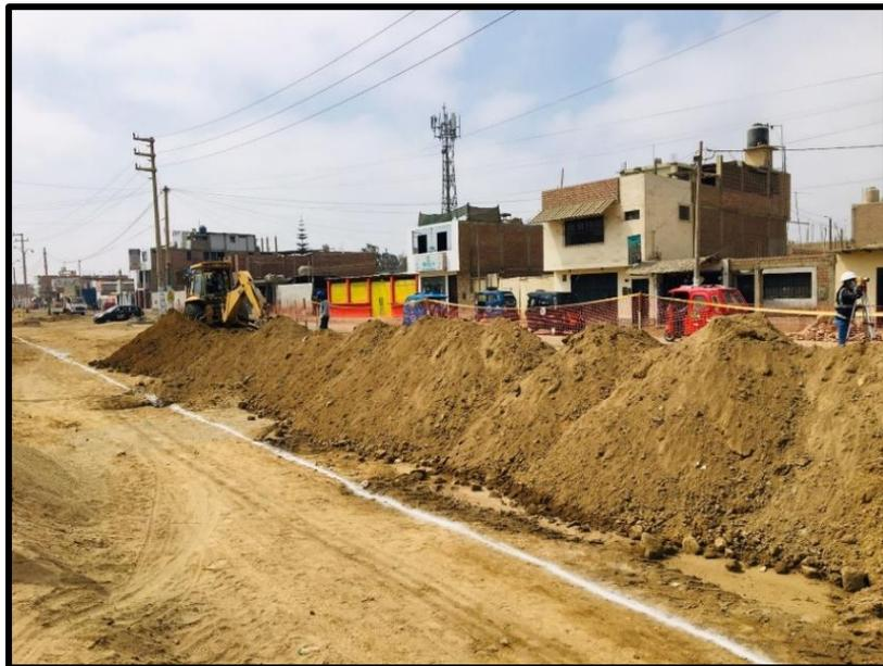
**Paso 2)** Se verifica que, al terminar los trabajos de excavación, se controla la limpieza y conformación de zonas laterales de la vía, controlando que dichas excavaciones sean acordes al trazo del proyecto, se procedió a realizar trabajos de excavaciones con retroexcavadora marca CAT. Dicha excavación tenía una profundidad de 1.50 m.
