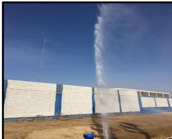
**Paso 2)** Se adjunta Protocolo de control de calidad de Prueba Hidráulica de red troncal de agua 315 mm, verificando y controlando la ejecución de las mismas.
