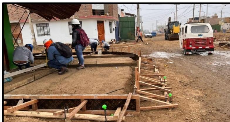
**Paso 2)** Verificación de alineamiento y nivelación en paneles (encofrado) para veredas, que se encuentre sobre el trazo correspondiente. Se consideró un equipo (nivel) y cordel correspondiente utilizado por el topógrafo y tres ayudantes para corroborar la nivelación y alineación así poder evitar errores.
