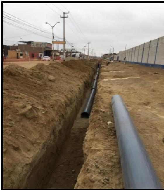
**Paso 2)** Se verifica el suministro y colocación de tubería red troncal de agua 315 mm y desagüe de 355 mm.
