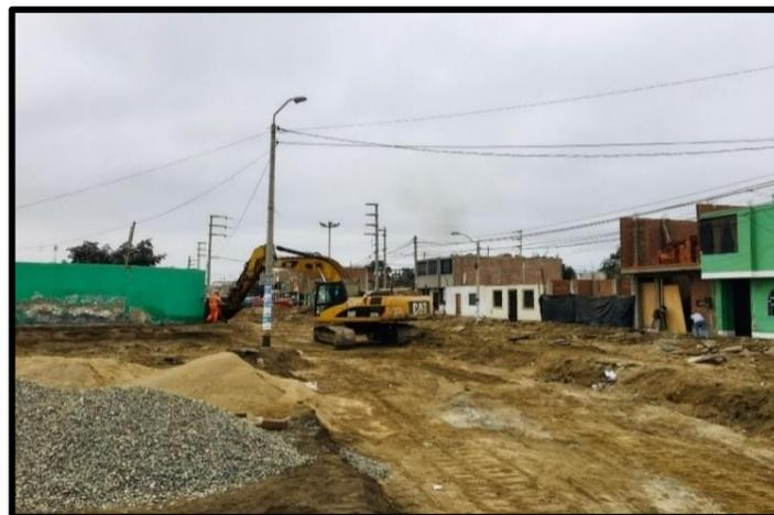
**Paso 3)** Se verifica alineamiento, perfil y compactación de sección de las áreas excavadas para llegar a nivel de subrasante.
