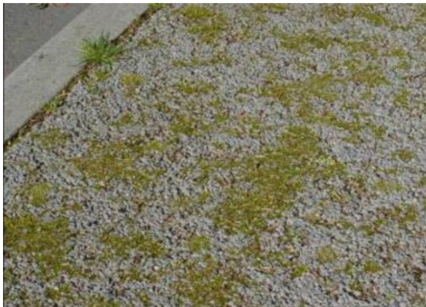
Taponamiento de concreto poroso
