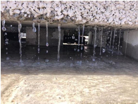
Funcionalidad del concreto poroso
