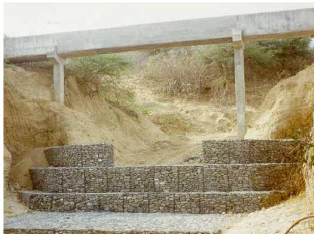
**Figura 25.** Control de sedimentos mediante dique de gaviones en una quebrada
