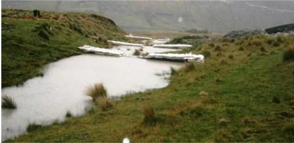
**Figura 15.** Fotografía de check dam con vertederos
