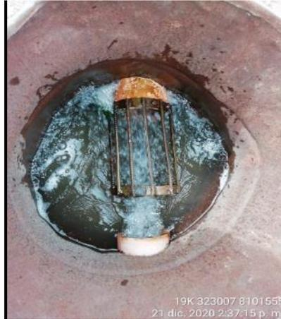
**Figura 38.** Desarenador de Comunidad – Aguas debajo de puente Capillune
