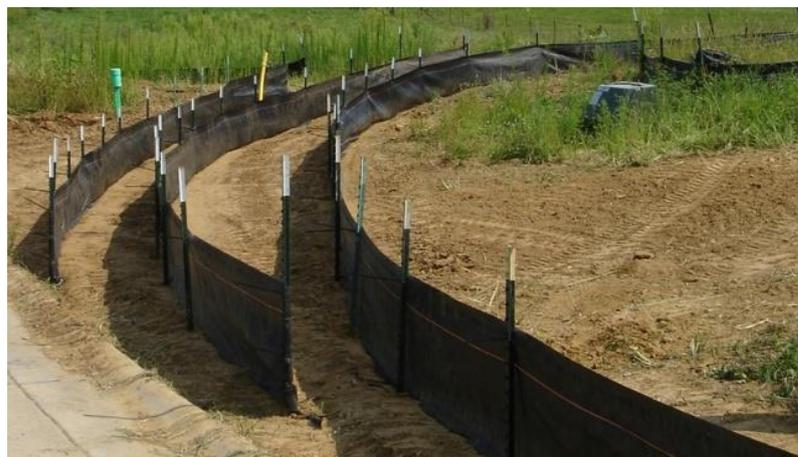
**Figura 19.** Ejemplo de uso de silt fence en forma de luna
