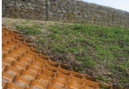
**Figura 20.** Vista de uso de geoceldas para prevención de generación de erosión o cárcavas.
