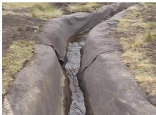
**Figura 9.** Zanja de coronación trapezoidal con una capa de geosintético
