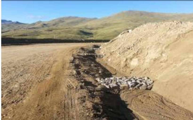
**Figura 13.** Fotografía de aplicación de control ambiental check dam para canales en vía de acceso.
