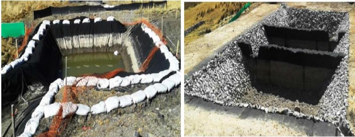
**Figura 24.** Fotografías de implementación de pozas de sedimentación, donde se observa que la entrada y salida de las pozas se encuentran en sentido opuesto para aumentar el tiempo de retención.
