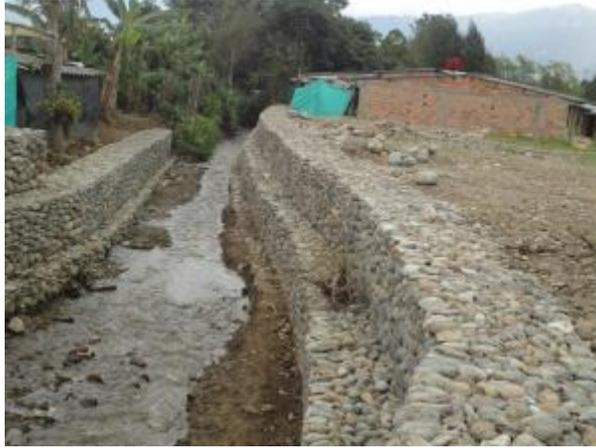
**Figura 26.** Control de erosión mediante construcción de gaviones en el talud.
