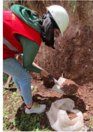
Extracción del suelo limoso
