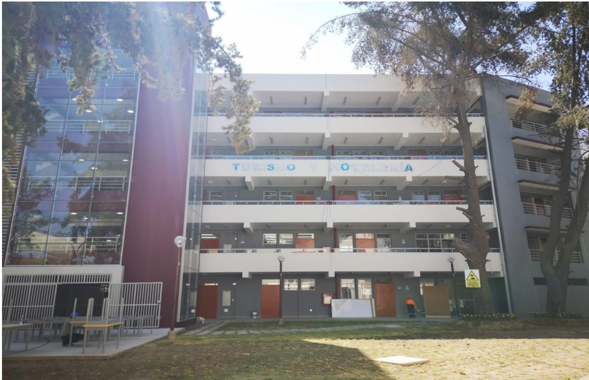
Figura N° 88: Obras exteriores con la estructura.
