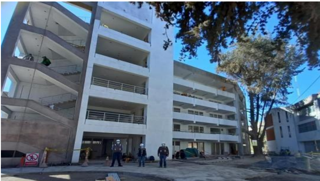
Figura 19: Equipo de supervisión con coordinadora de obra.
