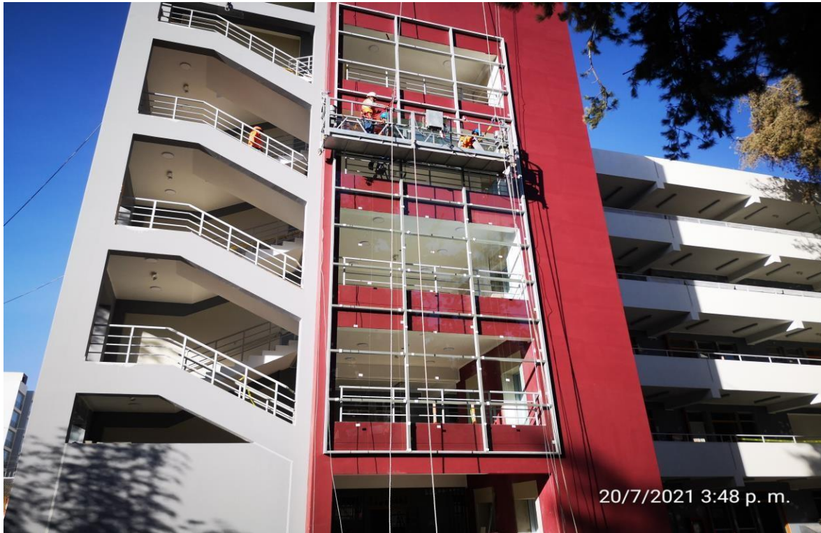
Figura N° 84: Estructura en colocado de cortina de vidrios.
