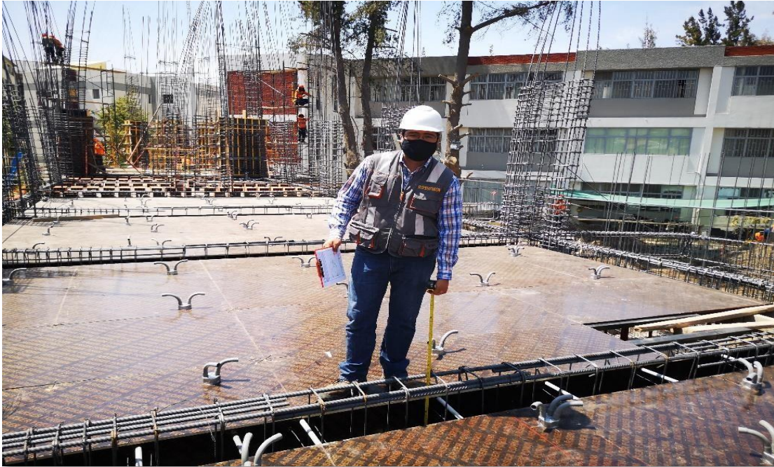
Figura 4: Control de espaciamientos de acero en vigas.
