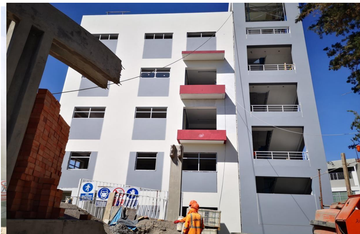
Figura N° 79: Estructura en proceso de pintado.
