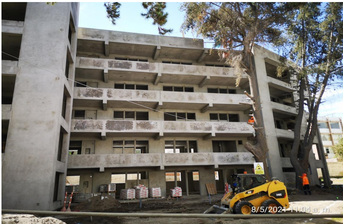
Figura N° 78: Estructura en proceso de pintado.
