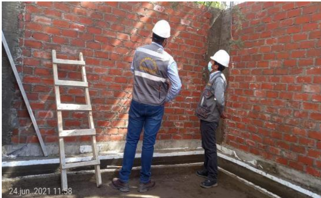
Figura 17: Presencia de especialista de instalaciones eléctricas de supervisión.
