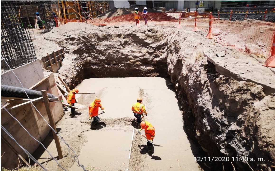
Figura N° 54: Vaciado de concreto en zapatas y solados.
