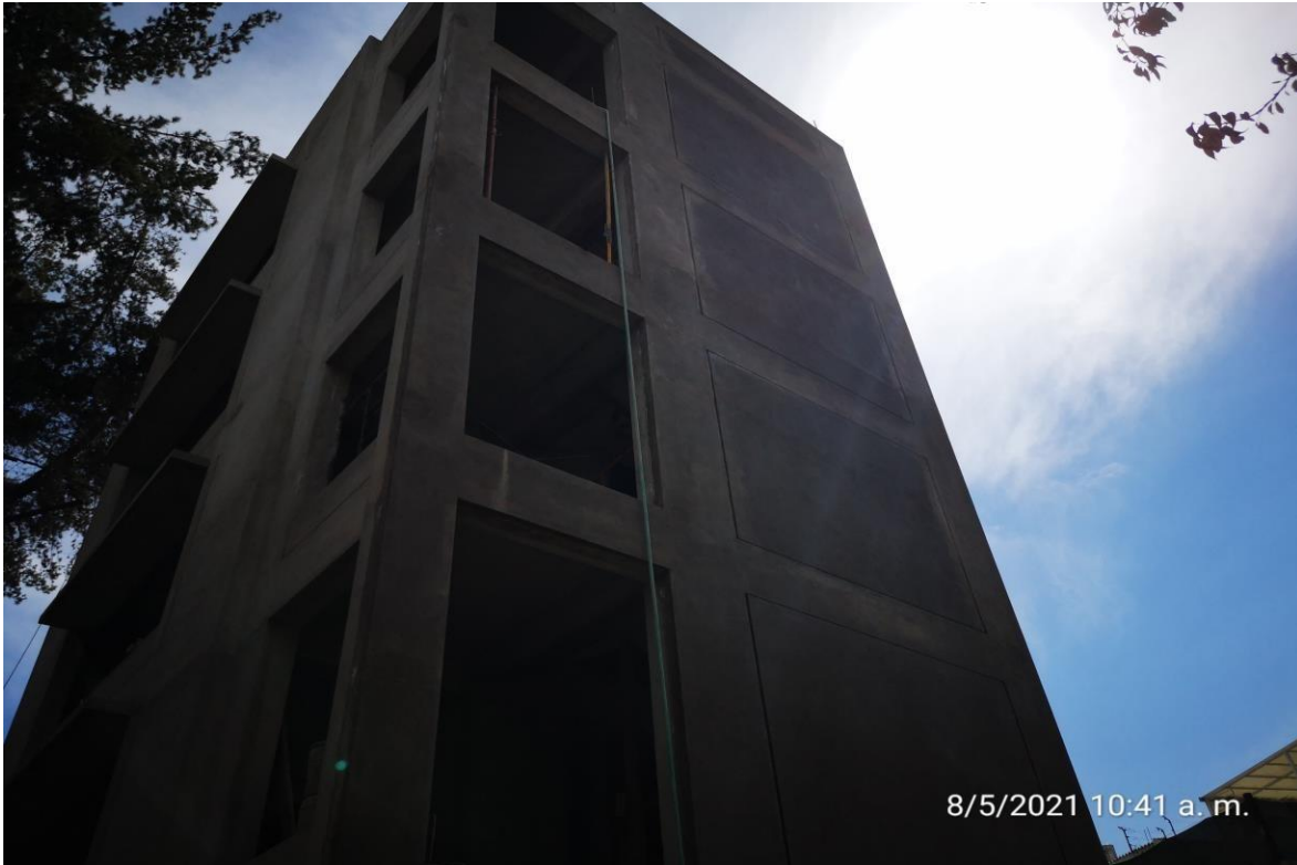
Figura N° 76: Caja de servicios higiénicos en casco gris.
