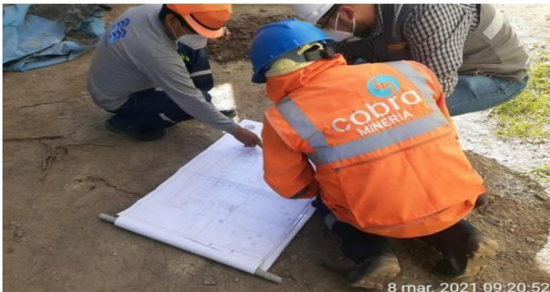
Figura 15: Replanteo en obra.
