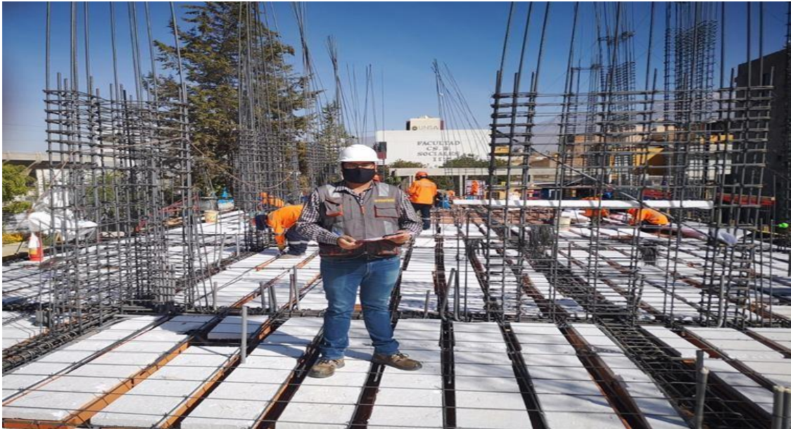
Figura 14: Verificación de losa aligerada.
