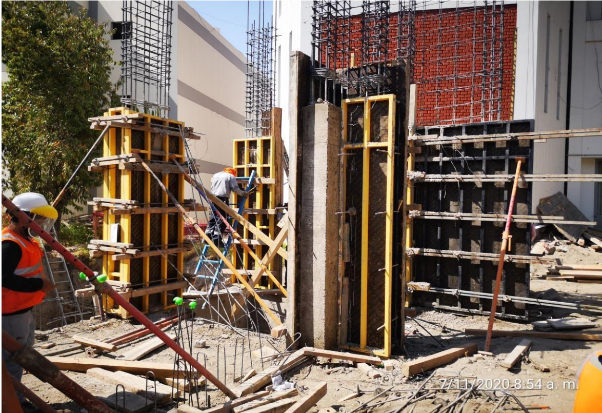
Figura N° 56: Encofrado de elementos estructurales placas y columnas.
