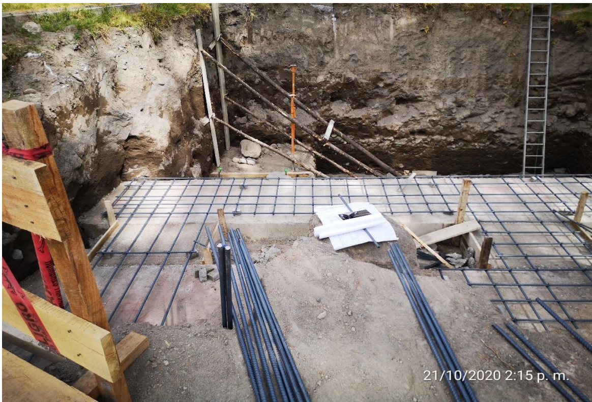
Figura N° 53: Armado de acero para zapatas.
