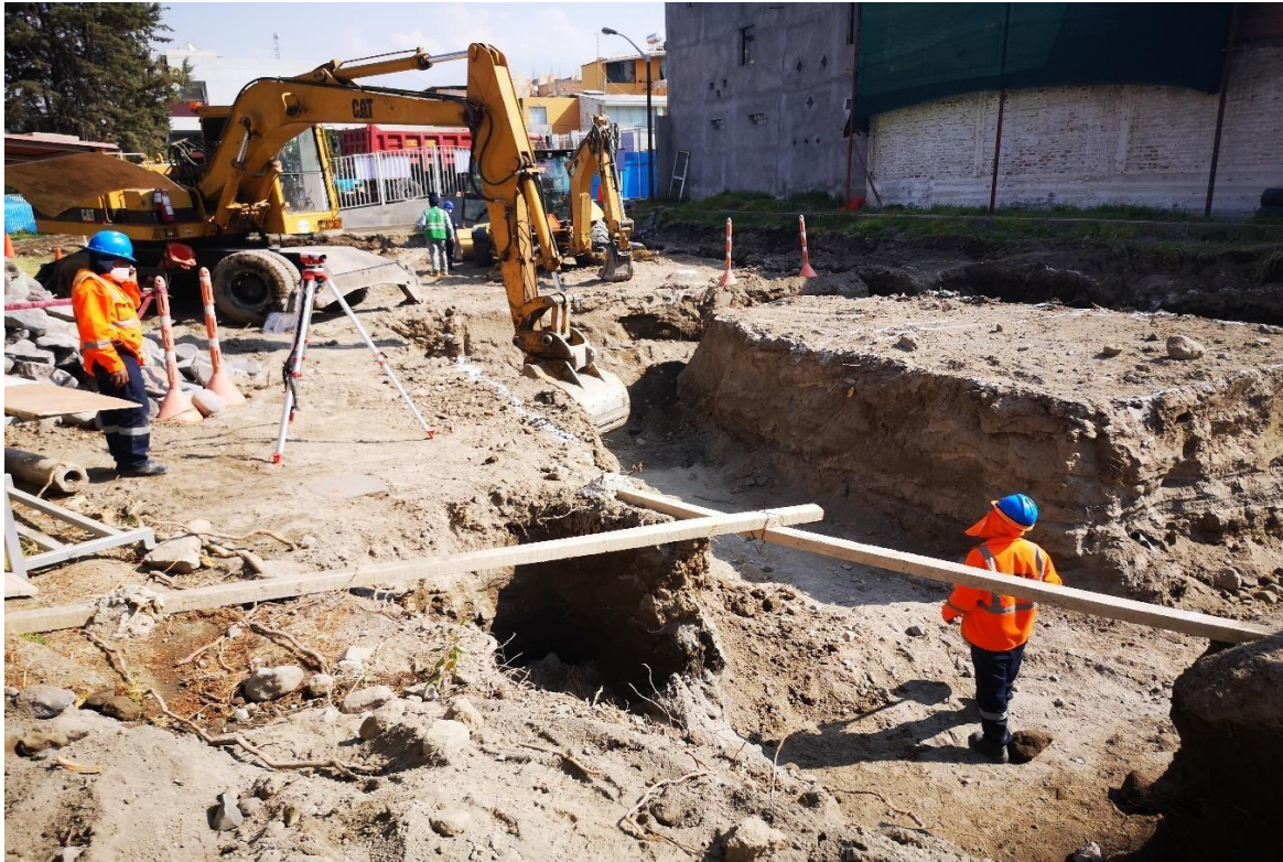
Figura N° 52: Excavaciones para zapatas y cimentación.
