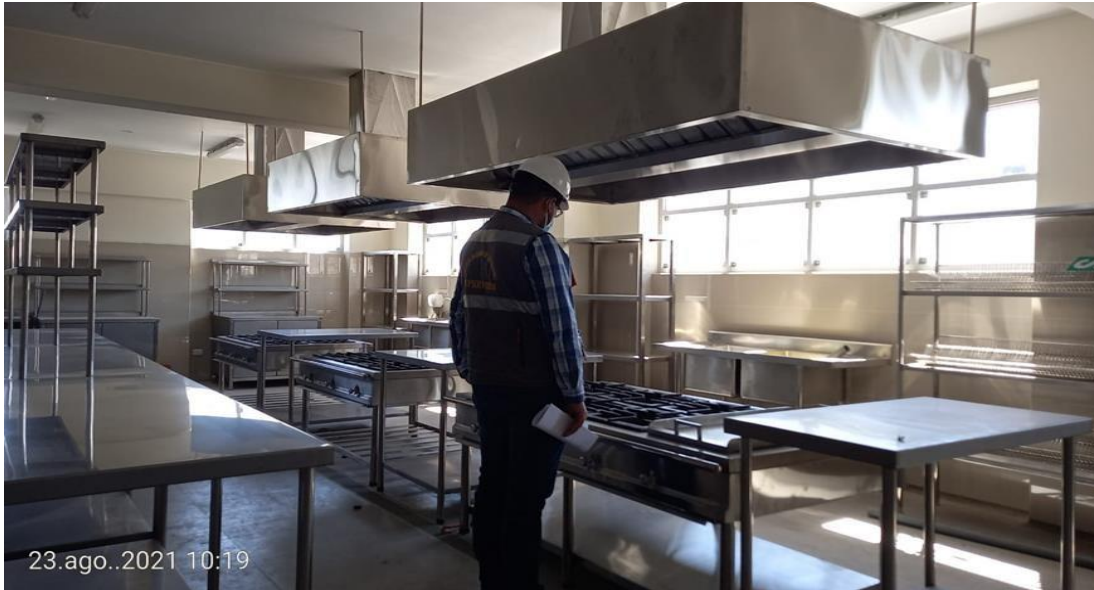
Figura 24: Verificación de equipamiento en módulo de gastronomía.
