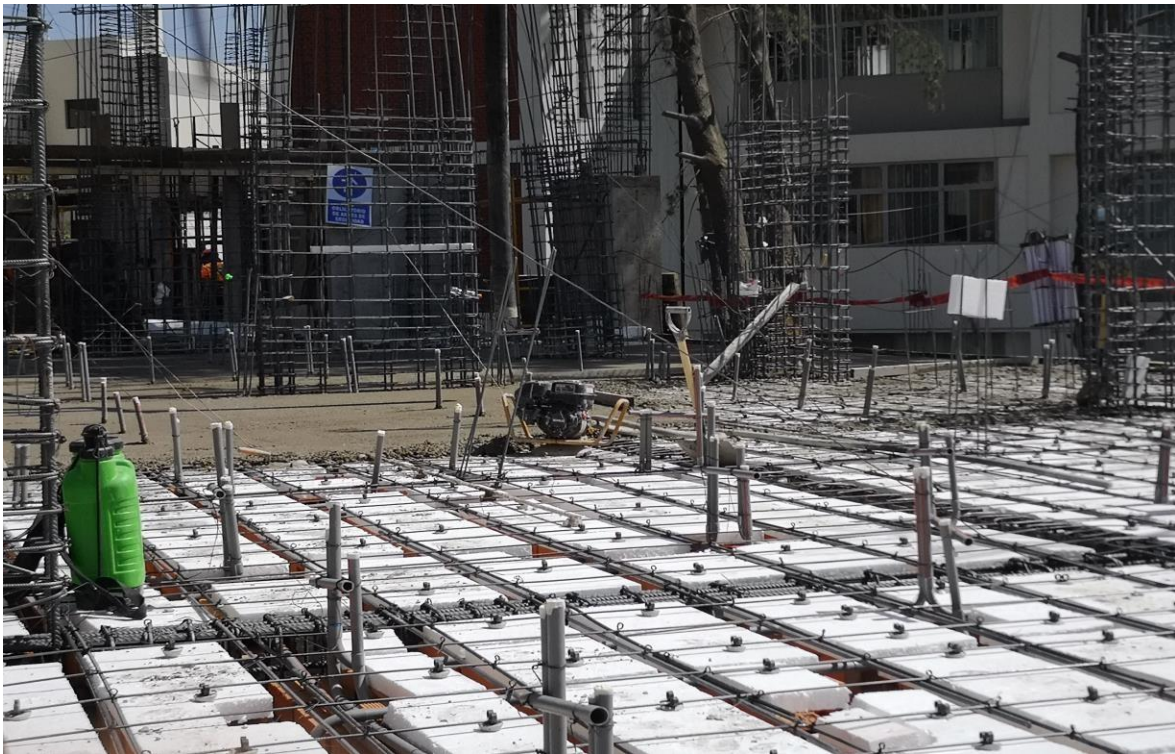
Figura N° 59: Vaciado de losa aligerada.
