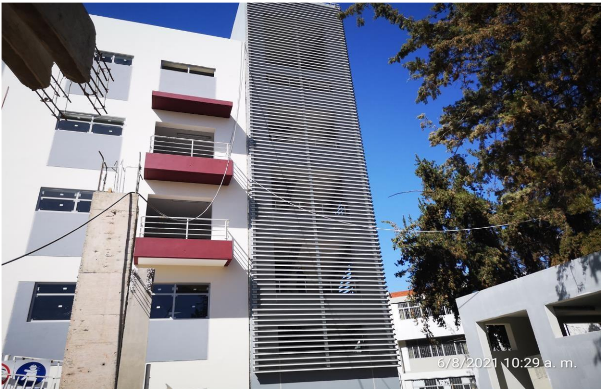
Figura N° 87: Lado lateral con celosía instalada.
