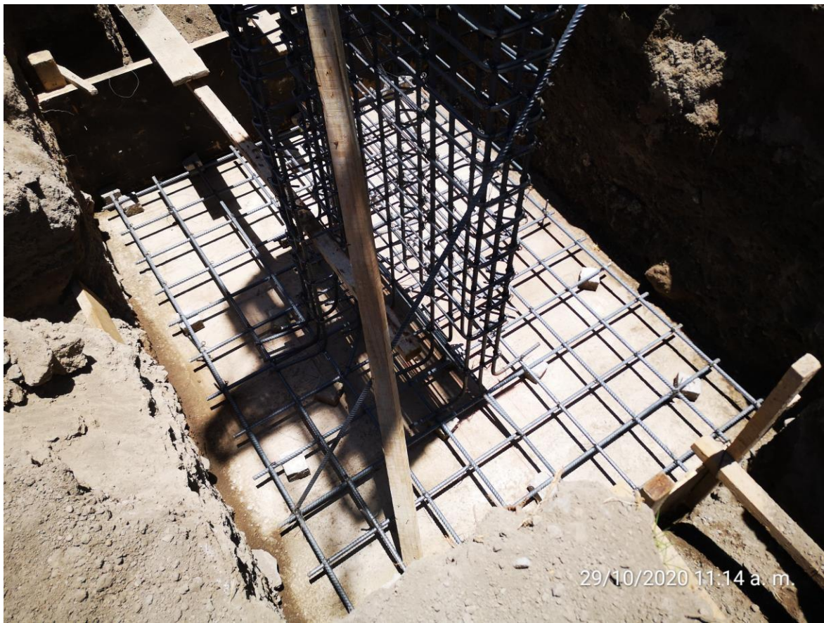
Figura N° 55: Acero en zapatas y columnas
