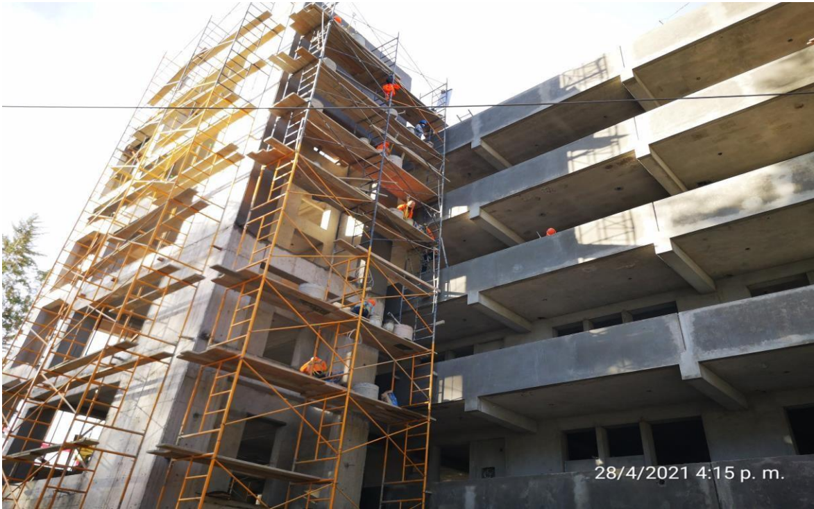
Figura N° 74: Estructura de 5 pisos en casco gris.
