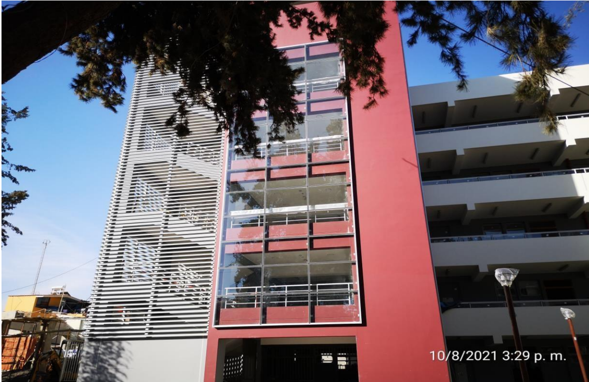
Figura N° 86: Estructura con cortina de vidrio e instalación de celosía.
