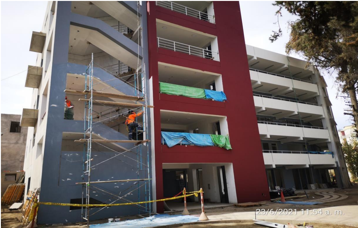
Figura N° 80: Pintado en parte lateral de estructura.
