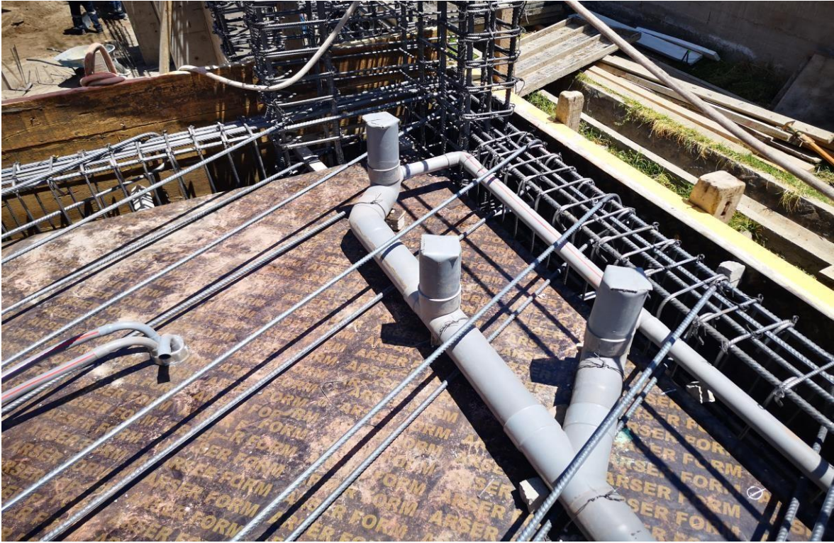
Figura N° 58: Instalaciones sanitarias en losa aligerada.
