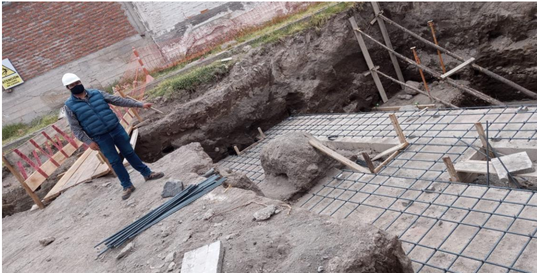
Figura 18: Zapata combinada en tanque cisterna.
