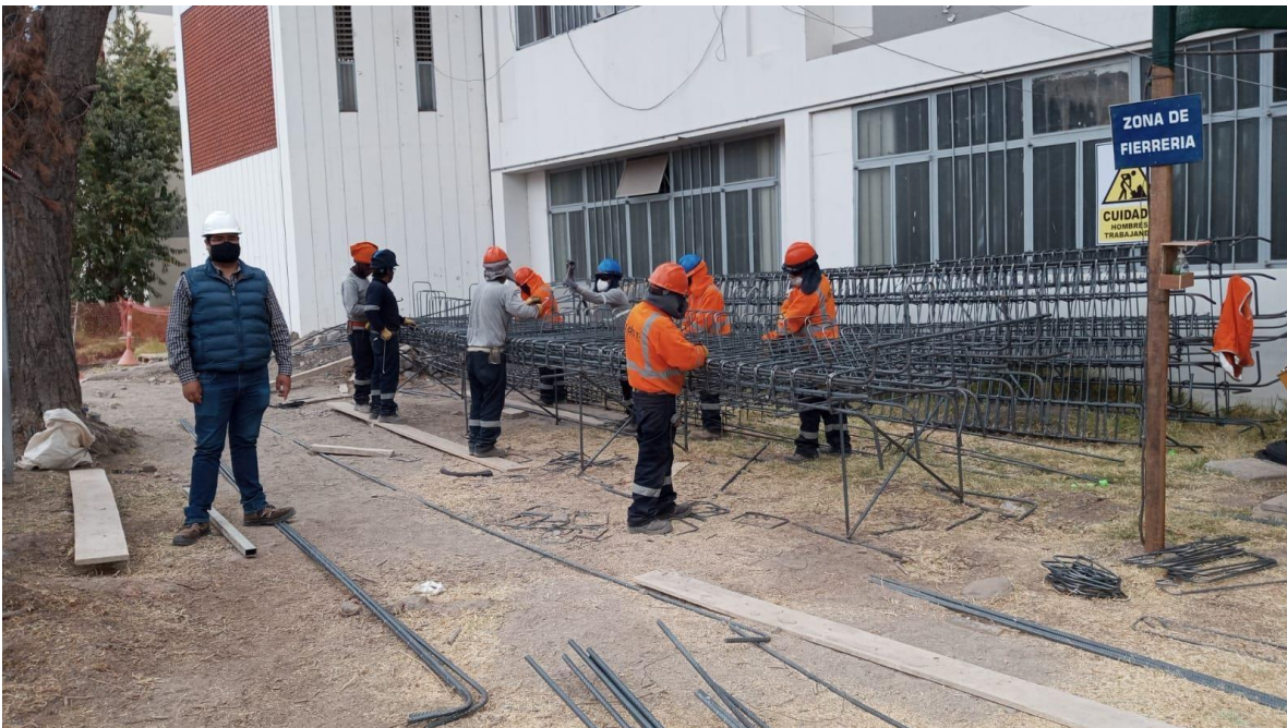
Figura 27: Habilitación de acero en columnas y placas.
