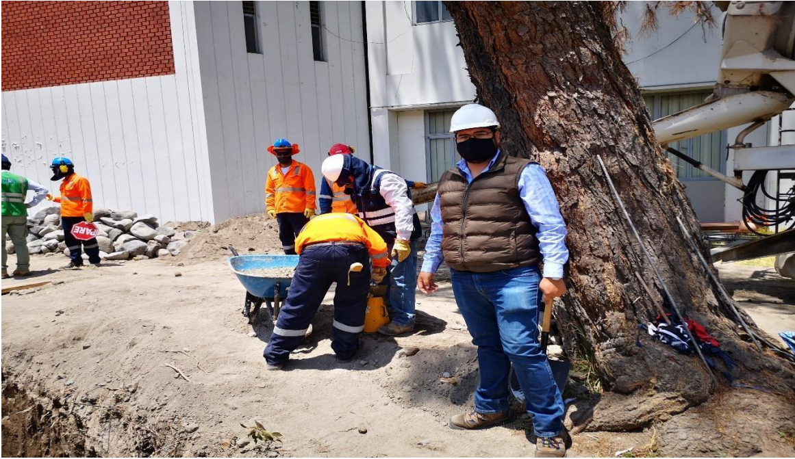
Figura 26: Control de concreto.
