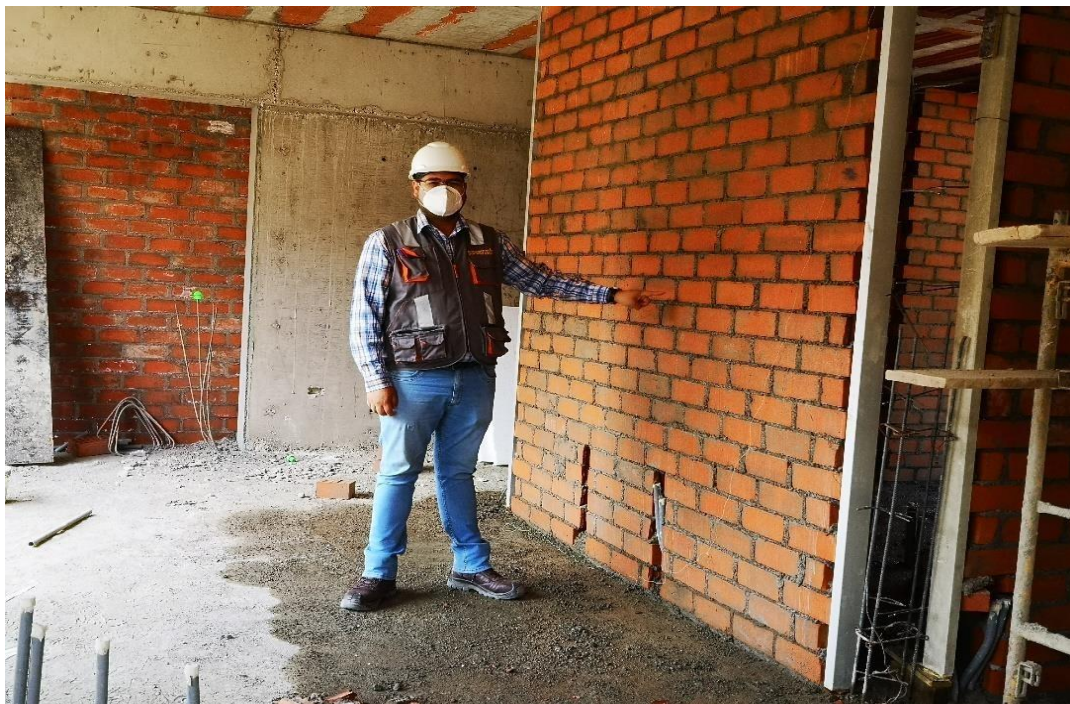
Figura 7: Muros de albañilería.
