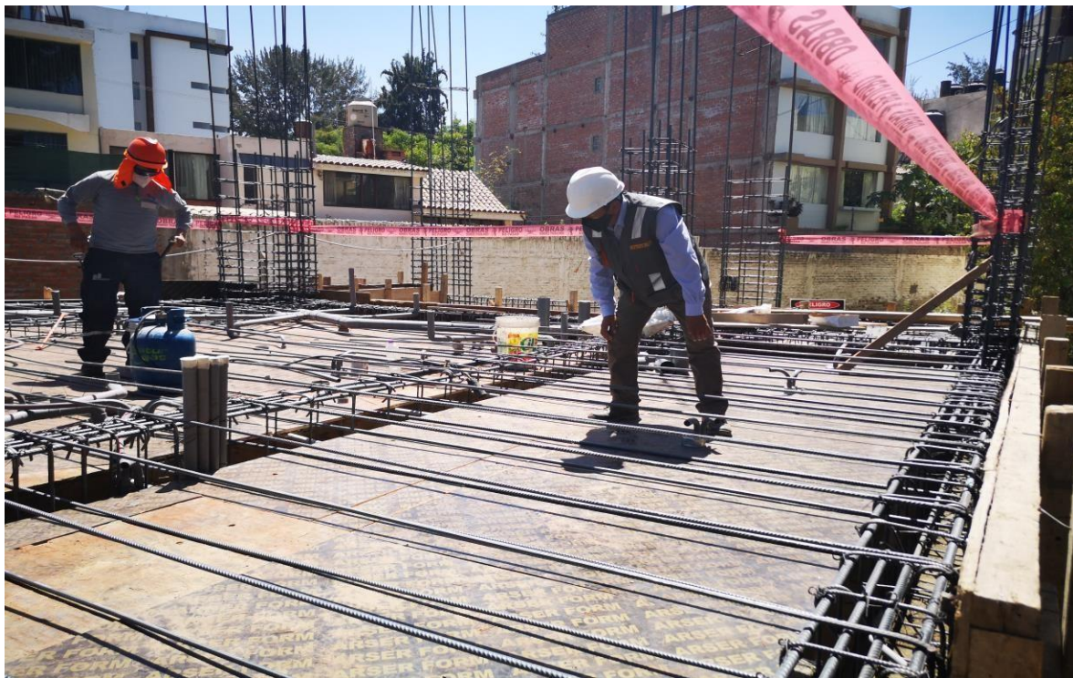
Figura N° 57: Armado de losa aligerada.
