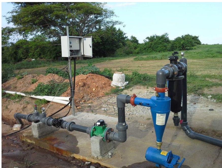
Figura 8. Cabezal de Riego
