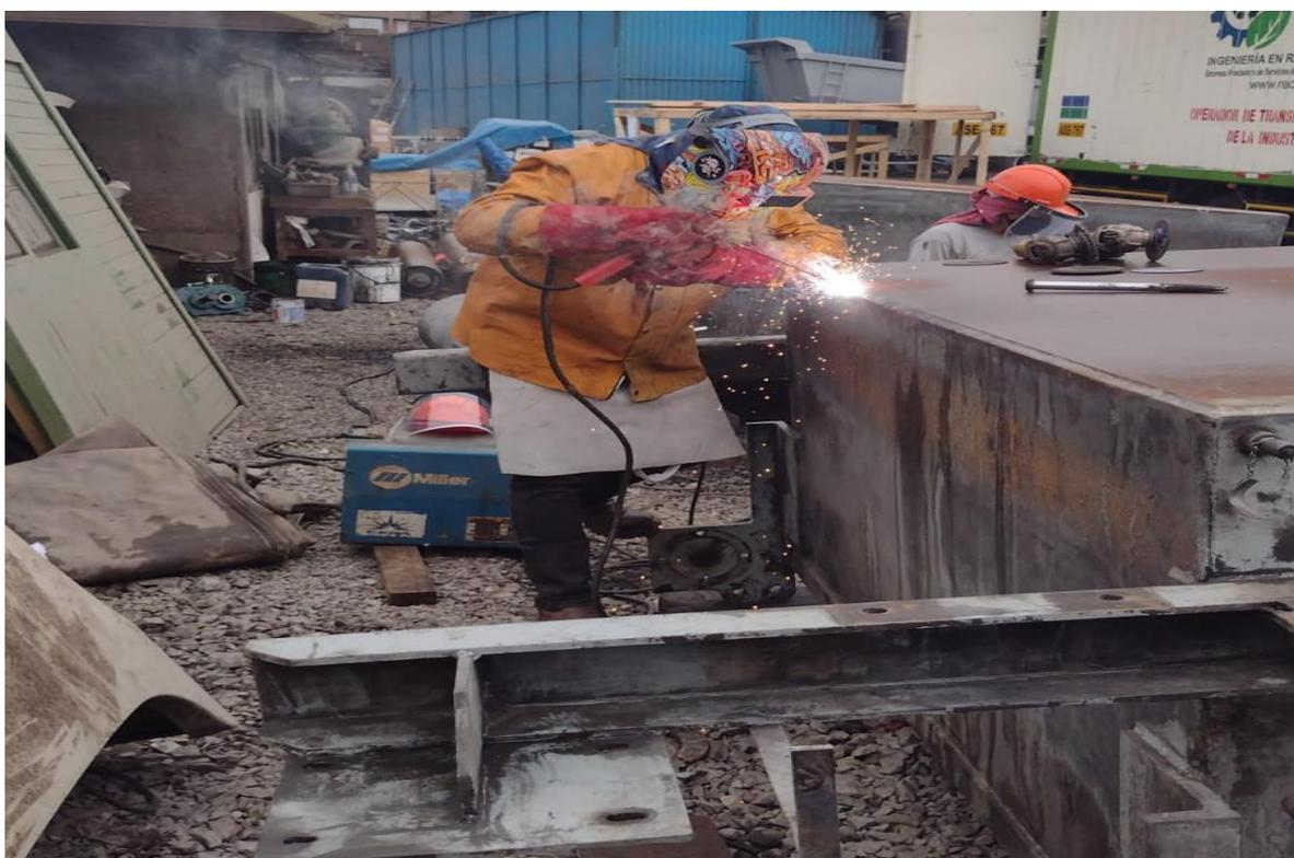
*Figura 23. Soldadura de reparación de las cajas Eriez
