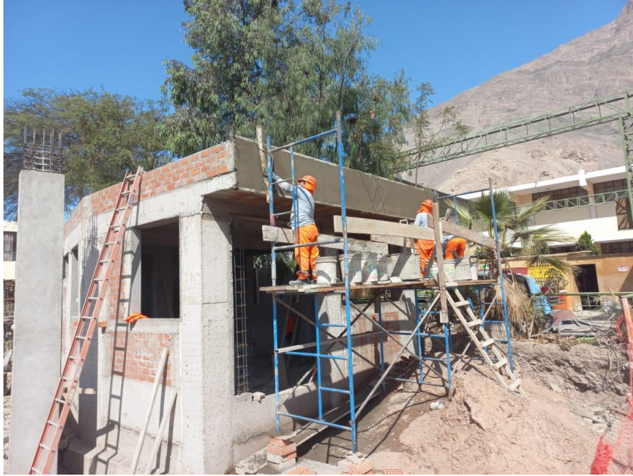
Figura 74. Vista fotográfica de tarrajeo de cielorraso y vigas en el bloque 05.
