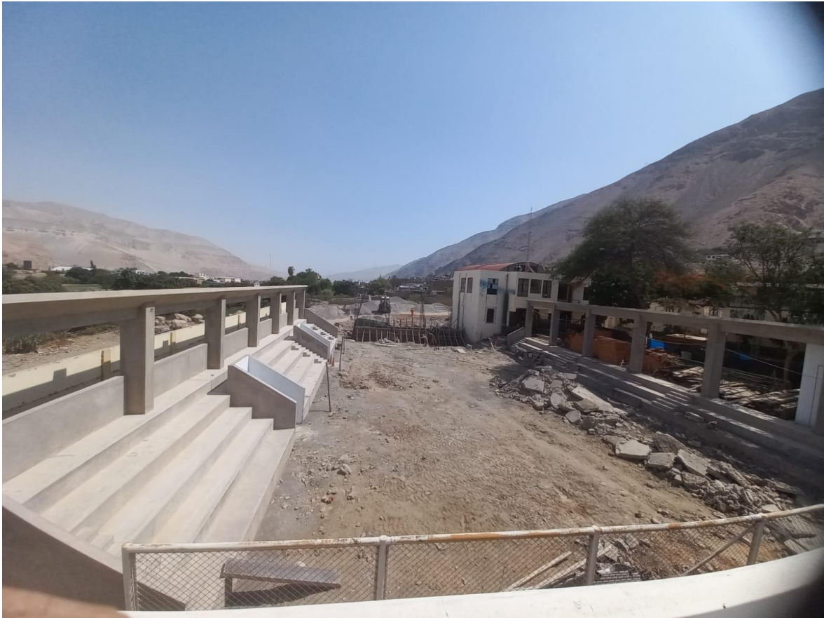
Figura 109. Vista fotográfica de avance realizado en el bloque 06 – losa deportiva.
