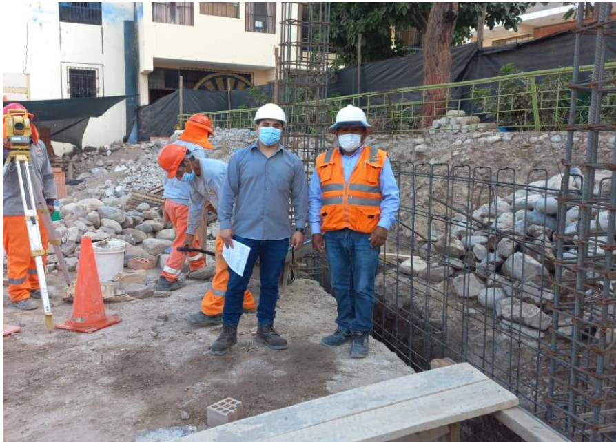
Figura 80. Vista fotográfica de habilitado de acero de muro de contención de gradería 02 en el bloque 06.
