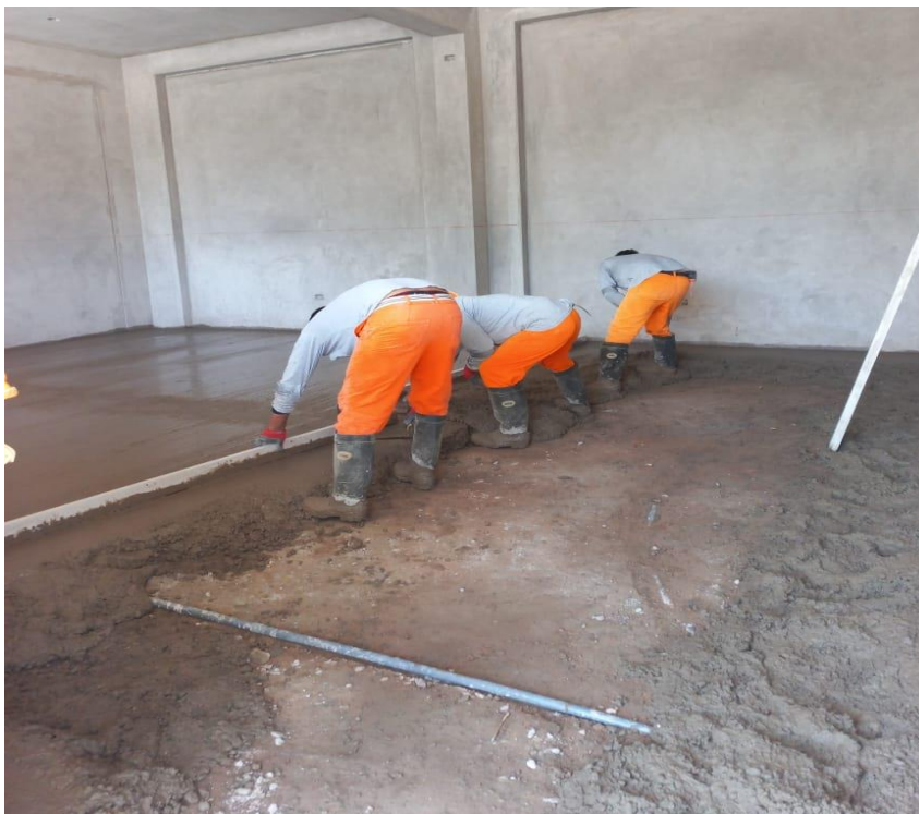
Figura 54. Vista fotográfica de vaciado de falso piso en el bloque 04.
