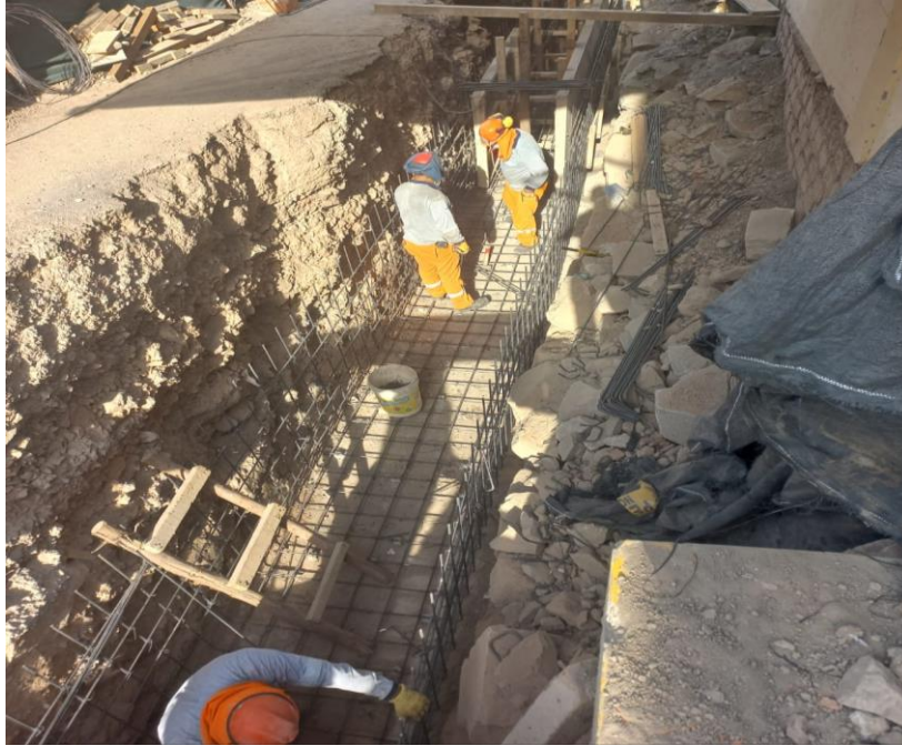
Figura 110. Vista fotográfica de habilitado de acero y encofrado en canal de regadío de concreto cerrado en obras exteriores.
