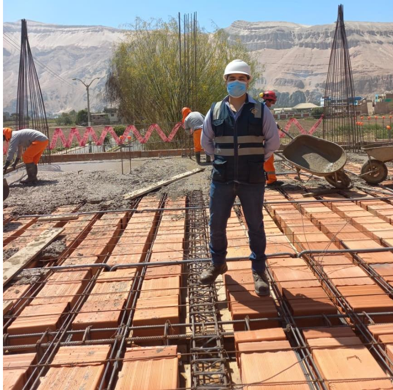
Figura 42. Vista fotográfica de vaciado de concreto f'c 0 210 kg/cm 2 en losa, vigas y viguetas en 2do nivel en bloque 01.
