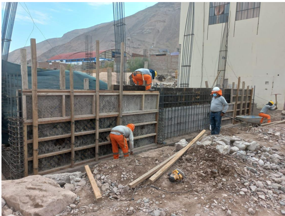
Figura 107. Vista fotográfica de encofrado de muros de contención en gradería 03 – bloque 06.
