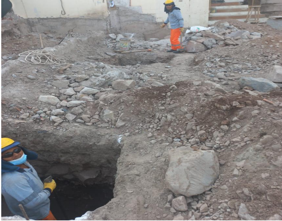
Figura 103. Vista fotográfica de excavación de zapatas en gradería 03 – bloque 06.
