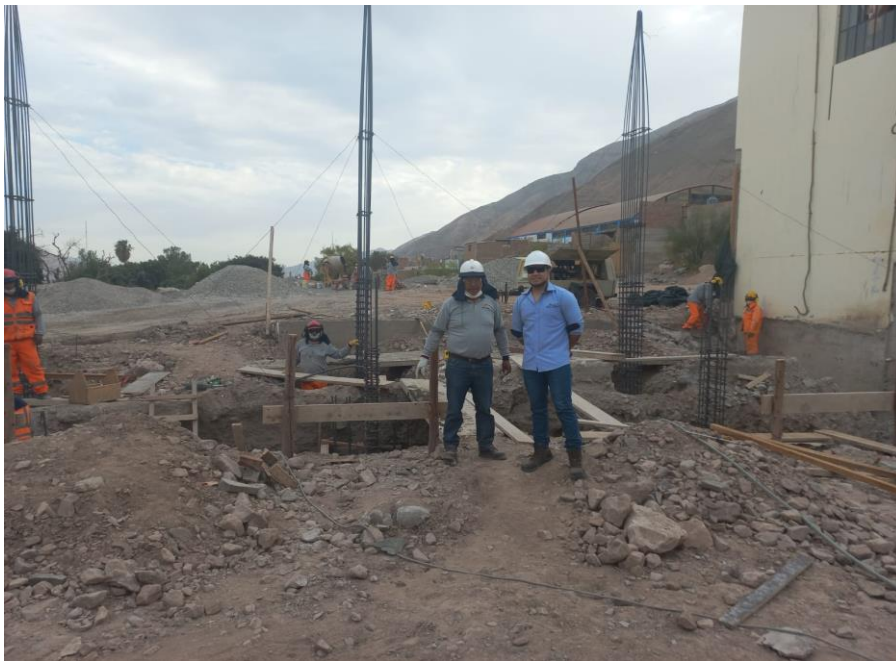
Figura 104. Vista fotográfica de habilitado de acero para columnas gradería 03 – bloque 06.
