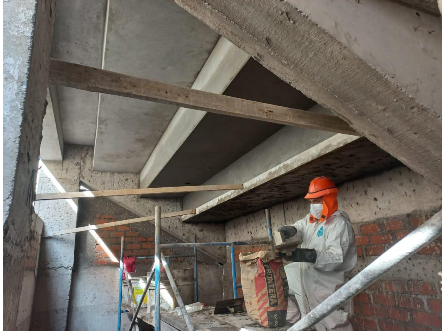
Figura 95. Vista fotográfica de tarrajeo de gradería (cielorraso) de gradería 01 tramo I – bloque 06.
