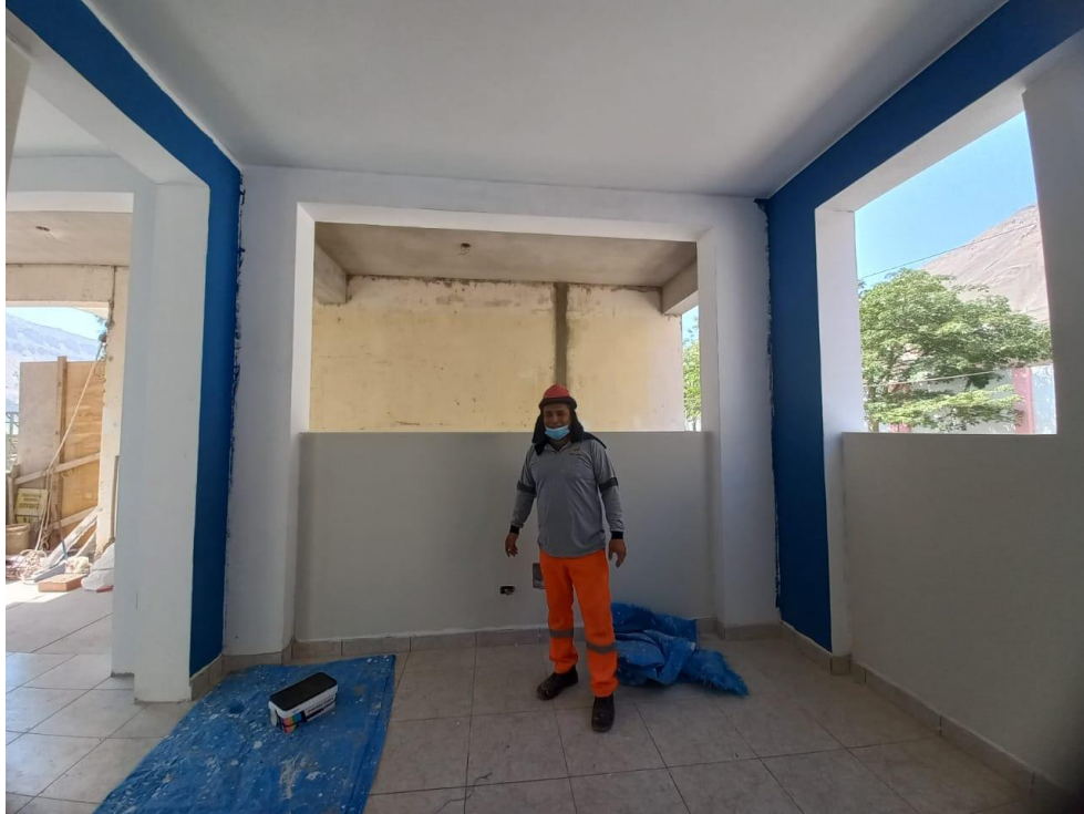
Figura 67. Vista fotográfica de pintura a 2 manos interior en el bloque 04.
