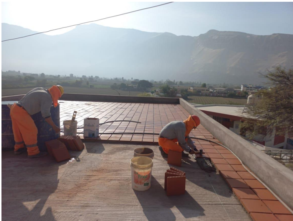
Figura 64. Vista fotográfica de cobertura de ladrillo pastelero en azotea en el bloque 03.
