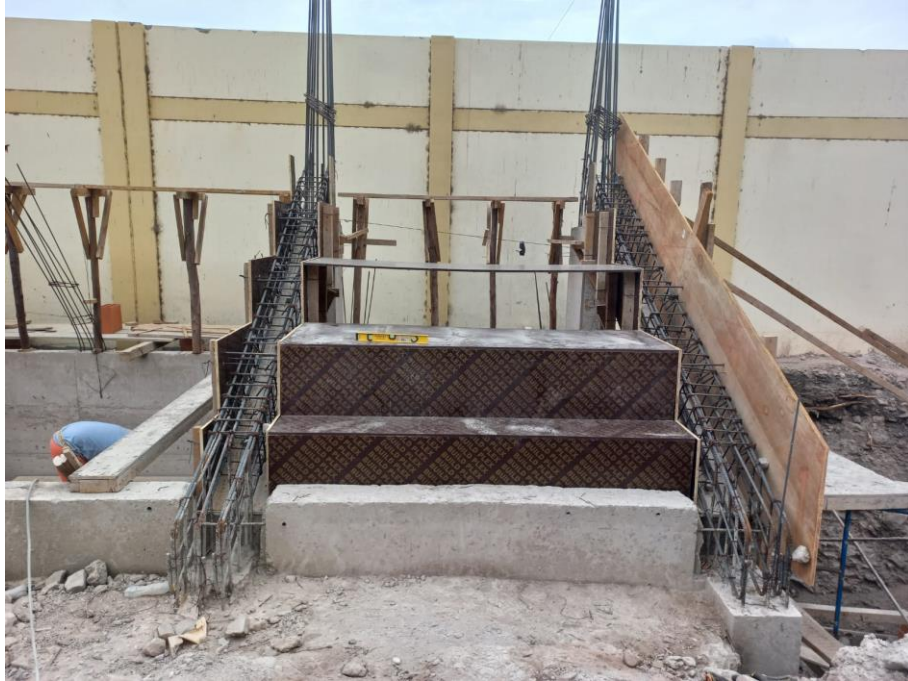
Figura 79. Vista fotográfica de encofrado de graderías y vigas inclinadas en el bloque 06.
