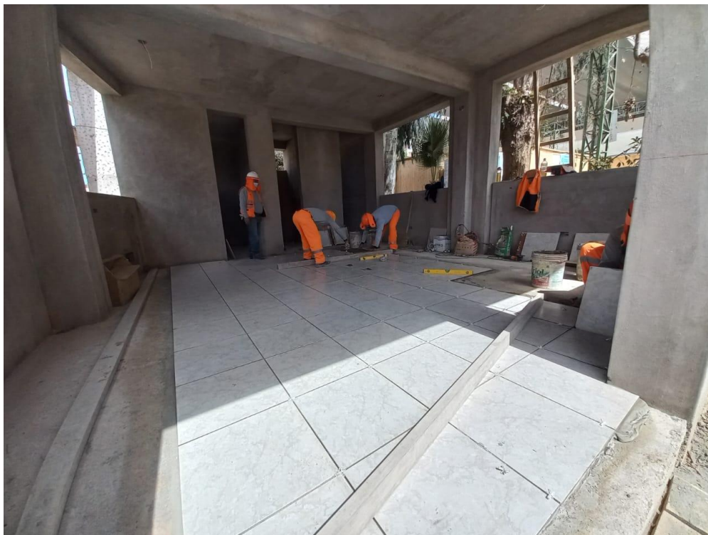
Figura 77. Vista fotográfica de colocado de cerámica en piso en el bloque 05.
