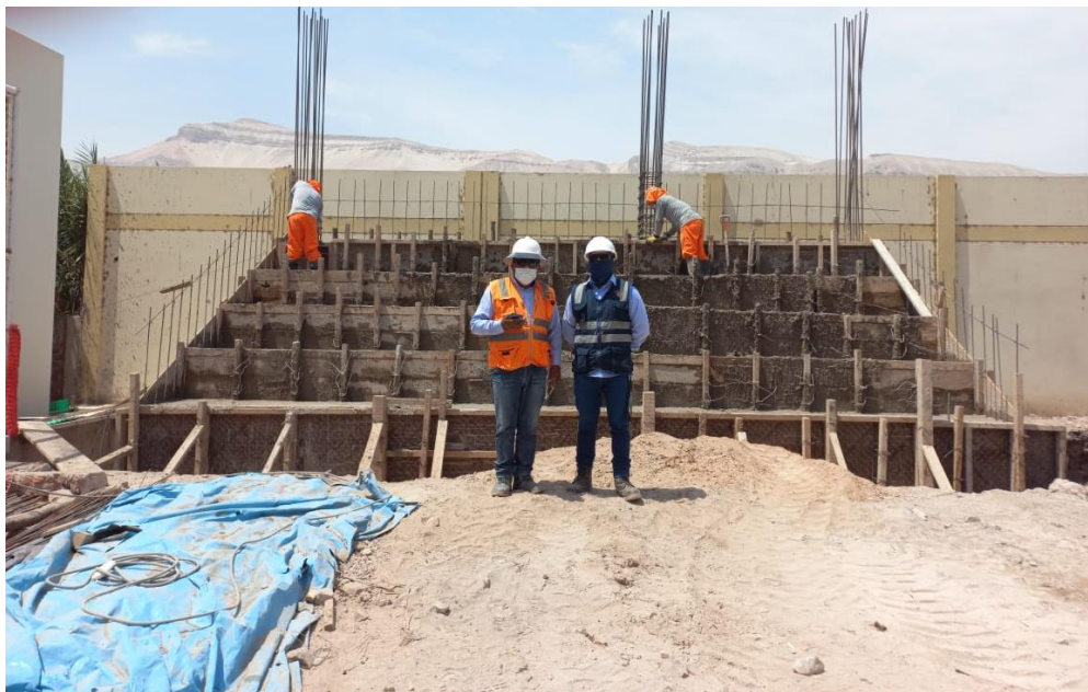
Figura 82. Vista fotográfica de vaciado de concreto en gradería 01 tramo I – bloque 06.
