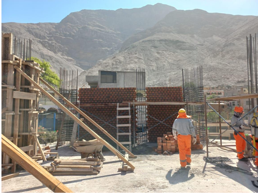
Figura 40. Vista fotográfica de asentado de ladrillo de muro portante, encofrado y vaciado de concreto en columnas del 2do nivel en bloque 01.
