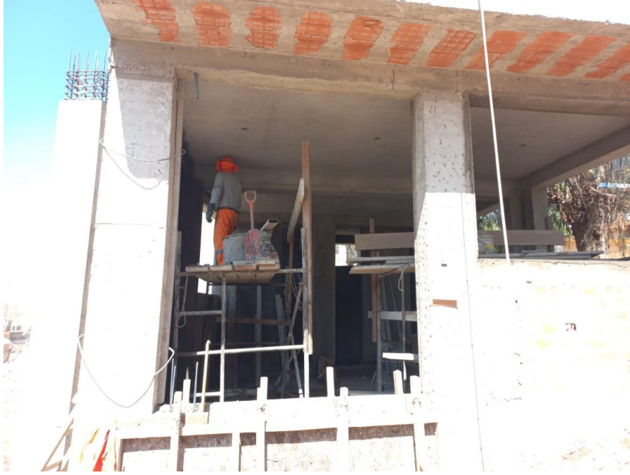
Figura 72. vista fotográfica de tarrajeo de cielorraso y vigas en el bloque 05.
