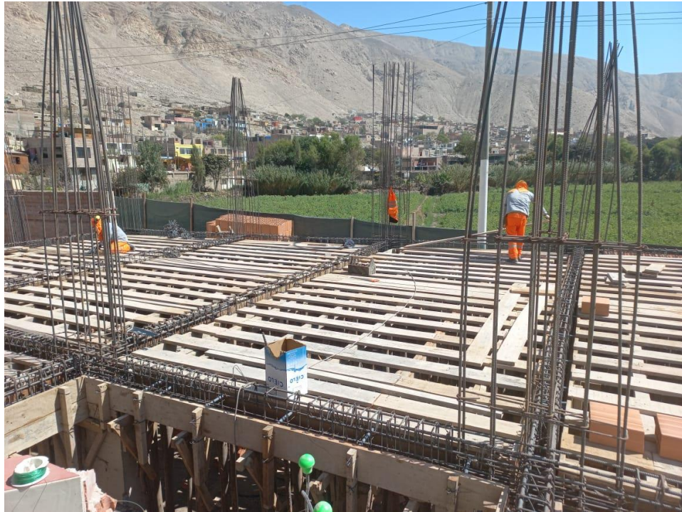
Figura 38. Vista fotográfica de encofrado y habilitado de acero de viguetas para losa de concreto 1er nivel en bloque 01.
