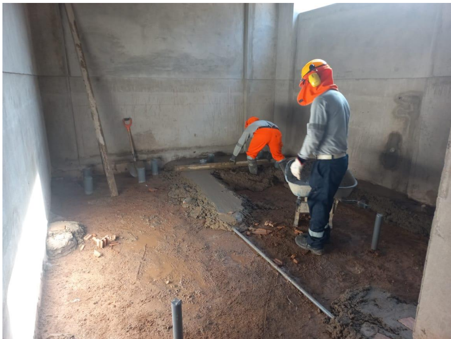
Figura 60. Vista fotográfica de falso piso e instalaciones sanitarias del bloque 04.
