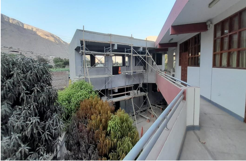
Figura 48. Vista fotográfica de tarrajeo de columnas, vigas y muros exteriores en bloque 01.
