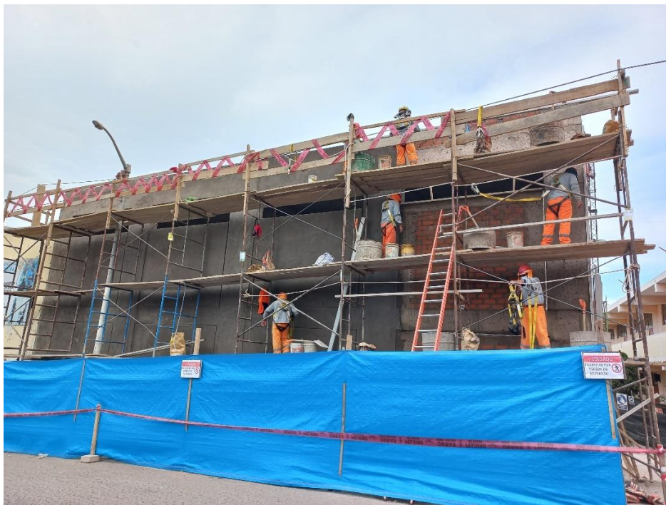
Figura 56. Vista fotográfica tarrajeo exterior de muros, vigas y columnas en el bloque 03.
