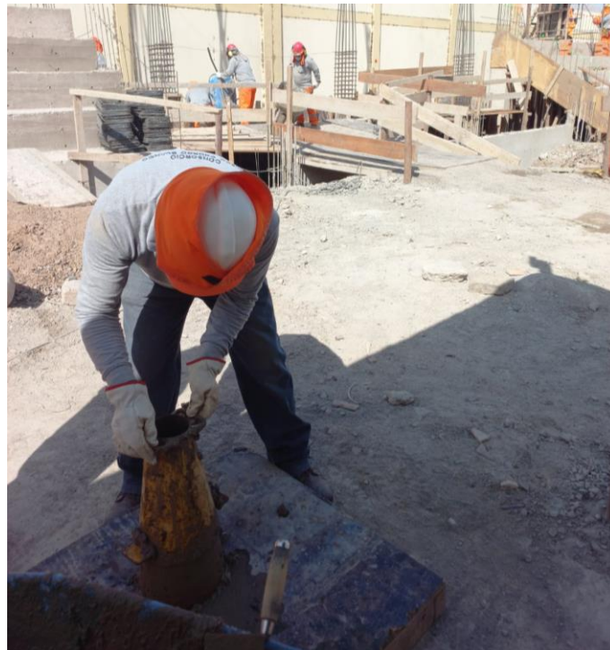
Figura 114. Prueba de Slump en el concreto para verificación de asentamiento.
