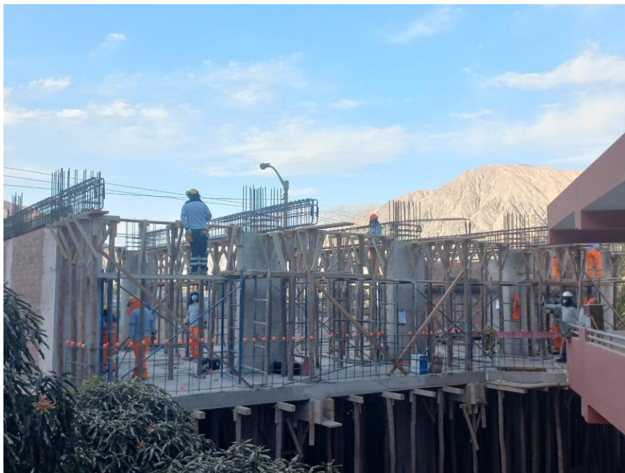
Figura 41. Vista fotográfica de encofrado de losa y viga y habilitado de acero en 2do nivel del bloque 01..
