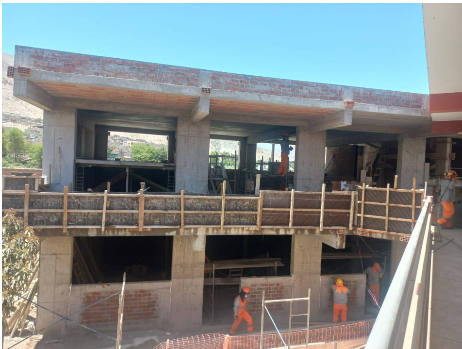
Figura 45. Vista fotográfica de tarrajeo en vigas y cielorraso y encofrado de parapeto de pasadizo en bloque 01.
