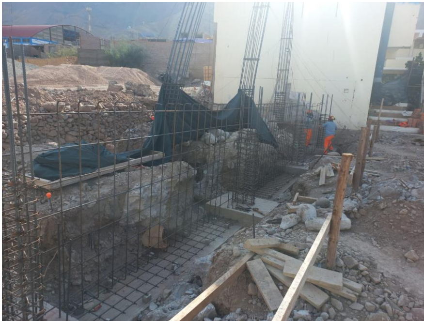
Figura 106. Vista fotográfica de habilitado de acero en muro de contención de gradería 03 – bloque 06.
