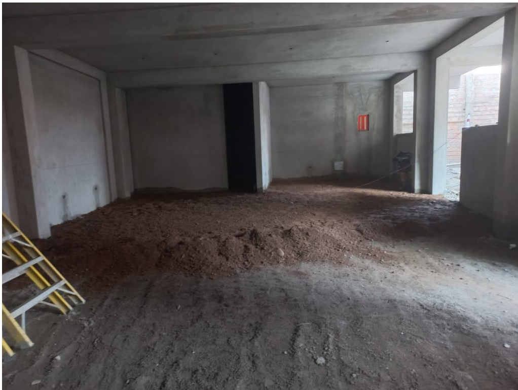
Figura 47. Vista fotográfica de relleno compactado con material seleccionado en bloque 01.
