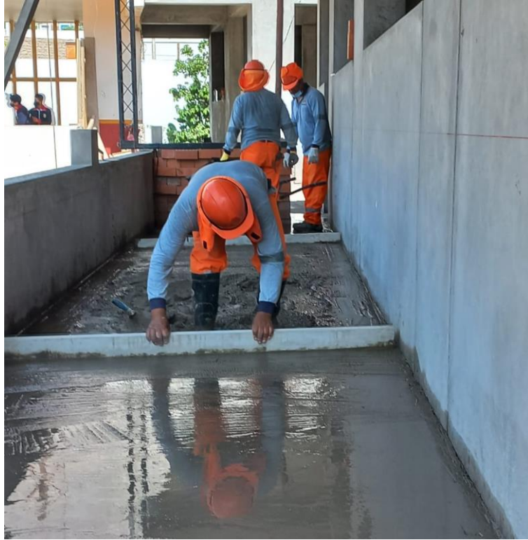
Figura 59. Vista fotográfica de piso cemento pulido en pasadizos del bloque 03.
