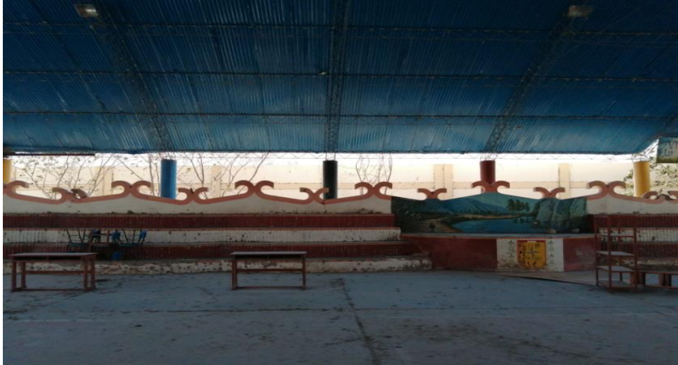
Figura 7. Área de construcción de losa deportiva antes de su intervención
