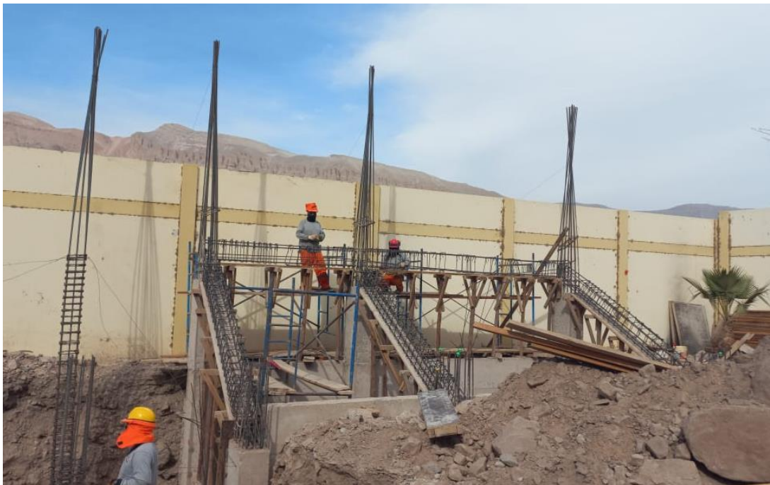
Figura 84. Vista fotográfica de habilitado de acero de vigas inclinadas y principales en gradería 01 tramo III – bloque 06.
