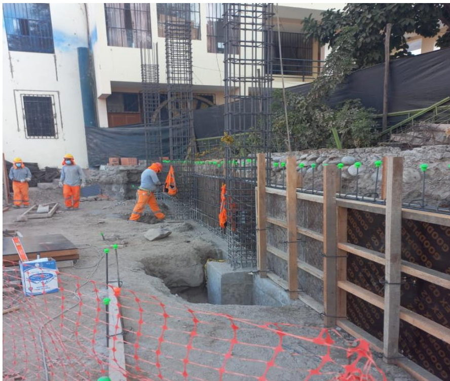
Figura 86. Vista fotográfica de habilitado de acero y encofrado en muros de contención en gradería 02 tramo III – bloque 06.
