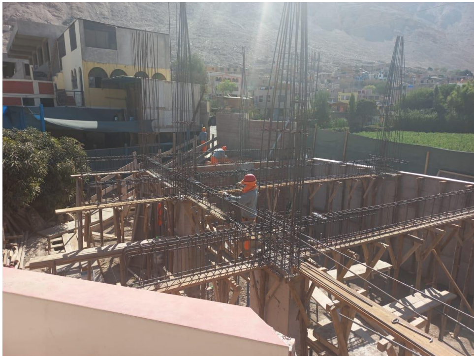
Figura 37. Vista fotográfica de encofrado y habilitado de acero en vigas principales en bloque 01.
