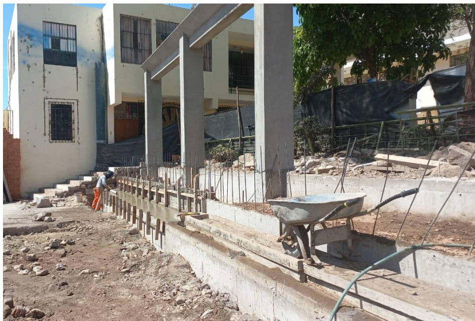
Figura 102. Vista fotográfica de relleno con material propio y encofrado y vaciado de graderías en gradería 02 tramo III – bloque 06.
