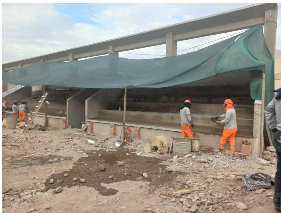
Figura 108. Vista fotográfica de tarrajeo de cemento pulido en gradería 01 tramo I al III – bloque 06.
