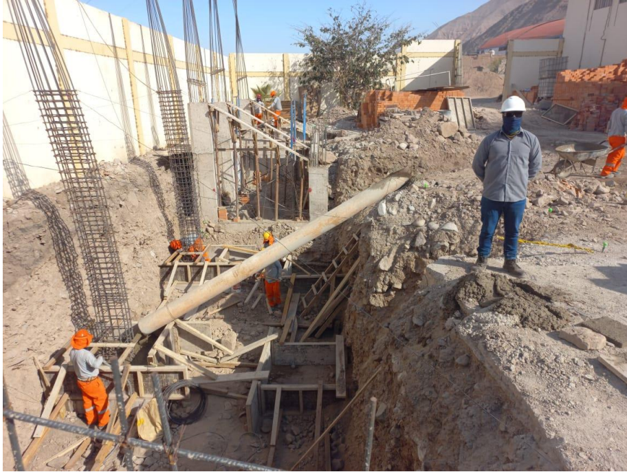
Figura 83. Vista fotográfica de verificación de habilitado de acero encofrado y vaciado de zapatas en gradería 01 tramo II – bloque 06.
