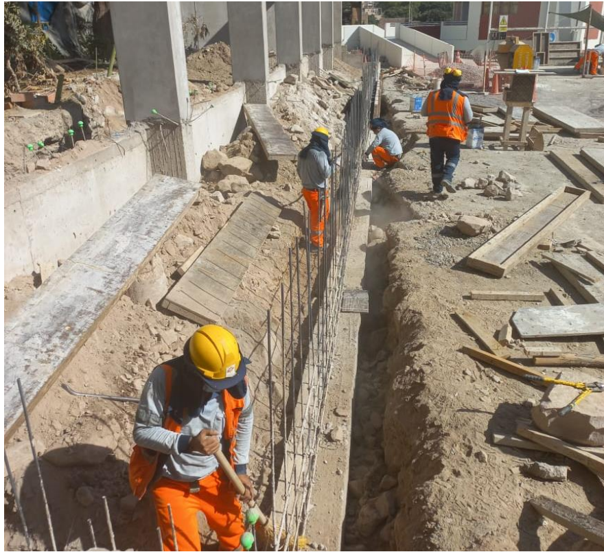
Figura 101. Vista fotográfica de habilitado de acero de gradería 02 tramo I al III – bloque 06.
