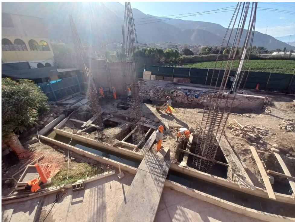
Figura 33. Vista fotográfica de funcionamiento de canal de regadío provisional, vaciado de concreto en zapatas y habilitación de acero en columnas en bloque 01.
