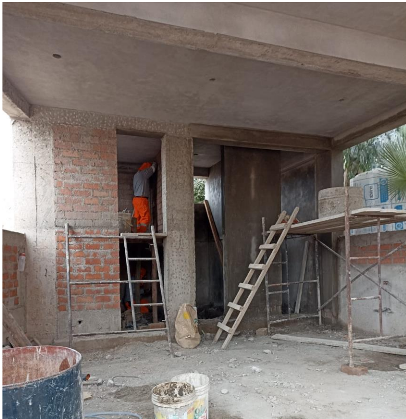
Figura 73. vista fotográfica de tarrajeo de muros y vigas en el bloque 05.
