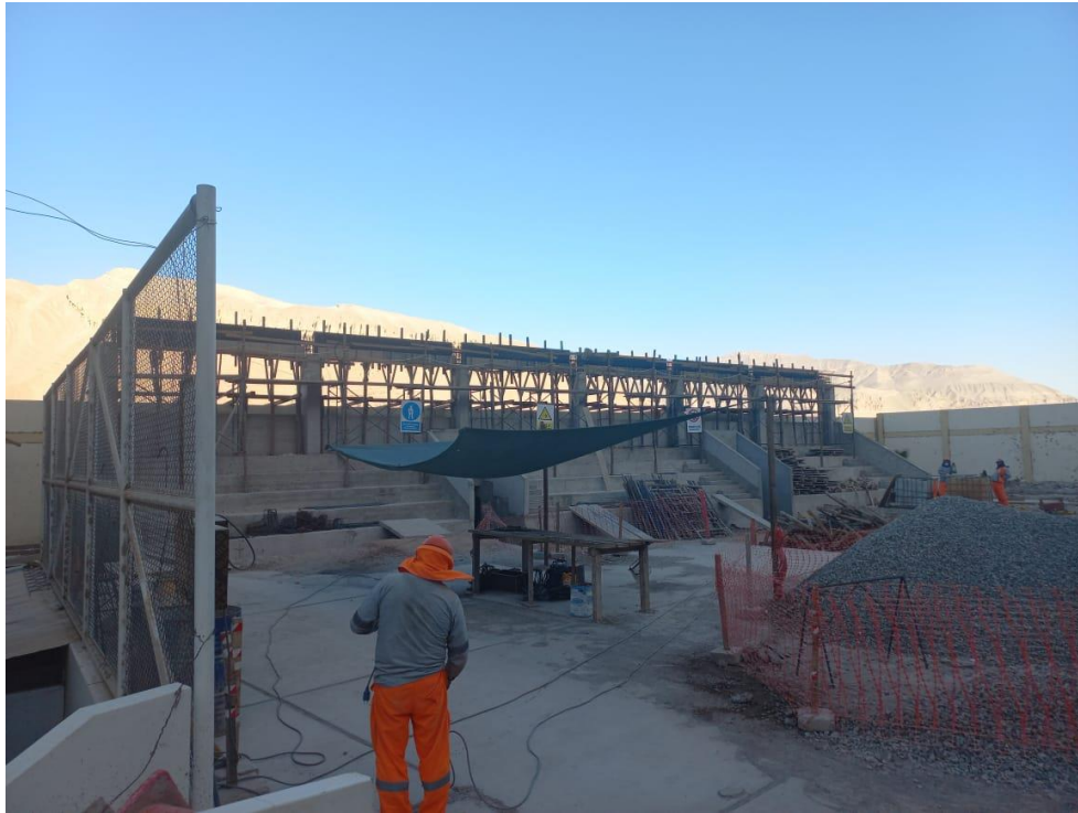
Figura 99. Vista fotográfica de encofrado de viga principal de cobertura autoportante de gradería 01 tramo I al III – bloque 06.
