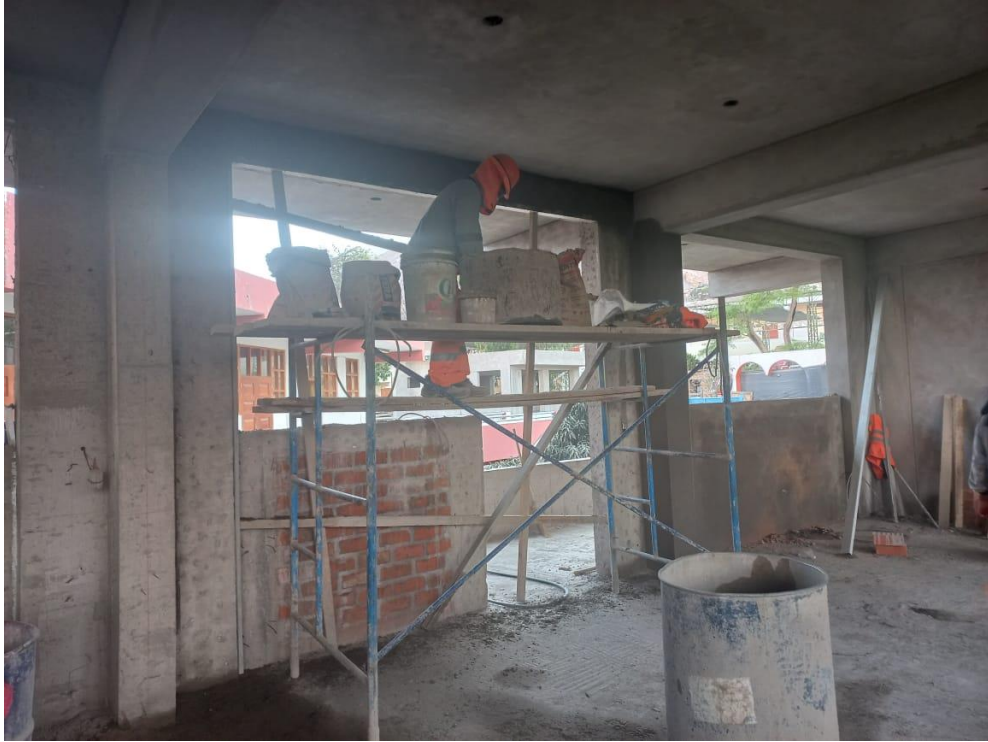
Figura 46. Vista fotográfica de tarrajeo en vigas, columnas y muros en bloque 01.
