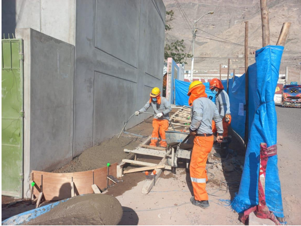
Figura 63. Vista fotográfica de vaciado de concreto en vereda en el bloque 04.
