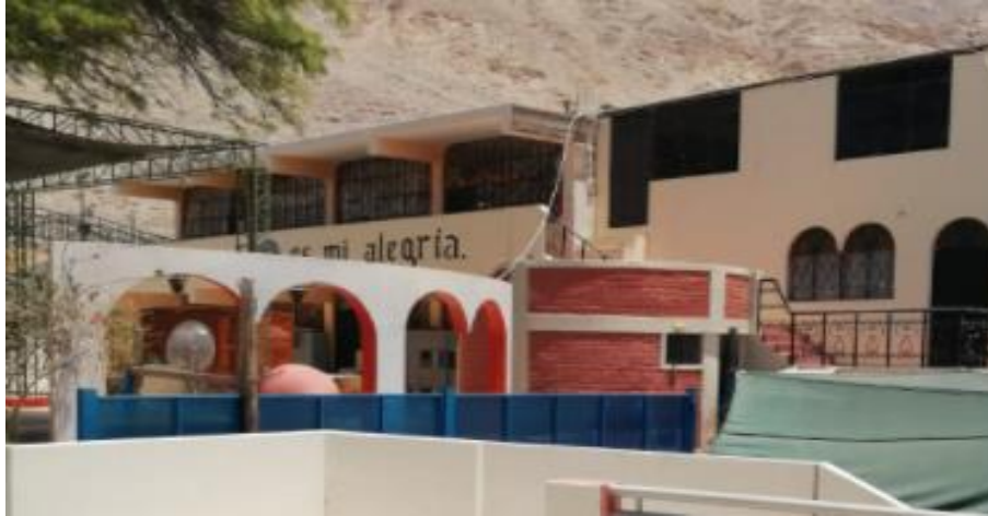
Figura 5. Área de construcción del bloque 03 y bloque 04 antes de su intervención.
