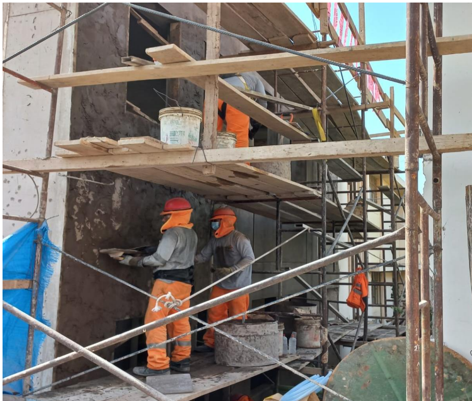
Figura 62. Vista fotográfica de tarrajeo exterior en el bloque 04.
