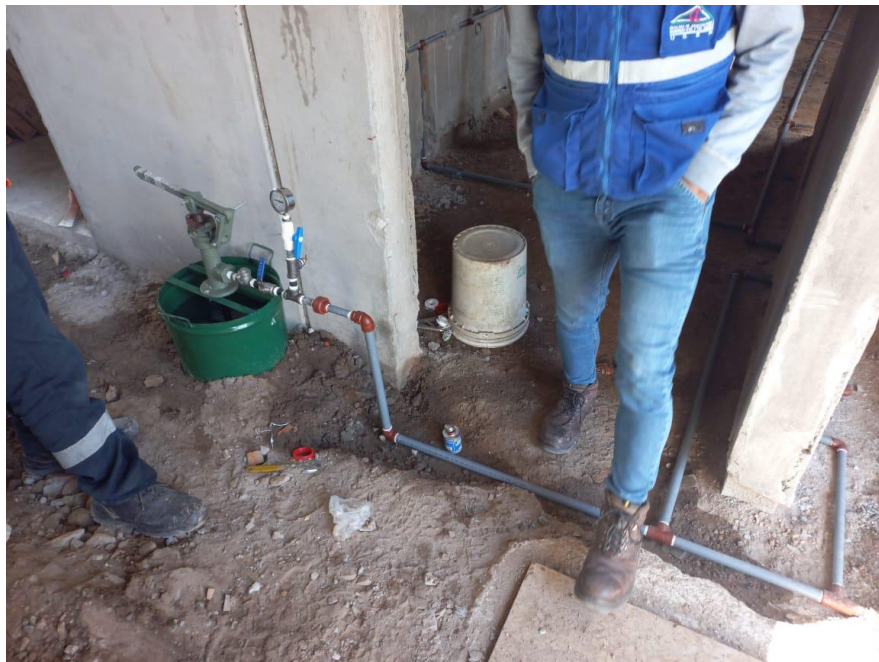
Figura 118. Prueba a presión con balde hidráulico para tuberías de agua.
