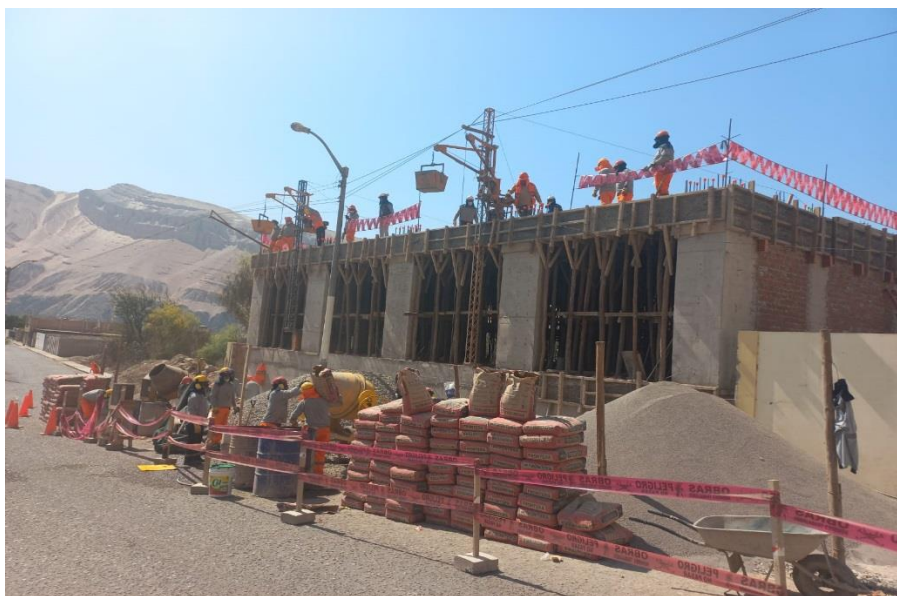
Figura 43. Vista fotográfica de vaciado de concreto f'c 0 210 kg/cm 2 en losa, vigas y viguetas en 2do nivel en bloque 01.
