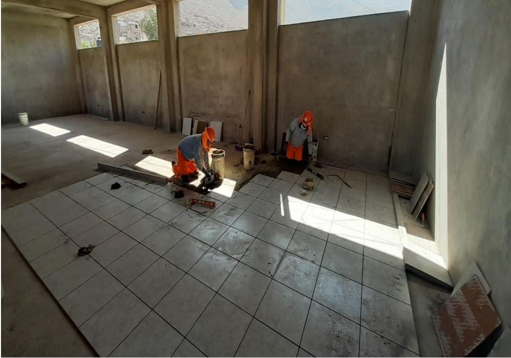
Figura 61. Vista fotográfica de colocado de cerámico en pisos en el bloque 03.
