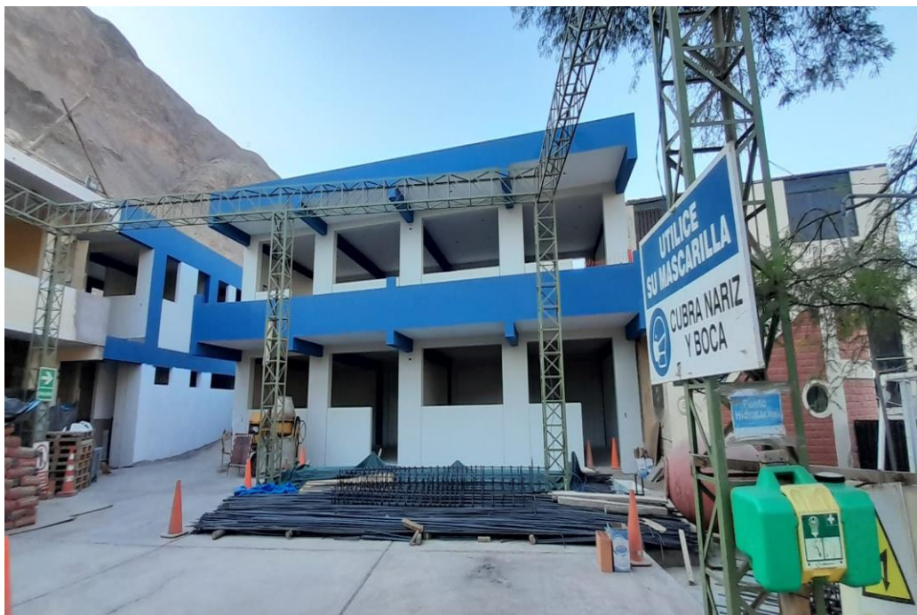
Figura 68. Vista fotográfica de pintura a 2 manos exterior en el bloque 03 y bloque 04.
