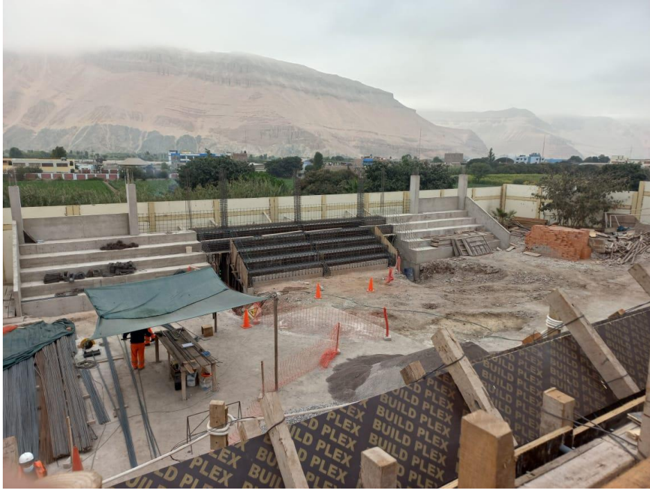
Figura 93. Vista fotográfica de habilitado de acero de gradería 01 tramo II – bloque 06.
