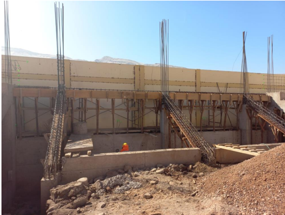
Figura 89. Vista fotográfica de habilitado de acero y encofrado en vigas inclinadas y principal de gradería 01 tramo II – bloque 06.
