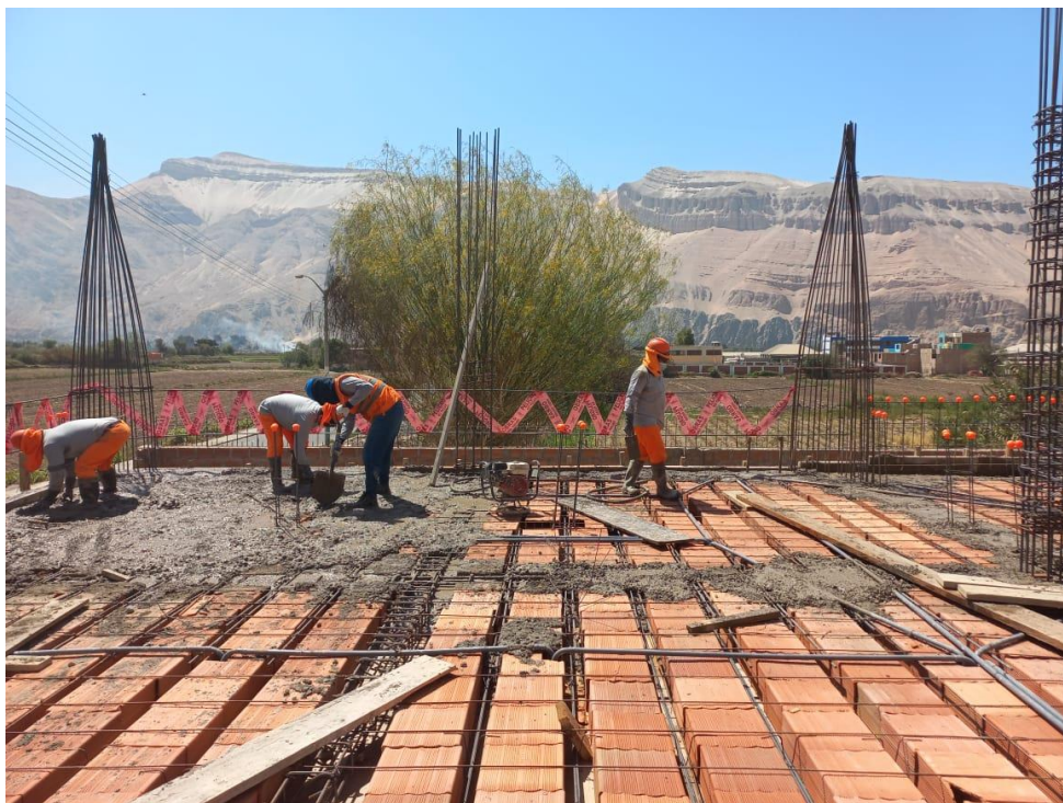
Figura 39. Vista fotográfica de vaciado de concreto en losa, vigas y viguetas del 1er nivel en bloque 01.
