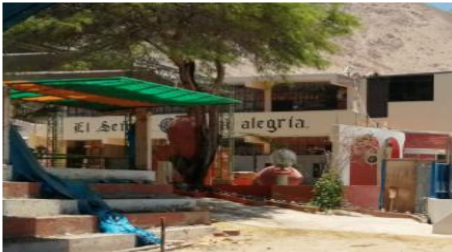
Figura 6. Área de construcción del bloque 05 antes de su intervención.
