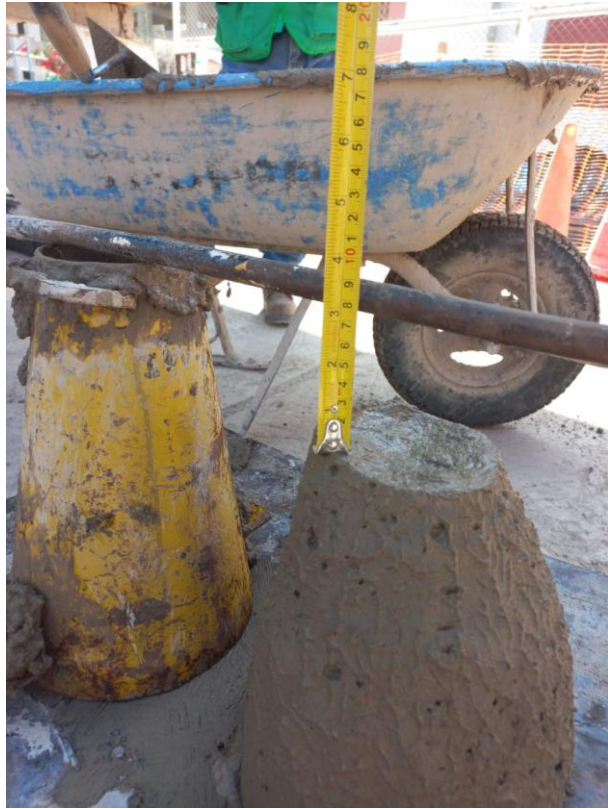
Figura 115. Toma de medidas para verificación de asentamiento mínimo en concreto.
