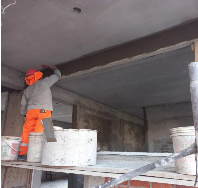
Figura 53. Vista fotográfica tarrajeo interior de vigas, columnas y muros en el bloque 04.
