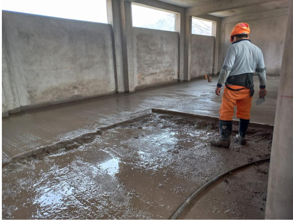
Figura 57: Vista fotográfica de vaciado de falso piso 2do nivel en el bloque 03.
