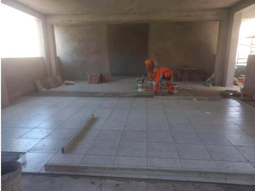
Figura 50. Vista fotográfica de colocado de cerámica para pisos en 2do nivel del bloque 01.
