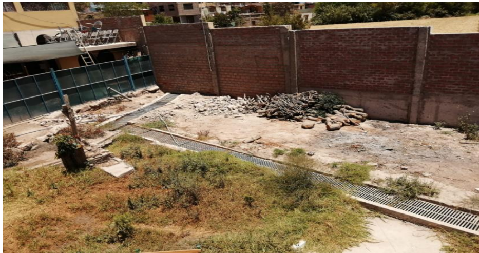
Figura 4. Área de construcción del bloque 01 antes de su intervención.
