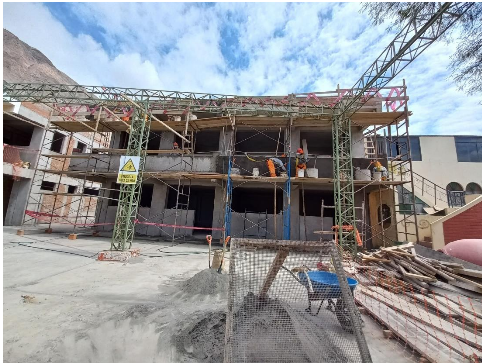
Figura 58. Vista fotográfica de tarrajeo exterior de muros en el bloque 03.
