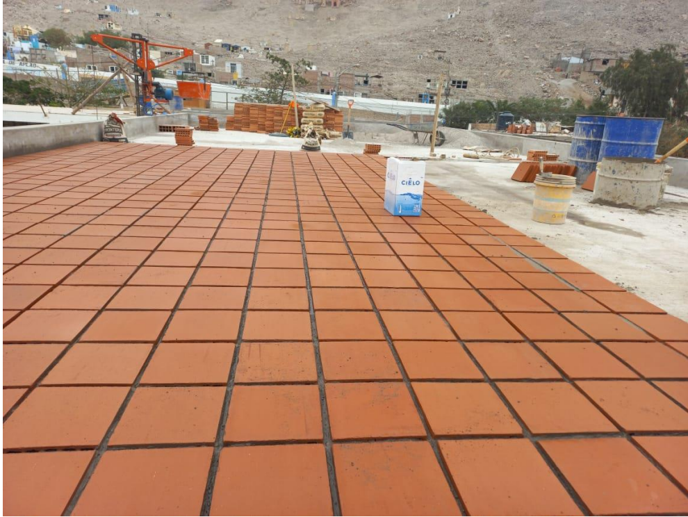
Figura 65. Vista fotográfica de cobertura de ladrillo pastelero en azotea en el bloque 04.
