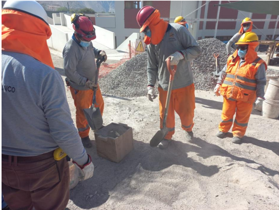
Figura 113. Dosificación de agregados acuerdo al diseño de mezcla aprobado.
