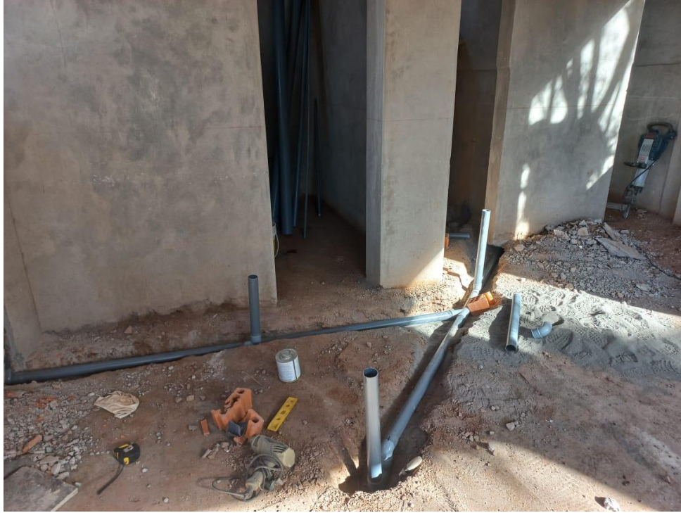
Figura 76. Vista fotográfica de instalaciones sanitarias en el bloque 05.
