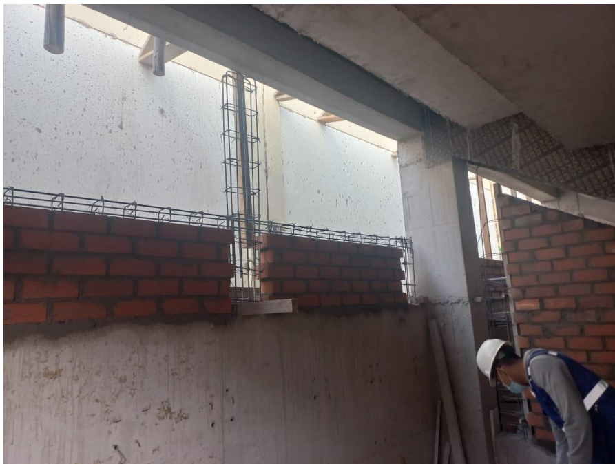
Figura 96. Vista fotográfica de asentado de ladrillo y habilitado de acero en viguetas y columnetas de gradería 01 tramo II – bloque 06.
