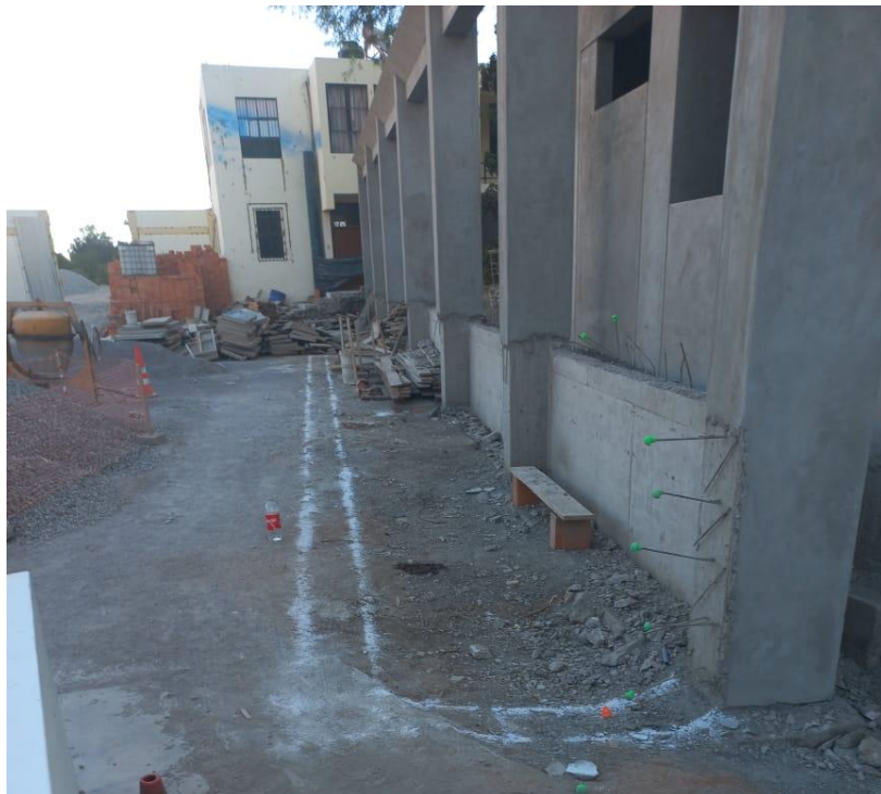
Figura 98. Vista fotográfica de trazo y replanteo para gradería 02 tramo II – bloque 06.
