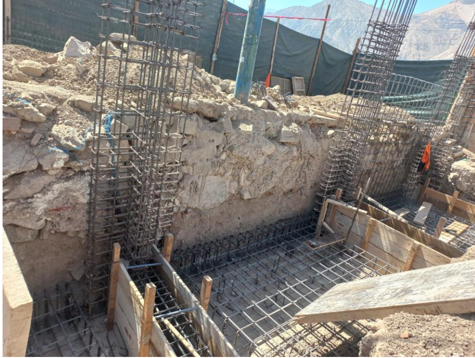
Figura 34. Vista fotográfica de habilitación de acero en zapatas, vigas de cimentación y columnas en bloque 01.
