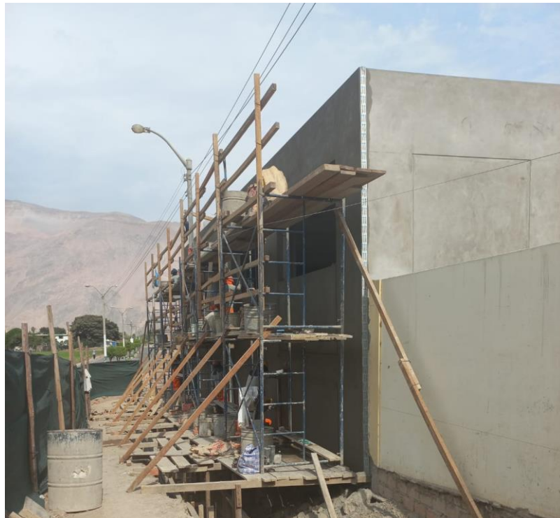
Figura 49. Vista fotográfica de tarrajeo de columnas, vigas y muros exteriores en bloque 01.
