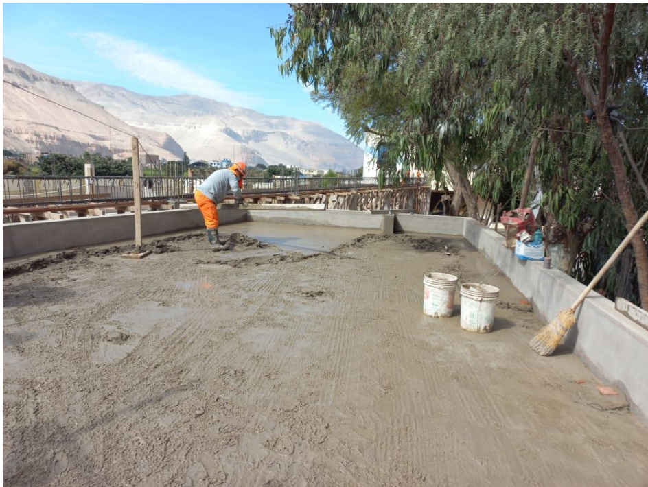
Figura 75. Vista fotográfica de vaciado de entrepiso en la azotea en el bloque 05.
