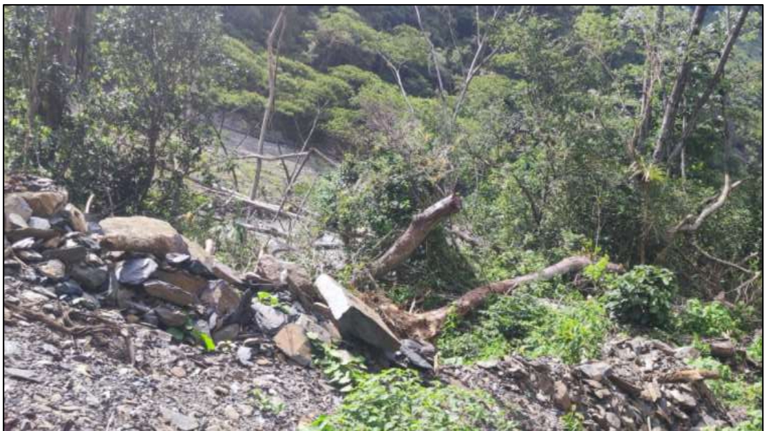
Desbroce y limpieza del terreno. Foto 4.
