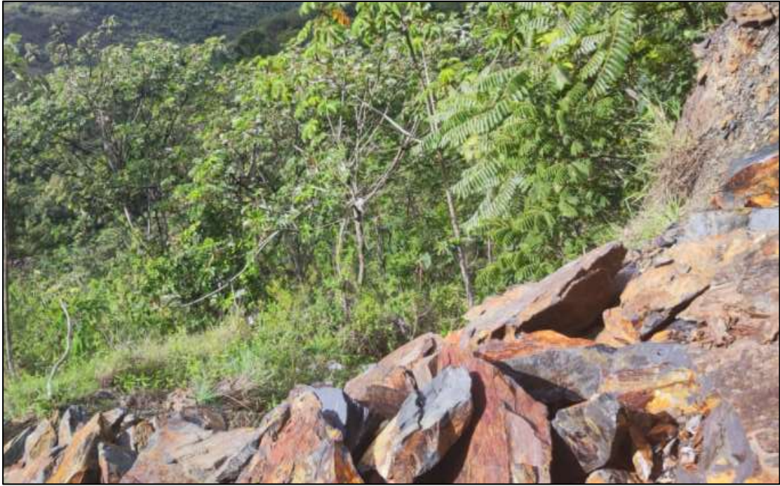
Desbroce y limpieza del terreno. Foto 1.
