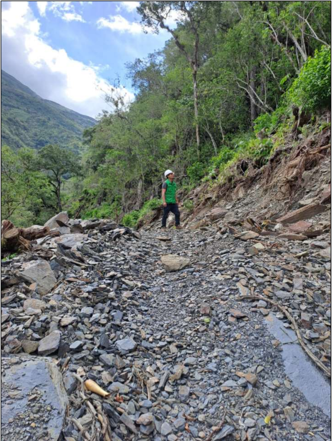
Desbroce y limpieza del terreno. Foto 11.
