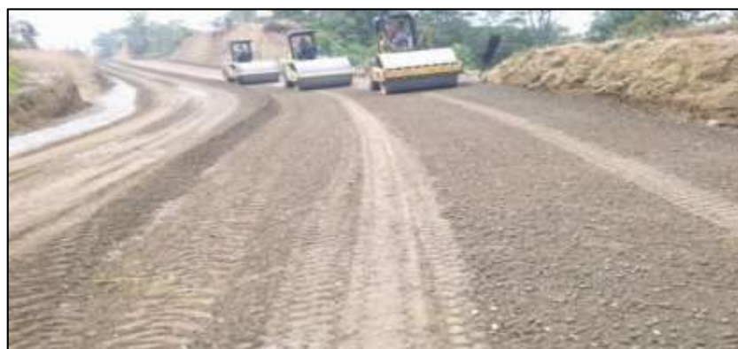
Figura 8: Fotografía de la compactación de un pavimento de afirmado típico.
