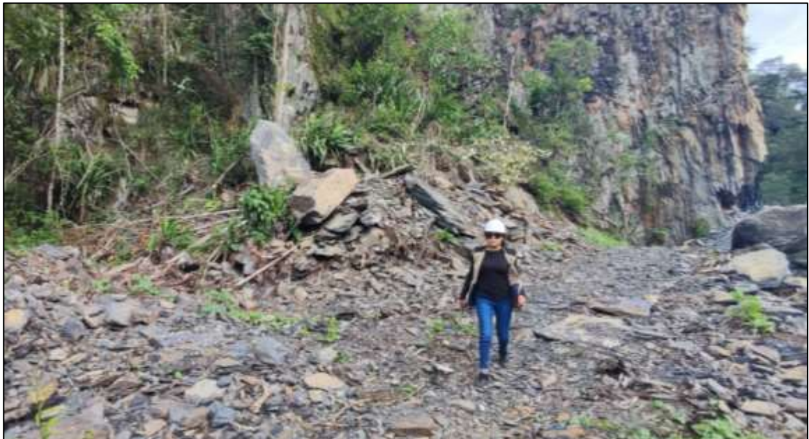
Desbroce y limpieza del terreno. Foto 2.
