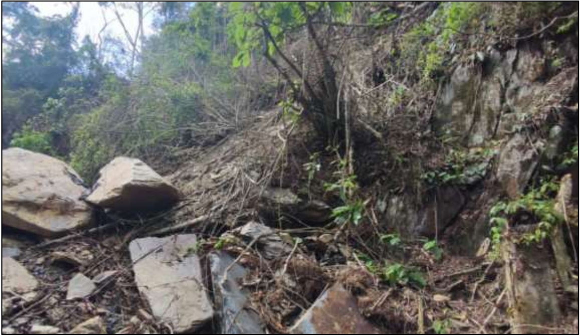
Desbroce y limpieza del terreno. Foto 3.
