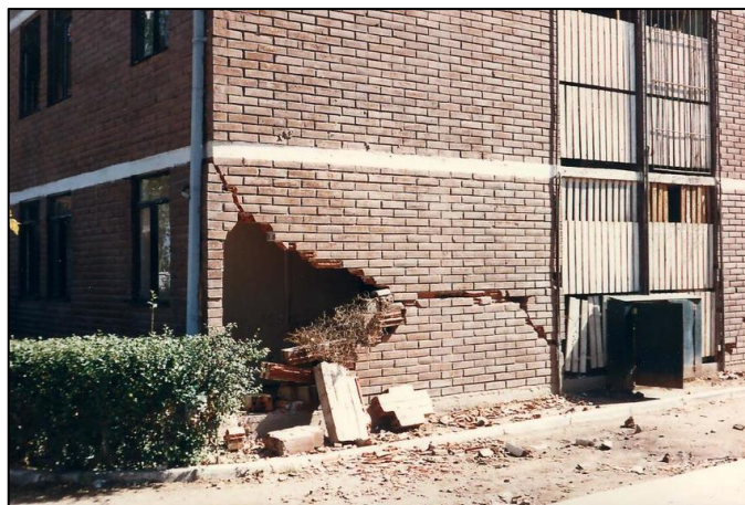
Figura 2. Edificio de albañilería no reforzada Fuente: (Astroza, 2000)
