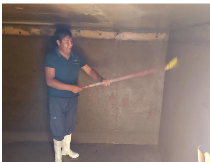
Figura 17. Limpieza y desinfección de sistemas de abastecimiento de agua
