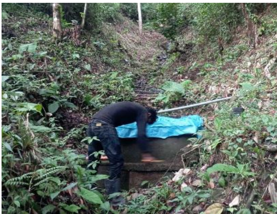
Figura 9. Situación inicial del sistema de captación de agua
