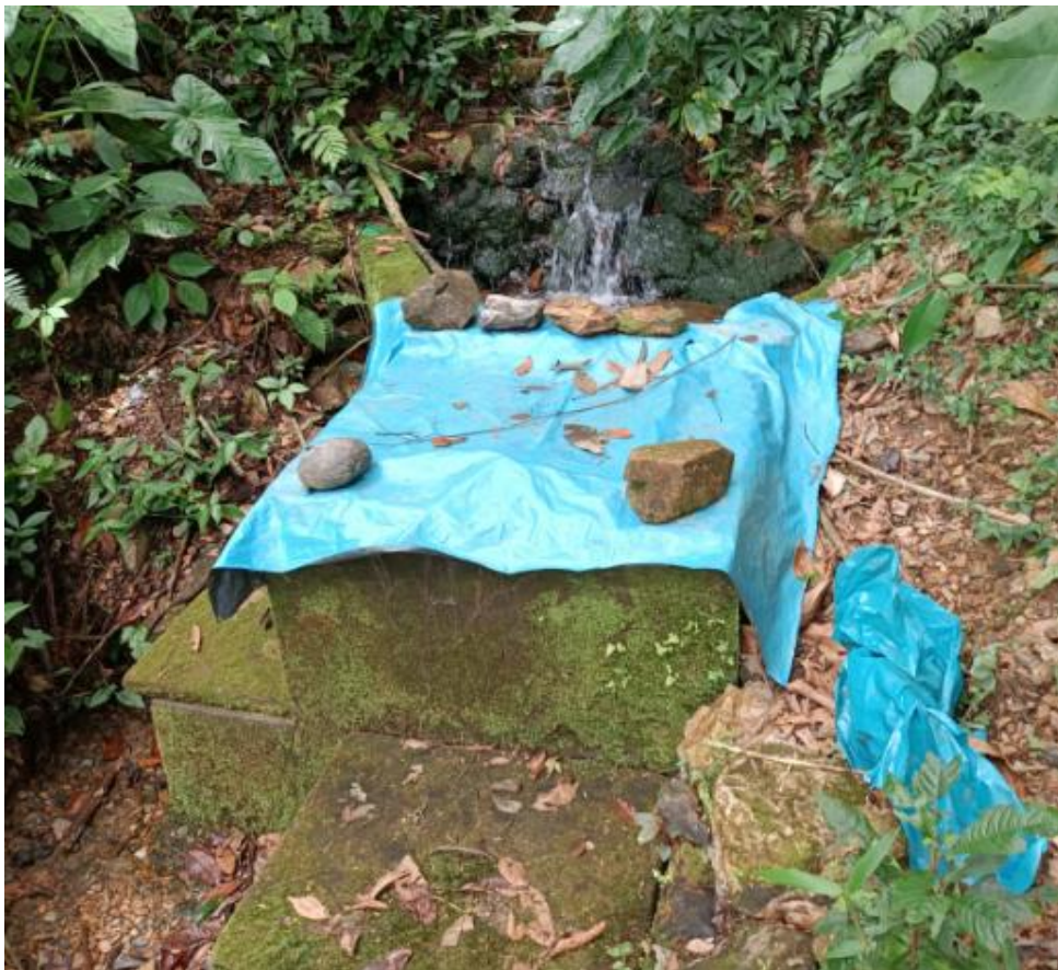
Figura 8. Situación inicial de captación de agua
