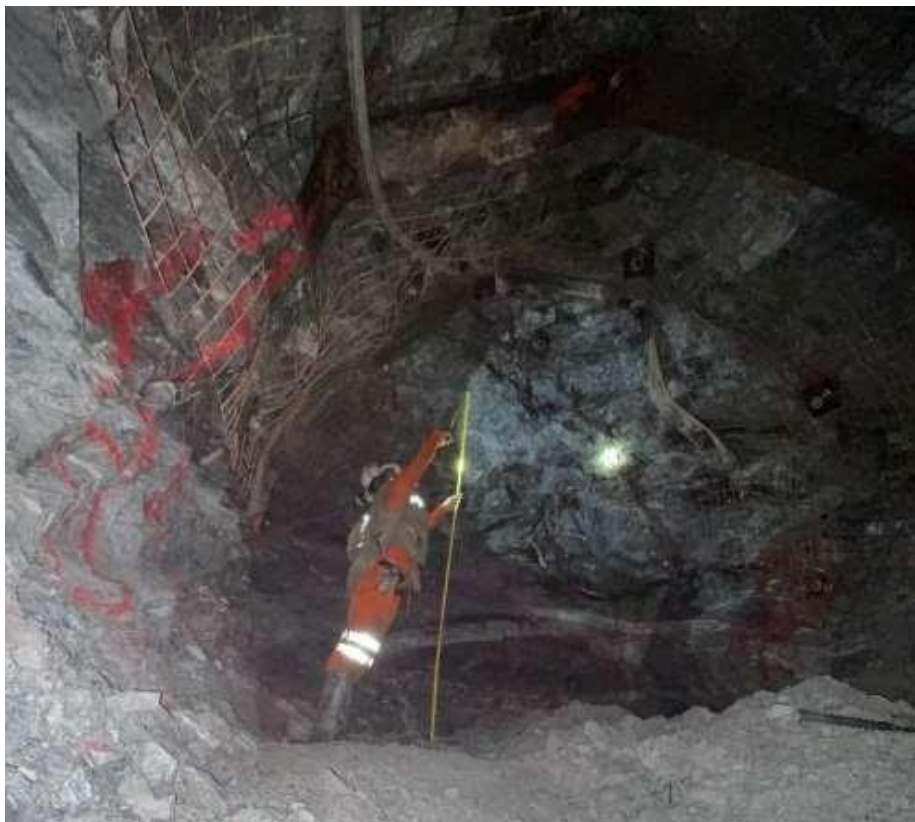
Figura 5. Perno y malla electrosoldada. Nota. Fotografía: Sostenimiento de labor horizontal con perno más malla electrosoldada.
