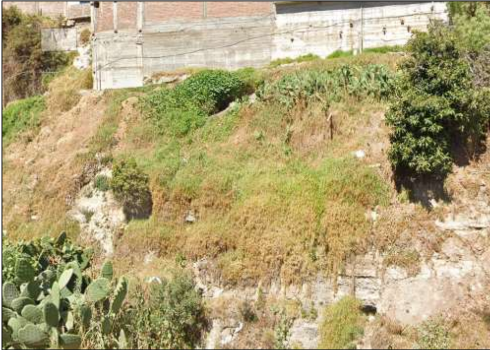
Descarga de efluentes domiciliarios en el Rio Shullcas
