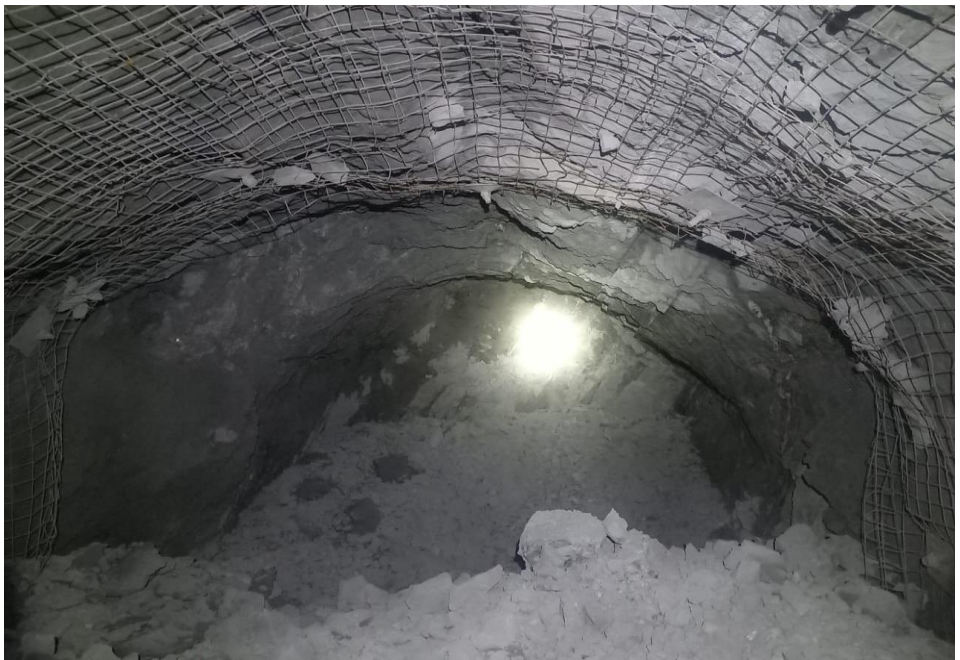
Foto 5 Menor daño a la malla electrosoldada y sección controlada
