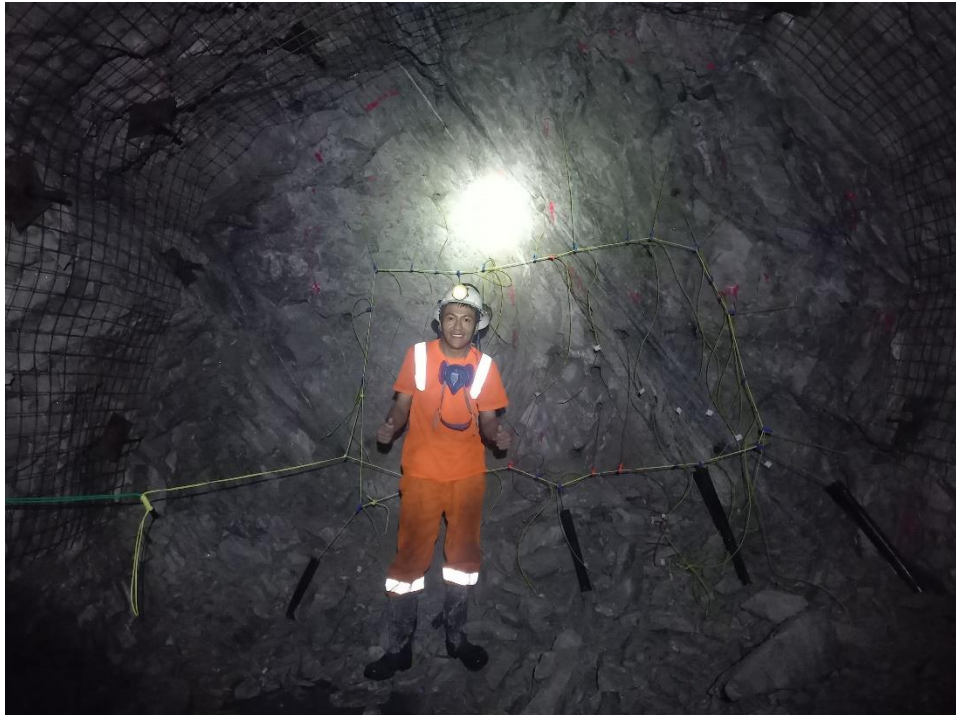
Foto 5 Menor daño a la malla electrosoldada y sección controlada
