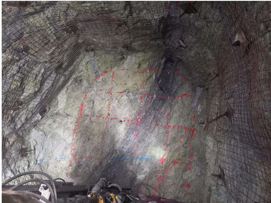
Foto 3 Diseño de malla de perforación
