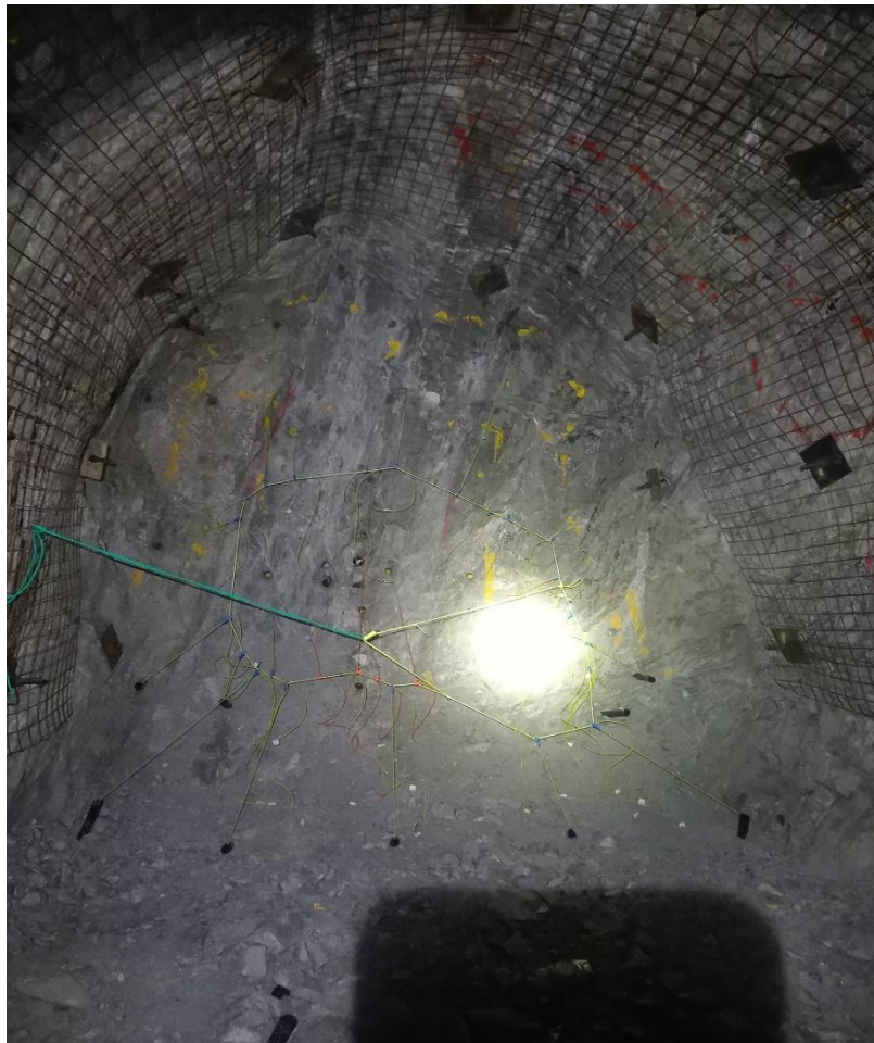
Foto 1 Malla de perforación y voladura convencional
