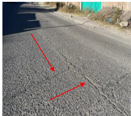
Foto 53: (Agrietamiento en bloque)
