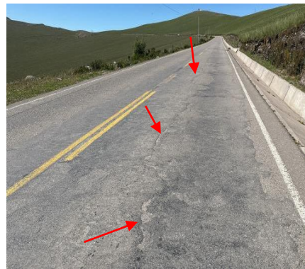
Foto 46: (Grietas longitudinales y transversales)
