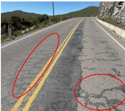
Foto 45: (Grieta de reflexión de junta)
