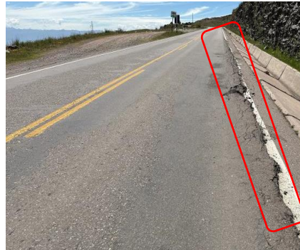
Foto 46: (Grietas longitudinales y transversales)
