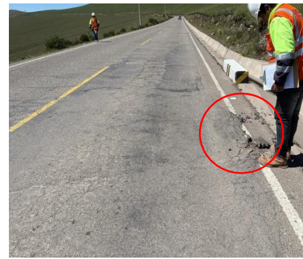
Foto 47: (Desprendimiento de agregados)
