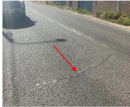
Foto 54: (Grietas longitudinales y transversales)
