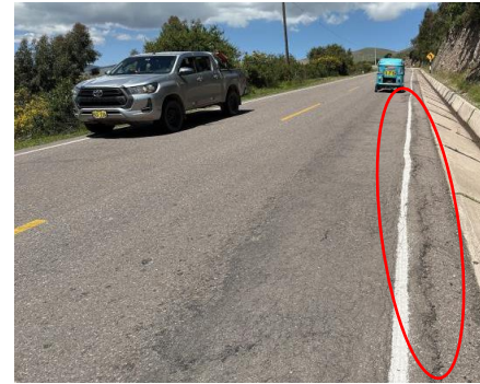
Foto 31: (Grieta de borde y ahuellamiento)
