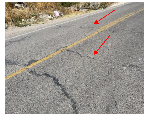
Foto 56: (Grietas longitudinales y transversales)
