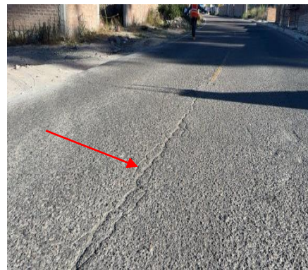
Foto 54: (Grietas longitudinales y transversales)
