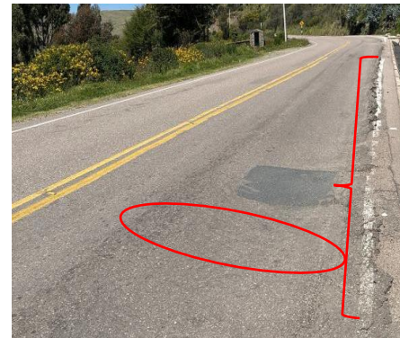
Foto 31: (Grieta de borde y ahuellamiento)
