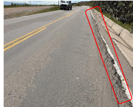
Foto 47: (Desprendimiento de agregados)
