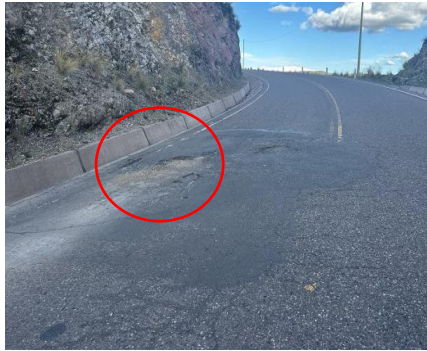
Foto 53: (Agrietamiento en bloque)
