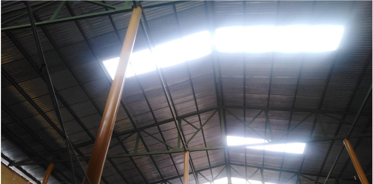
Figura 33. Vista real de la armadura de la cobertura del Mercado Virgen de Fátima. Fuente: Elaboración Propia
