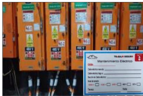
Figura 64. Implementación los TAG de Identificación de los equipos que energizan en los Tableros Eléctricos
