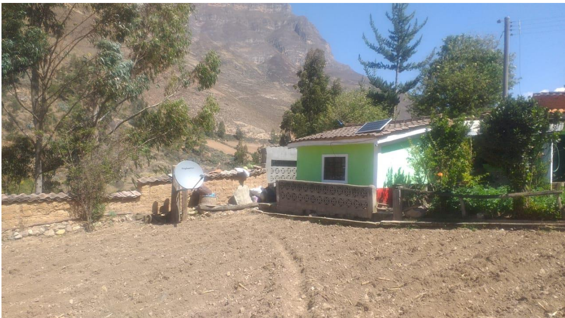
Figura 46. Instalación de internet. Tomado por el autor.
