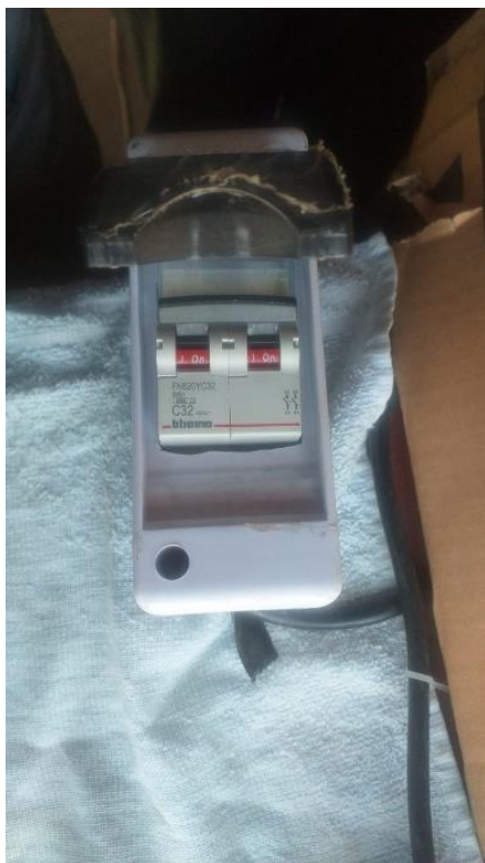
Figura 38. Interrupor Termo magnético 2X32A 10Ka/400V FN820YC32 NE. Tomado por el autor.
