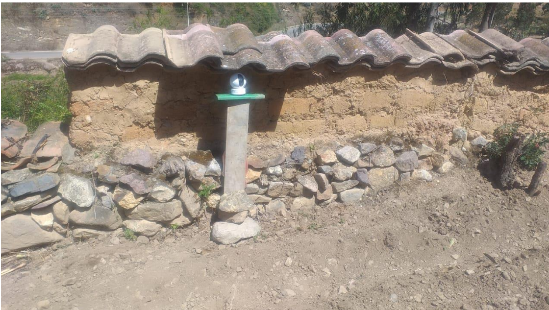
Figura 66. Instalación de cámara 1. Tomado por el autor.
