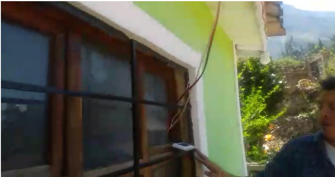
Figura 79. Prueba de la conexión de la batería, el conversor y el modem. Tomado por el autor.
