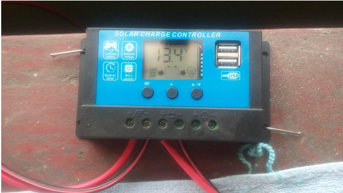
Figura 60. Instalación del Controlador solar. Tomado por el autor.
