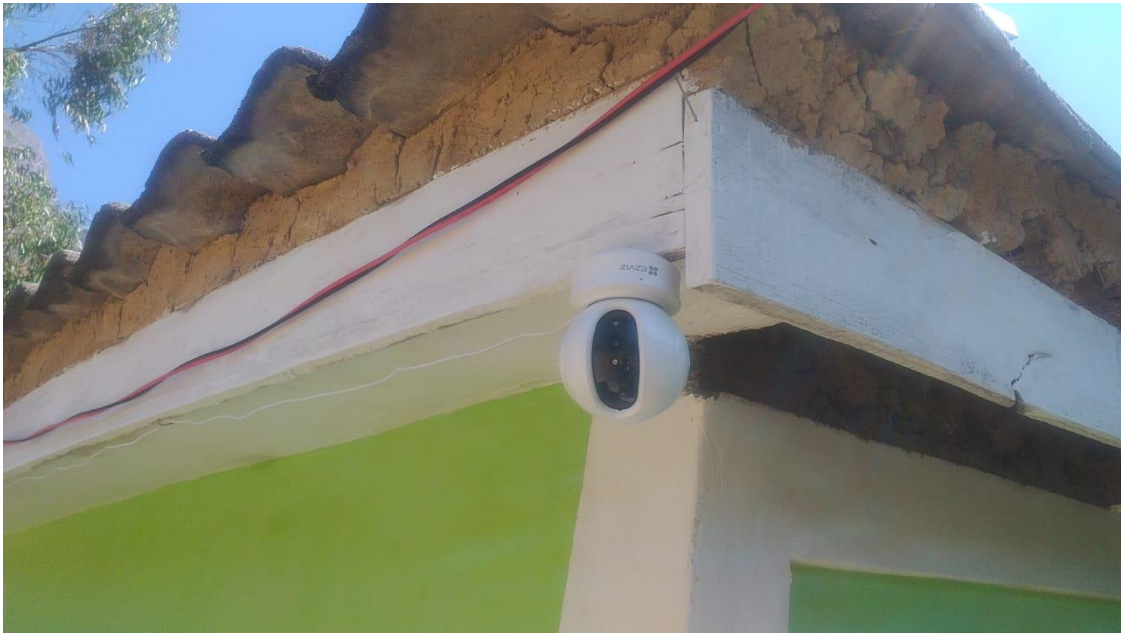
Figura 67. Instalación de la cámara 2. Tomado por el autor.
