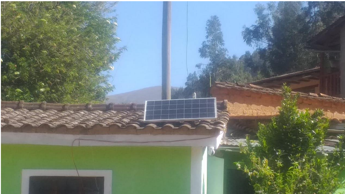
Figura 59. Instalación del panel solar. Tomado por el autor.
