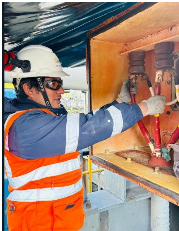
Figura 13. Actividad de supervisión
