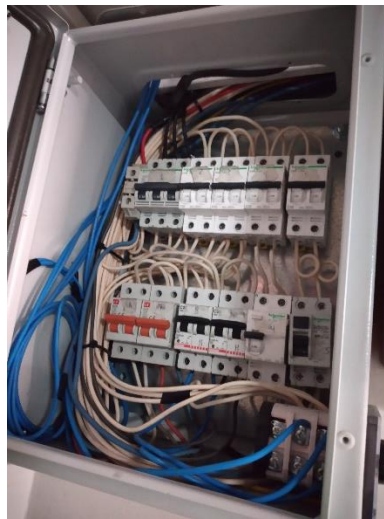
Ilustración 27 Inspeccion a tablero eléctrico
