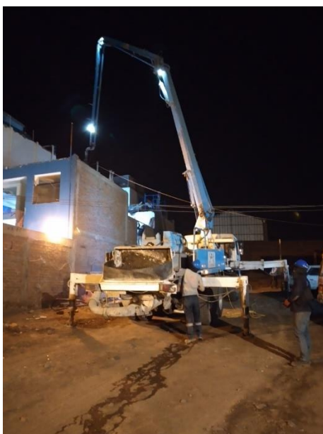
Ilustración 4 Supervisión a Trabajos de Alto Riesgo Sector Construcción
