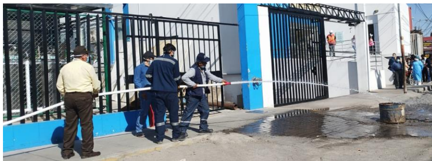
Ilustración 26 Verificación del funcionamiento de la manguera contraincendios de la ipress
