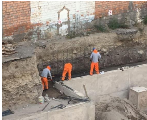
Ilustración 75 Supervisión de trabajos en acero para vaciado de zapatas
