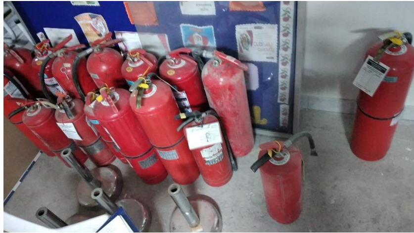
Ilustración 25 Extintores almacenados en sótano siendo inspeccionados para el proceso de baja y recarga
