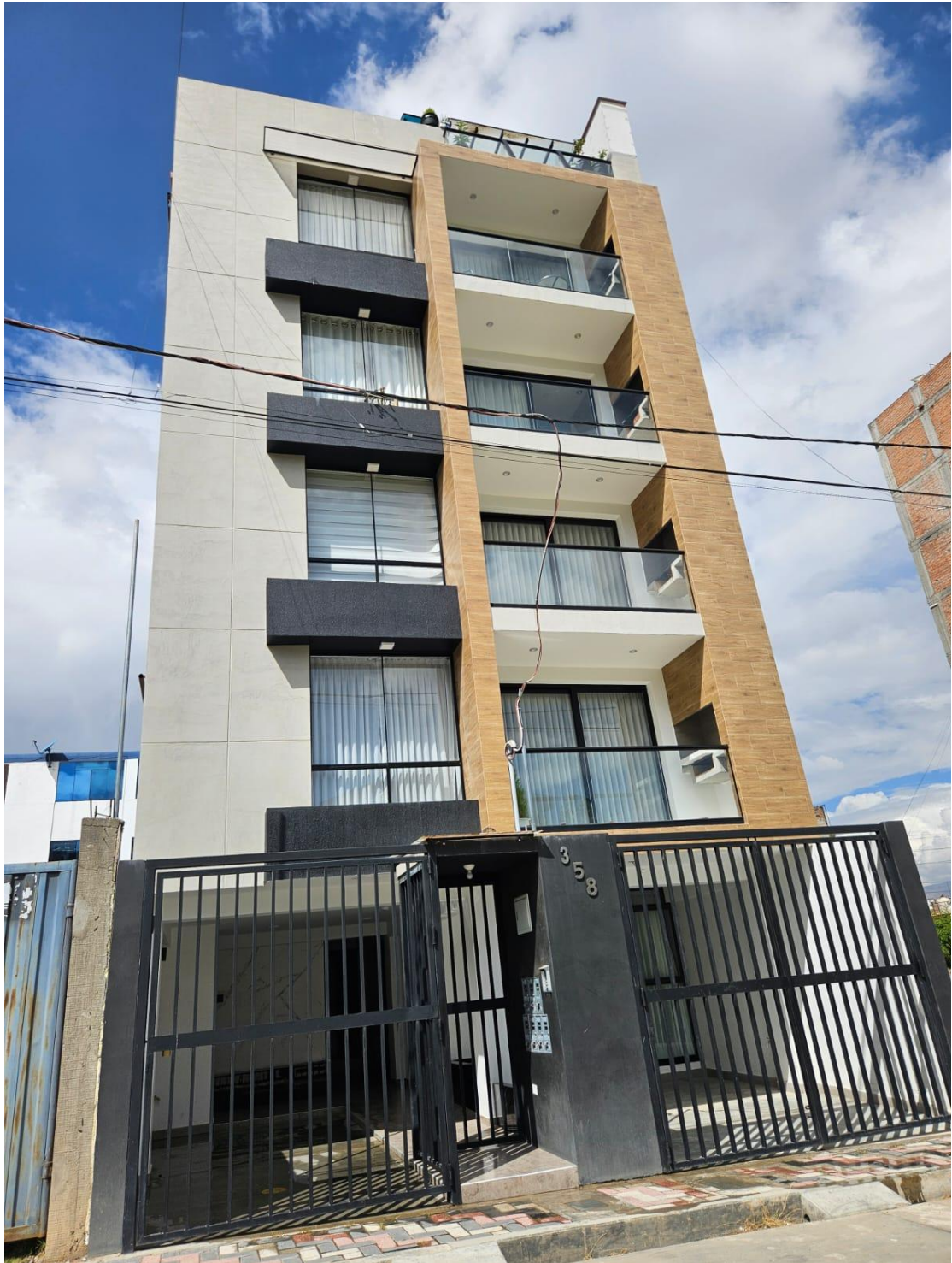
Fotografía 2. Vista frontal de la edificación
