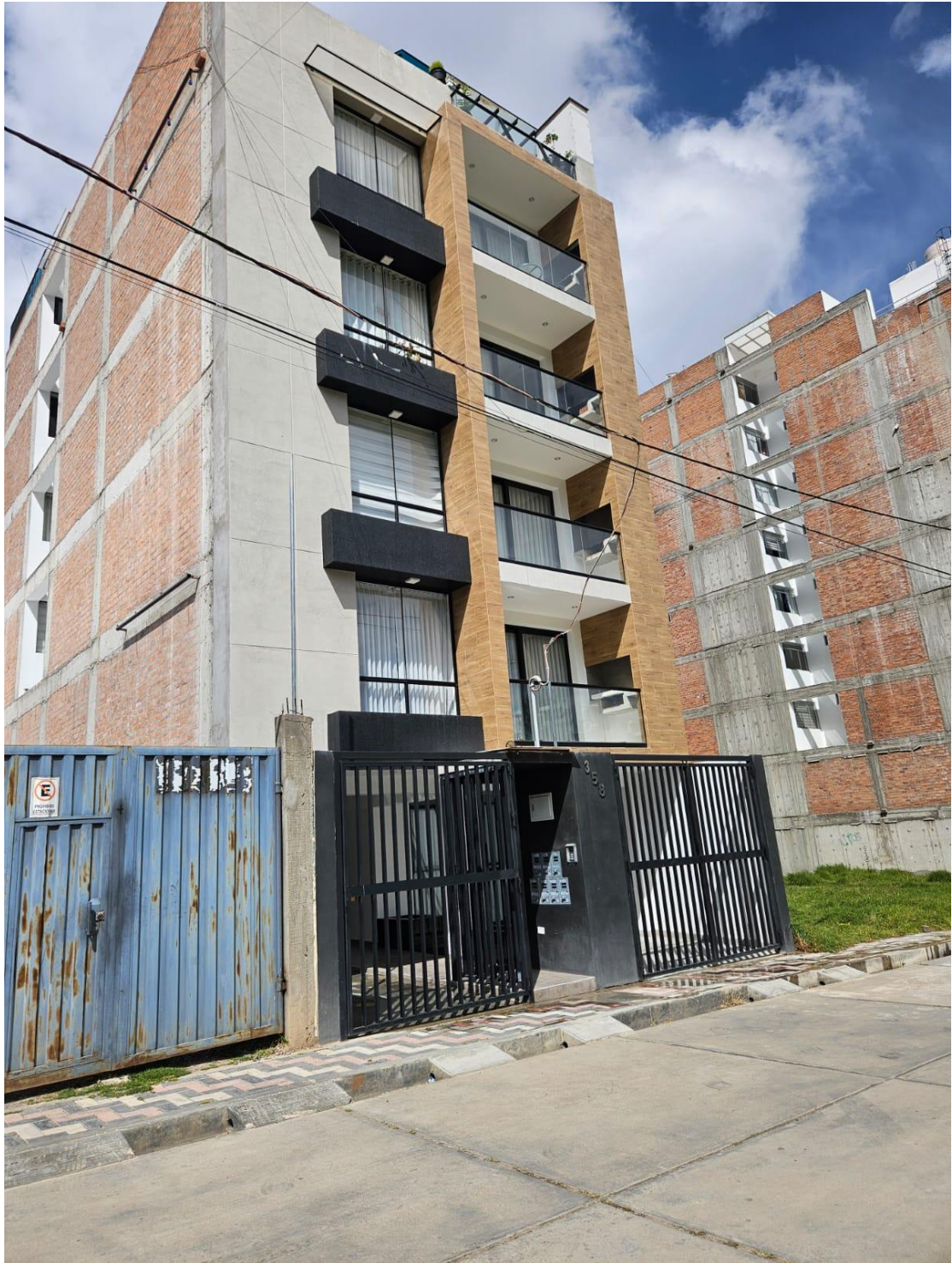
Fotografía 1. Elevación lateral de la edificación
