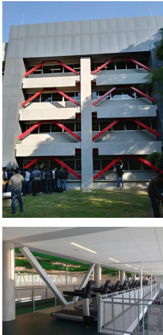
Figura 39 - Muestra de la disposición de los CRP, como arriostres laterales excéntricos.
