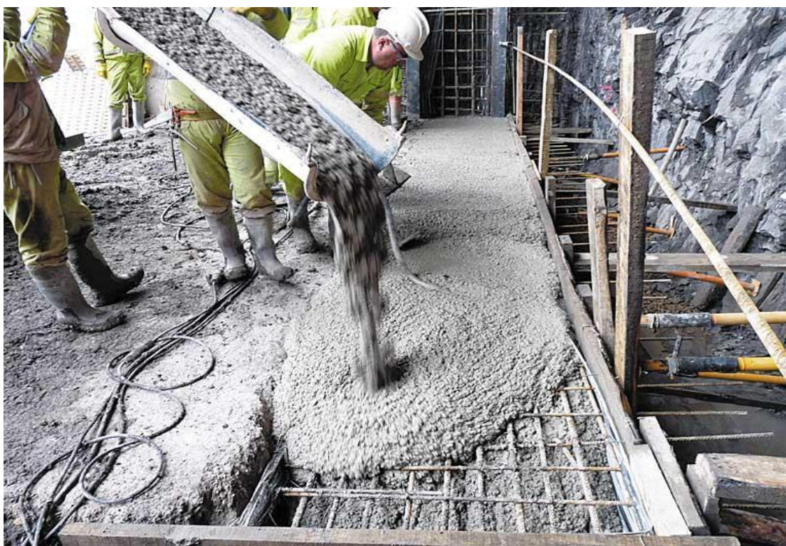
Figura 1. La consistencia es una característica que mide la humedad de una mezcla por su grado de fluidez. Tomada de: https://victoryepes.blogs.upv.es/category/hormigon/
