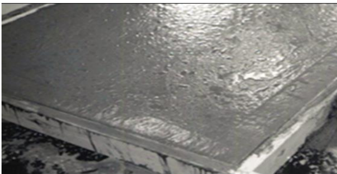
Figura 5. Exudación. Característica que hace que una parte del agua de amasado suba a la superficie del hormigón tras separarse de la masa. Tomado de https://notasdeconcretos.blogspot.com/2011/04/sangrado-o-exudacion-del-concreto.html
