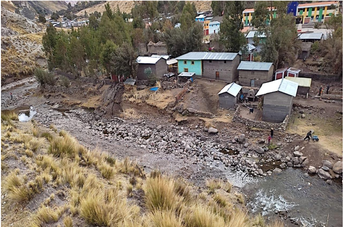
Figura 1. Zona expuesta a inundación, socavación y deslizamiento del río Chahuarma
