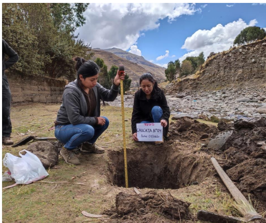
Figura 50: Excavación de calicata N°03 para la extracción de muestras
