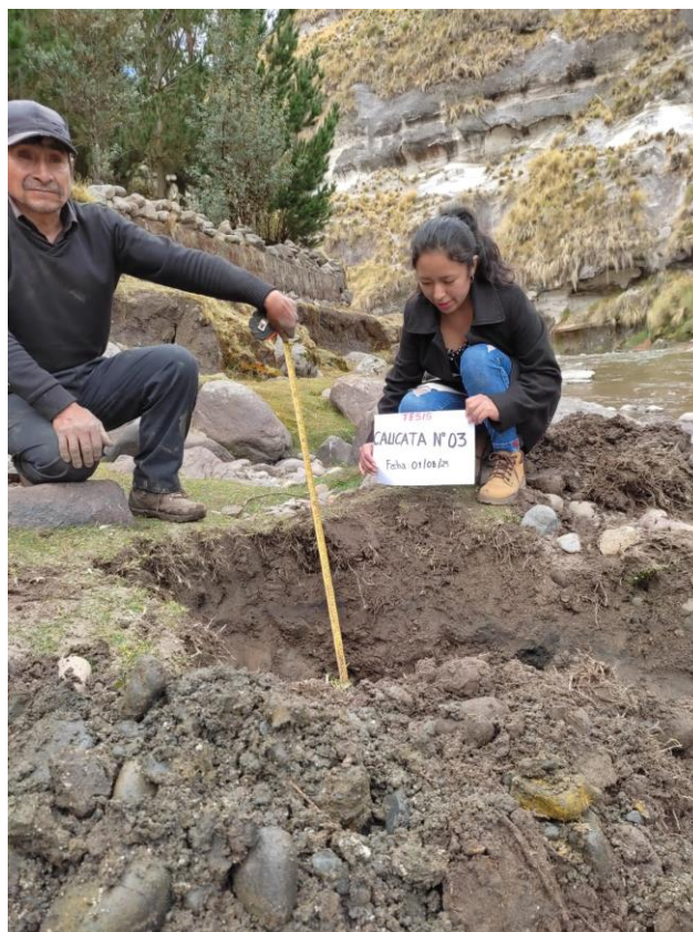
Figura 49: Excavación de calicata N°03 para la extracción de muestras
