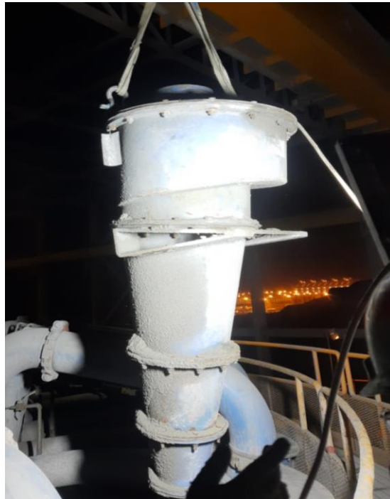
Figura 24. Desmontaje de hidrociclón
