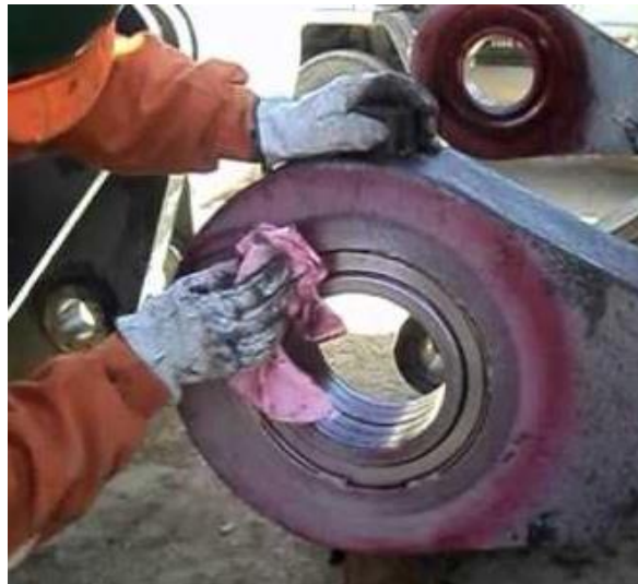
Figura 31. Aplicación de tintes penetrantes
