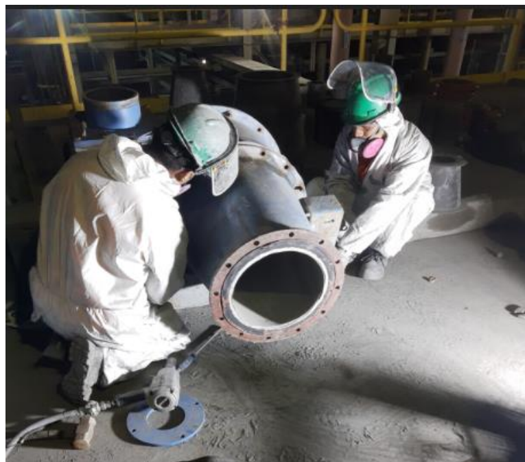
Figura 26. Retiro de sección cónica del hidrociclón
