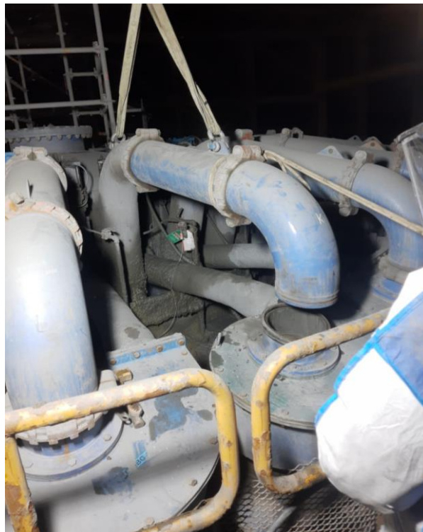
Figura 23. Desmontaje de bastones overflow
