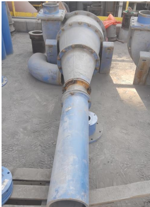
Figura 30. Inspección visual hidrociclón
