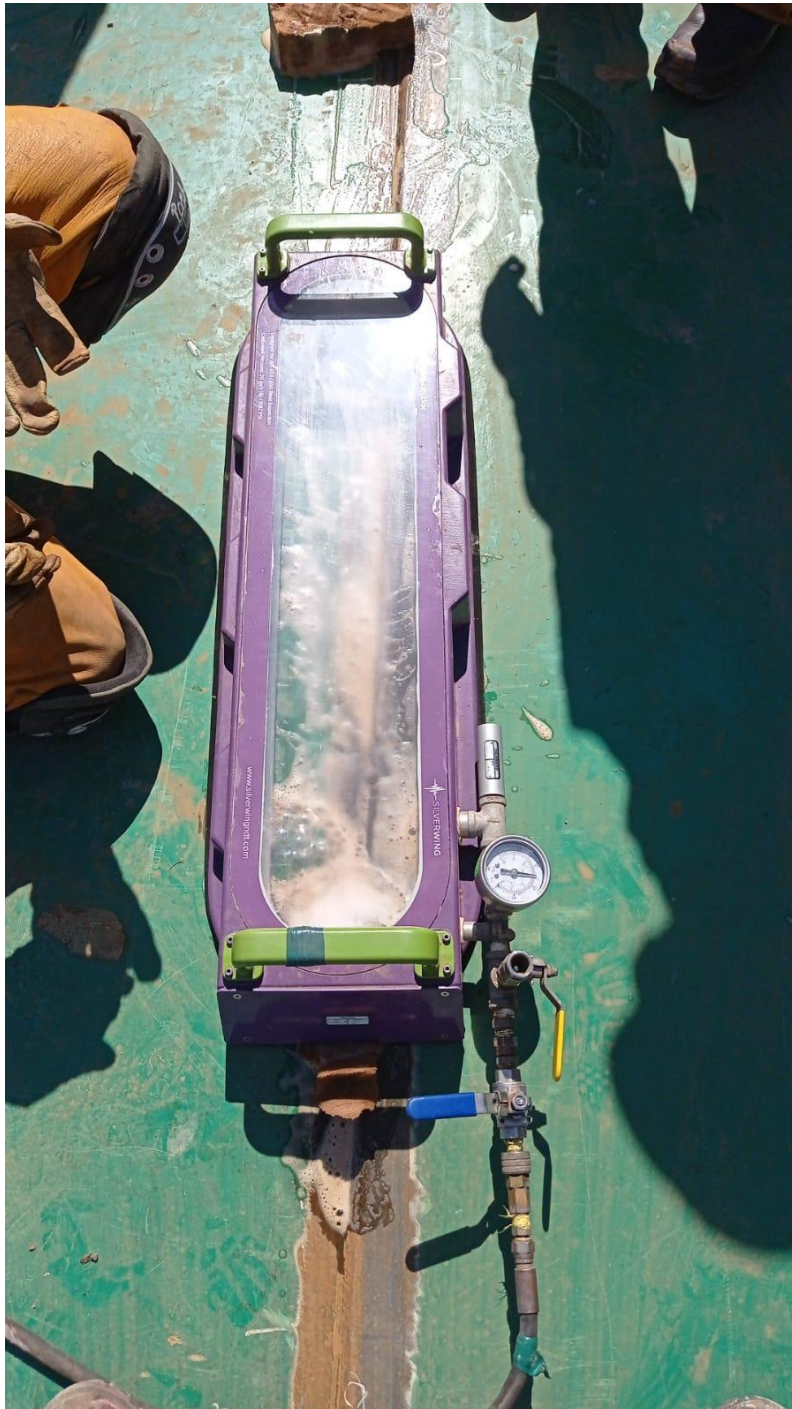
Figura 22. Cámara de vacío
