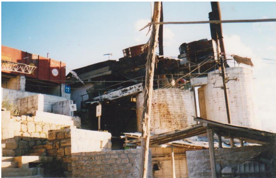
Figura 51. Instalaciones de la calera Porvenir
