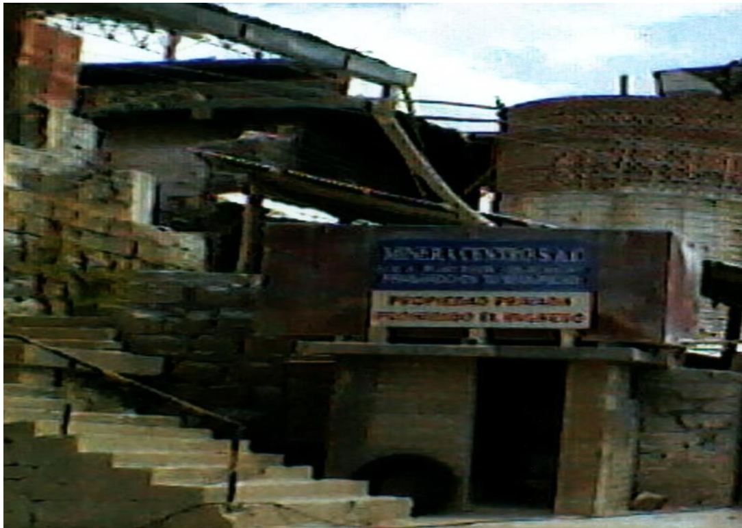
Figura 52. Instalaciones de la calera Porvenir
