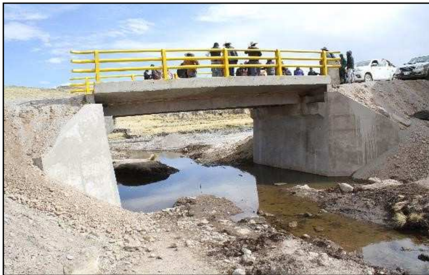
Figura 2. Puente tipo viga Kasillo – Coporaque – Espinar – Cusco.
