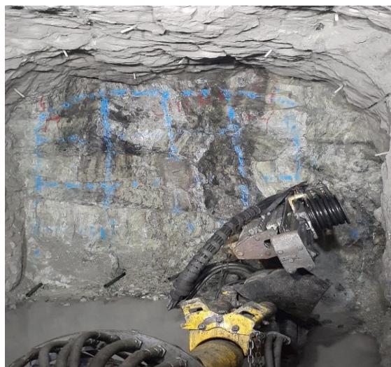
Figura 42. Perforación del frente en circado
