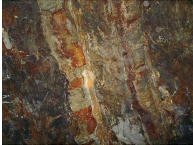
Figura 14. Caliza Alterada: RMR aproximado 42 (32-58) Tomado del Departamento de Geomecánica Santa Luisa S.A.
