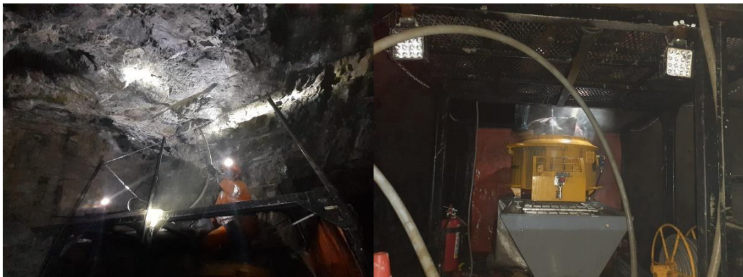
Figura 27. Limpieza y acarreo
