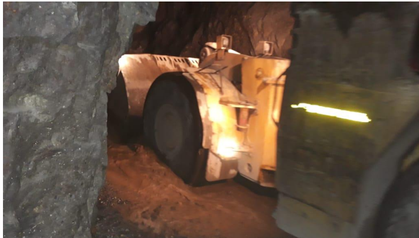
Figura 26. Limpieza y acarreo
