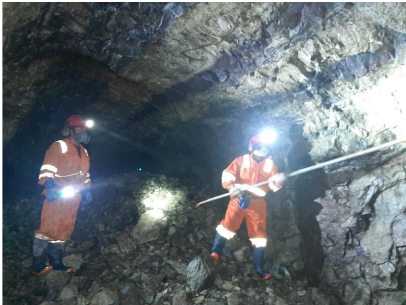
Figura 25. Riego y desate de rocas
