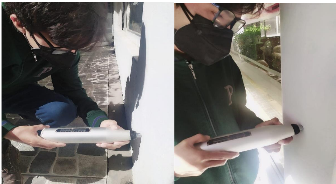
Figura 4.10. Ensayo de Esclerómetro (elaboración propia)
