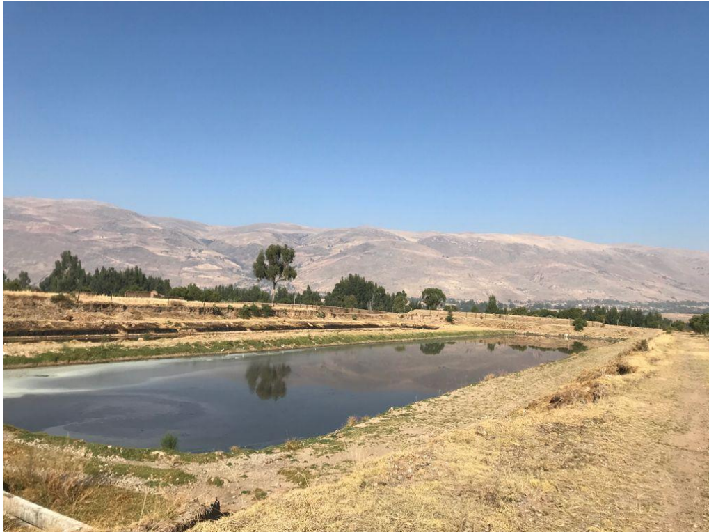
Fotografía 09. PTAR existente en el Centro Poblado de Huamanmarca.
