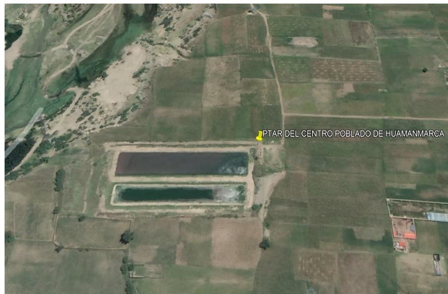
Figura 01. Ubicación de la Planta de Tratamiento de Aguas Residuales (PTAR) del Centro Poblado de Huamanmarca.
