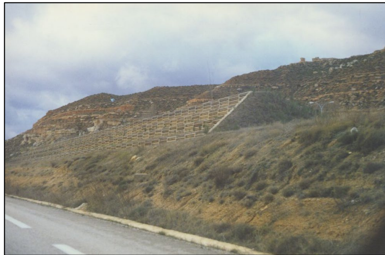
Figura 41. Diques de tierra
