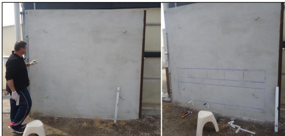
Figura 63. Estructura del muro final
