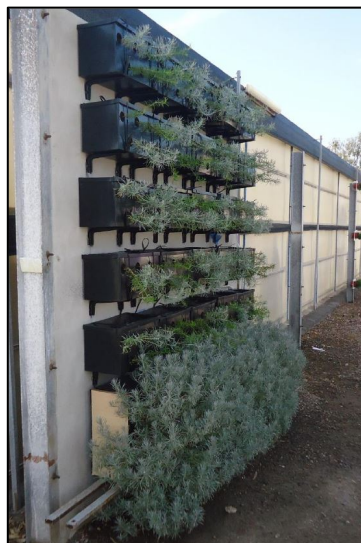
Figura 67. Inicio de unidades de cultivo pre-vegetales con sus respectivos anclajes antes de la instalación del sistema de fertirriego y drenaje
