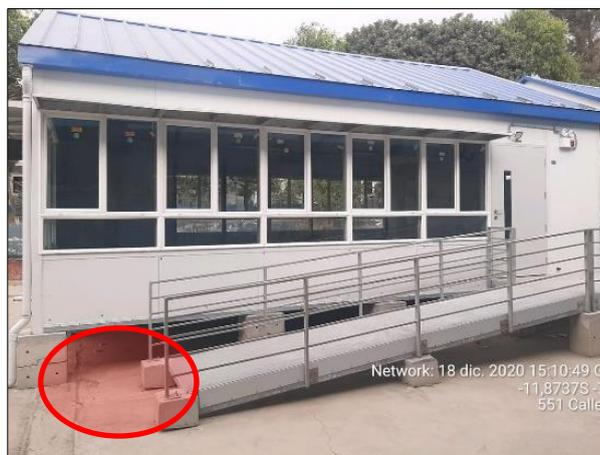
En ocasiones la rampa de los módulos quedaba por encima del nivel de piso terminado, lo cual no se tenía contemplado en el manual de montaje.
