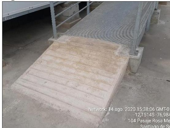
Se planteó la implementación de rampas de concreto para cubrir el desnivel que quedaba entre el nivel de piso terminado y la rampa metálica del módulo, para cumplir con el concepto de “acceso universal”, según el RNE A.120
