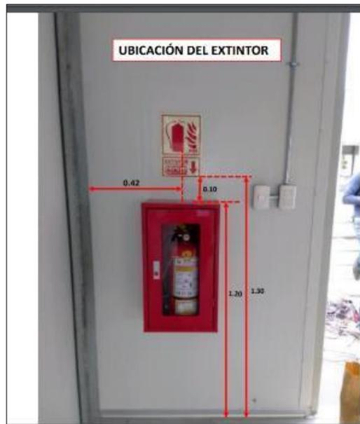
Se planteó detallar, con medidas, la ubicación de gabinete portaextintor, de acuerdo a la norma (NTP 350.043-2) así como el criterio de colocarlo en el eje del espacio del panel interior.
