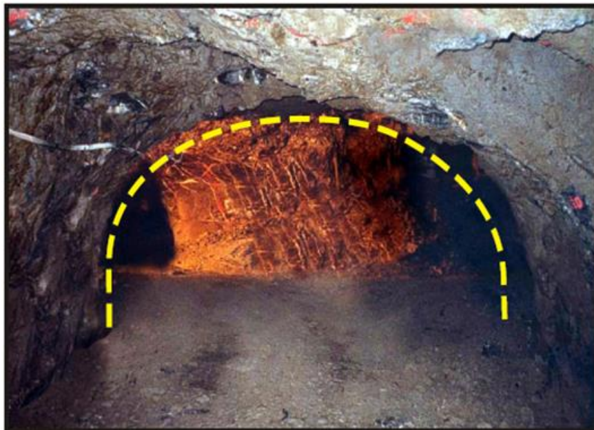
Figura 34. Excavación con geometría favorable Tomado de SNMPE, 2004
