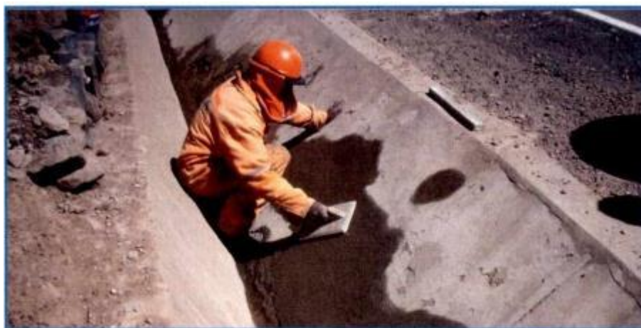
Figura 04 Mantenimiento de cunetas
