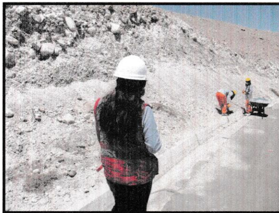
Fig. 4: Limpieza manual de las cunetas y bermas
