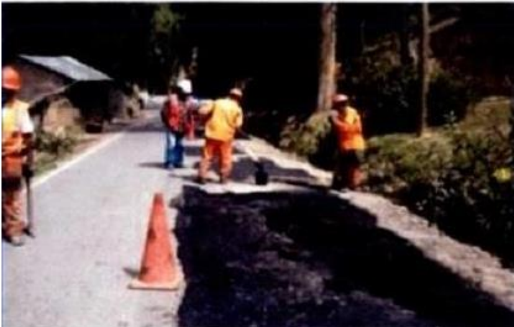
Figura 02 Sellado con emulsión asfáltica
