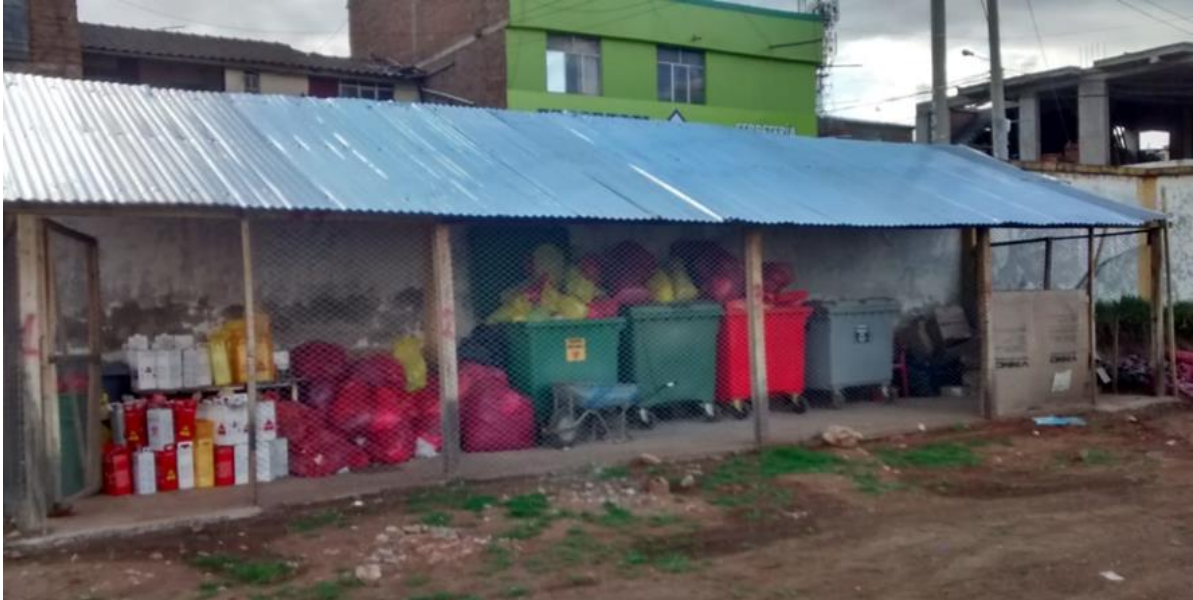
Figura 9. Área de almacenamiento final de residuos sólidos hospitalarios.
