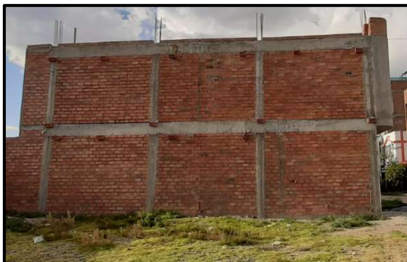
Figura 7: Vivienda con muros portantes y vigas peraltadas
