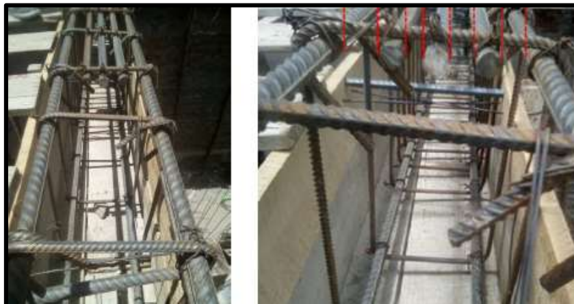
Figura 10: Espaciamiento entre barras longitudinales
