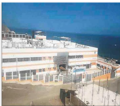
Figura 0:2 Hospital de chala avance físico 98.31 % desde el año 2019
