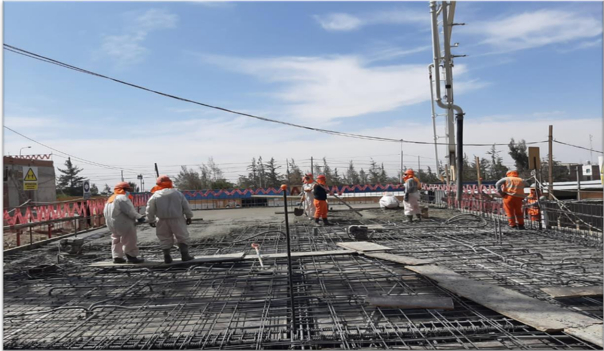
Fotografía 5: Vaciado de concreto en losas macizas.
