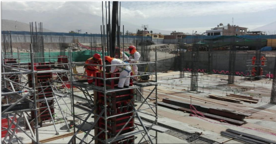
Fotografía 2: Vaciado de columnas.
