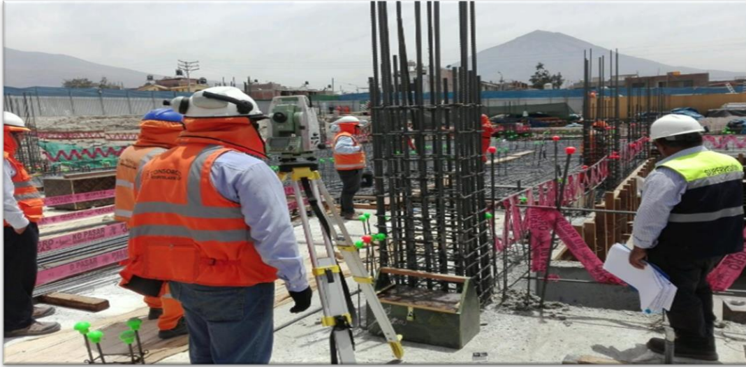
Fotografía 1: Habilitación de acero en columnas.
