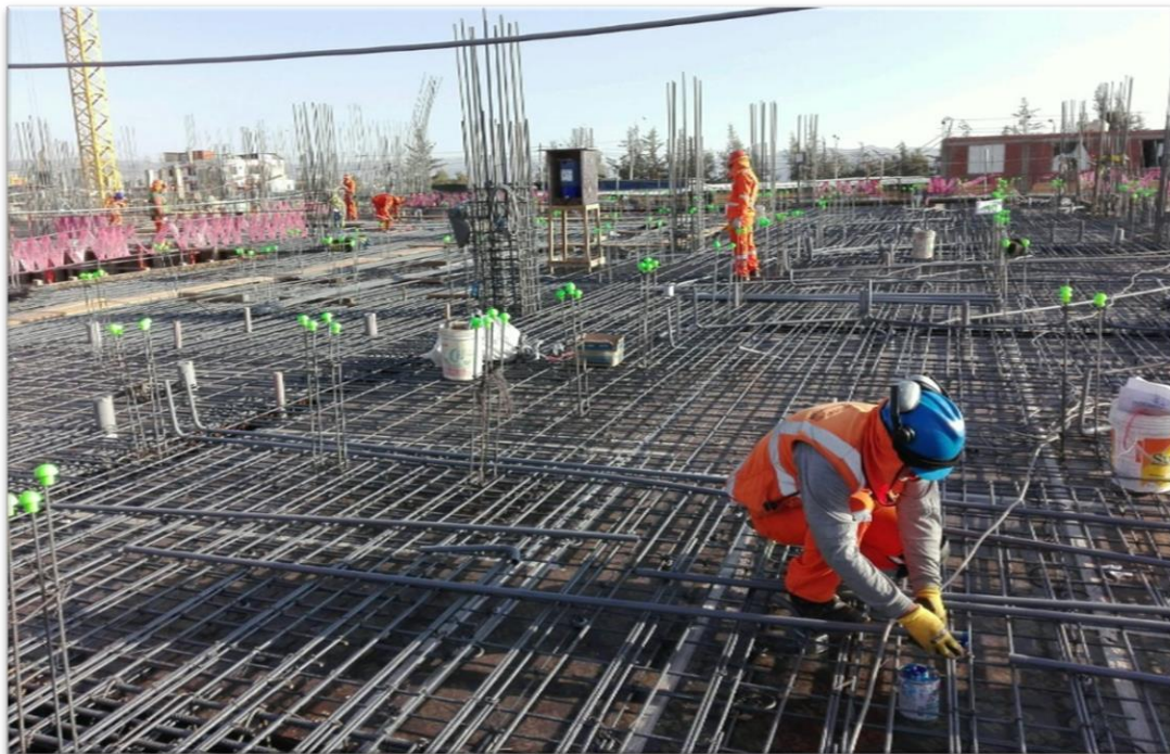
Fotografía 4: Habilidadación de acero.
