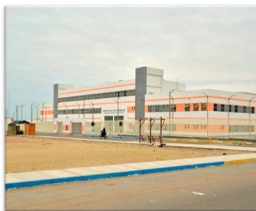
Figura 0:1 Hospital de Camana avance físico 67.16 % desde el año 2019
