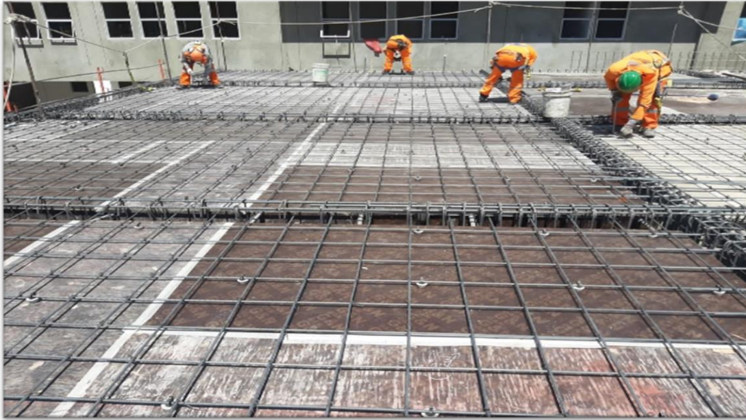
Fotografía 3: Colocacion de acero en losas macizas.
