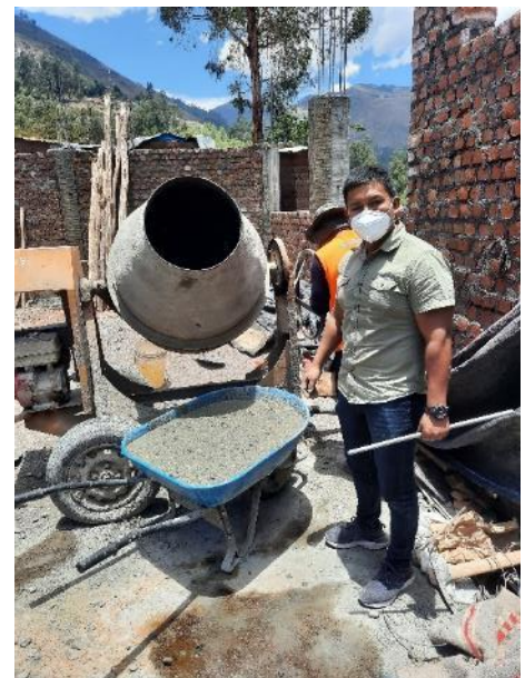
Foto 9. Vaciado de la mezcla en Boggie
