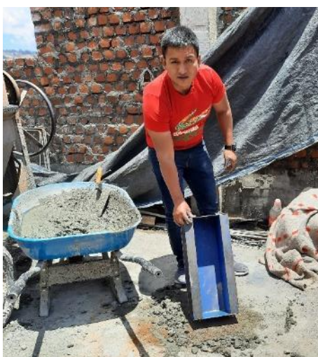
Foto 12. Llenado de vigas prismáticas
