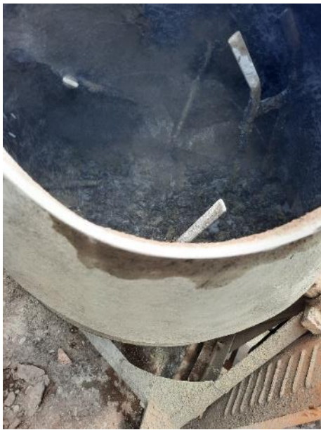
Foto 8. Preparación de la mezcla de concreto reforzado con FAR+MS
