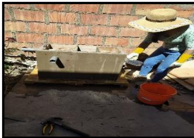
Curado de concreto en trampa de grasas.
