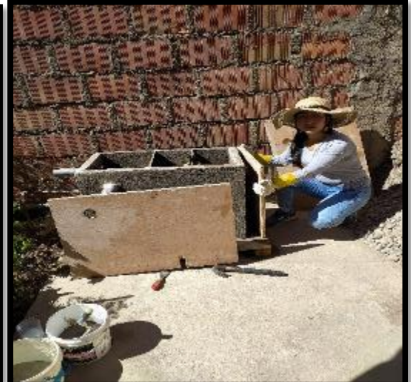
Desenfofrado de trampa de grasas.
