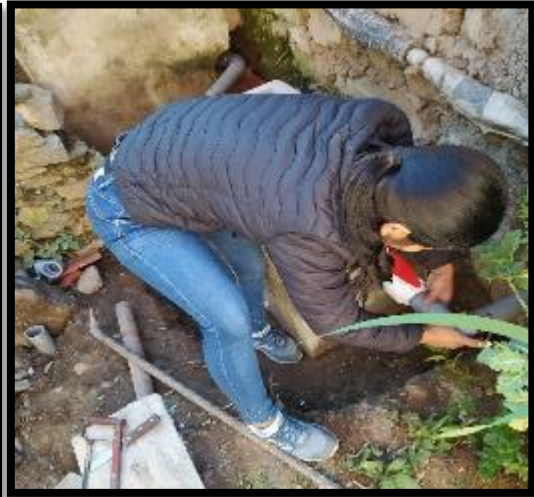
Unión de válvula a tubería de desagüe.
