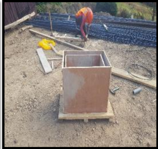
Encofrado culminado para la T.G.
