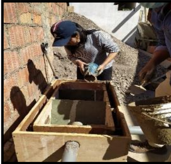
Vaciado de concreto segunda capa.
