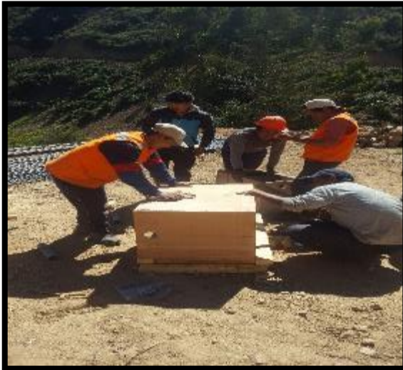
Perforado para instalación de tubería de purga.
