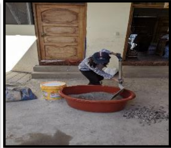
Mezclado del agregado y cemento.
