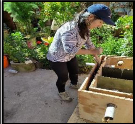
Compactado de concreto segunda capa.
