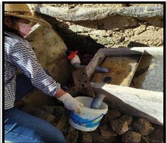
Puesta en funcionamiento del tubo de reboce.
