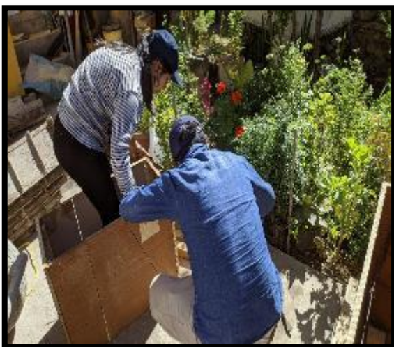
Verificación del encofrado de la T G.
