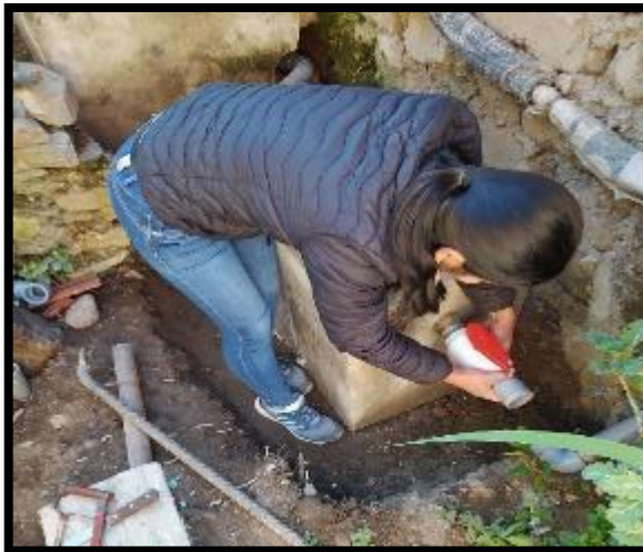
Instalación de válvula de paso en la salida de T.G.
