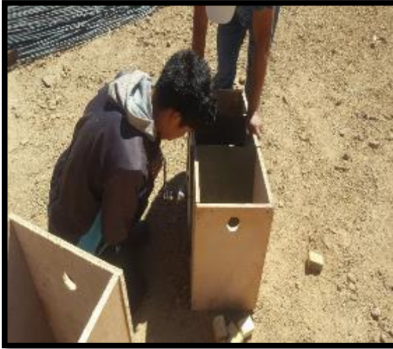
Armado del encofrado interior de la T.G.
