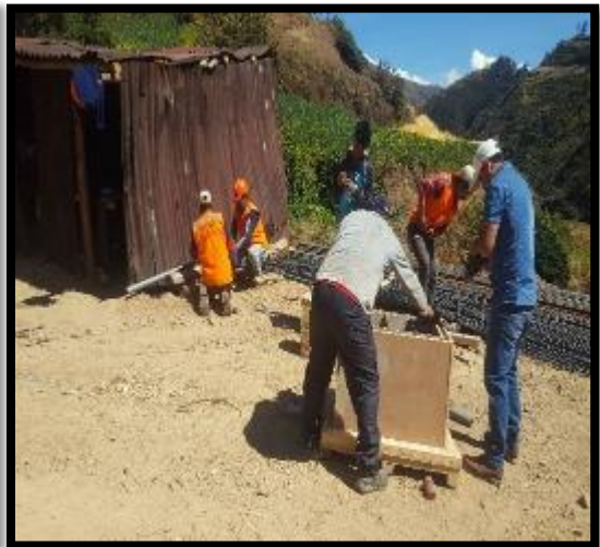
Armado del encofrado exterior de la T. G.
