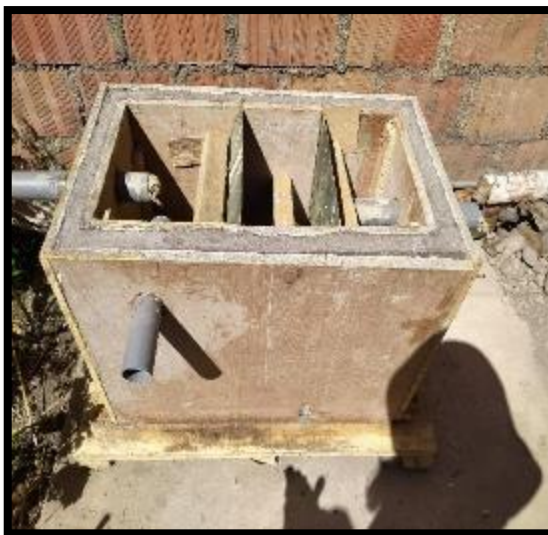
Vaciado de concreto concluido.
