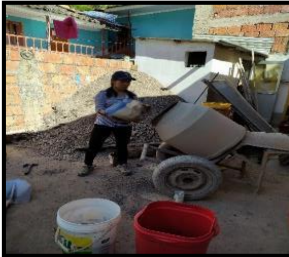
Adición de cemento a la mezcladora de concreto.
