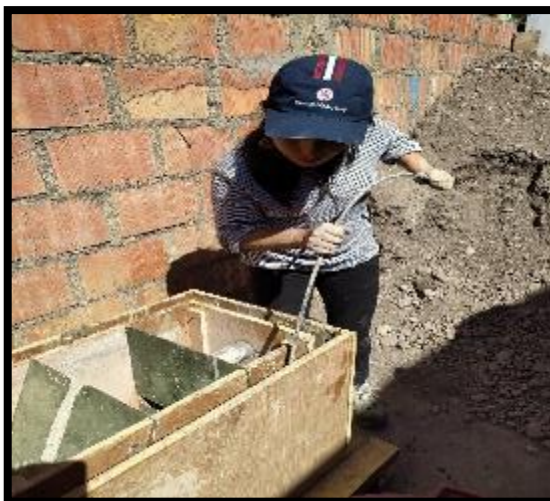
Vibrado de concreto primera capa.
