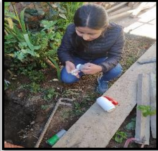
Colocado de cinta teflón a válvula de paso.
