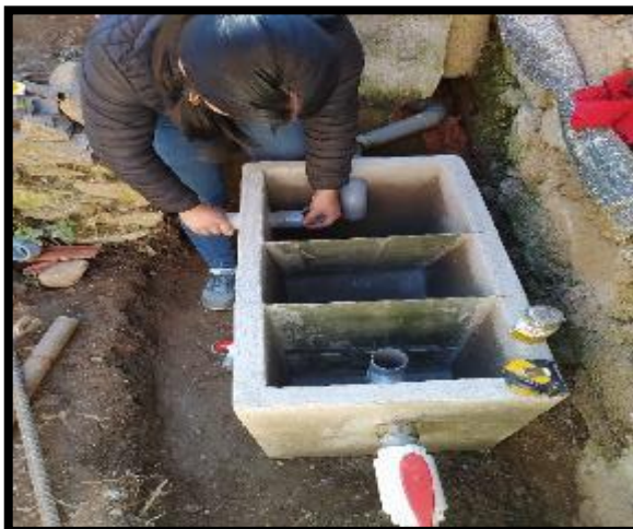
Instalación de tuvo de rebose.
