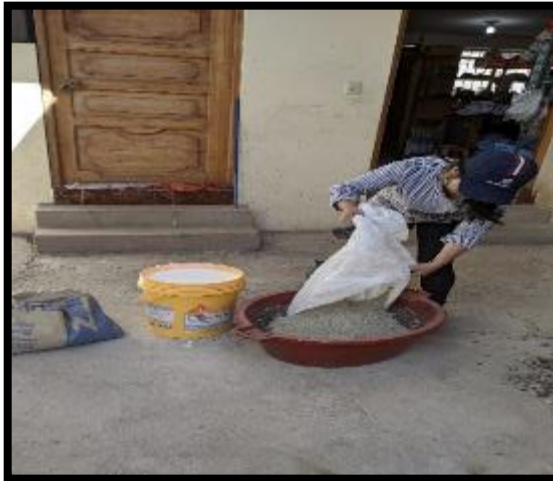
Adición del cemento al agregado.
