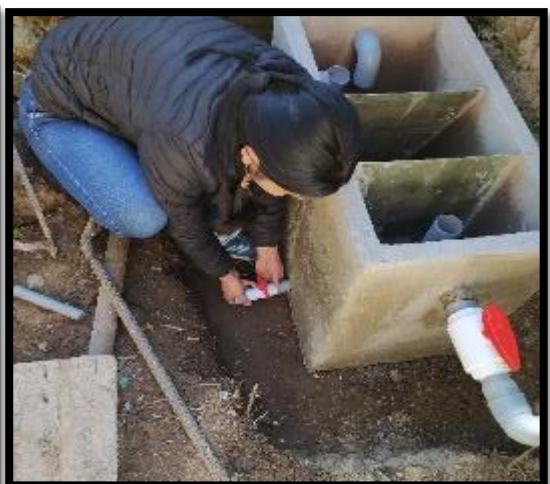
Instalación de valvula de purga.
