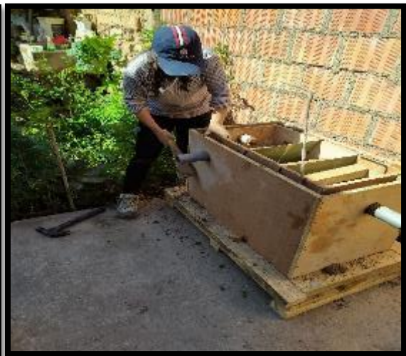
Compactado exterior de concreto.
