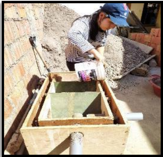
Vaciado de concreto en muros laterales.
