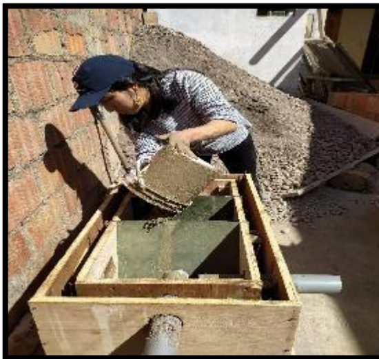
Vaciado de concreto en la base de T. G.
