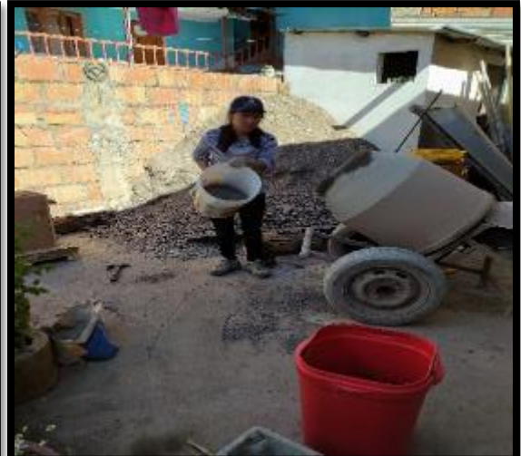
Adición del agregado grueso.
