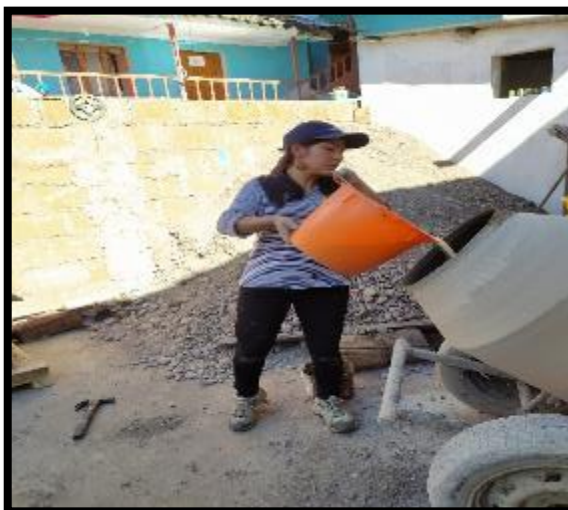
Adición de agua a la mezcladora de concreto.
