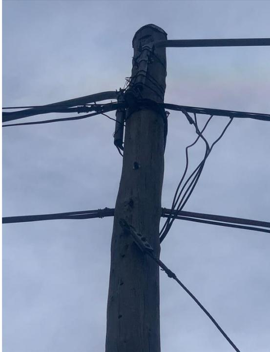
***Cables con deterioro en sus empalmes y mal sujetado en el poste de madera***
