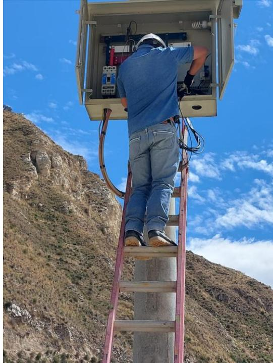
**Figura 9. Configuración de analizador de redes**
