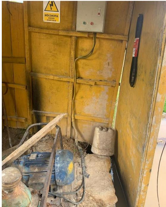
***Cables expuestos a la humedad en cabina de control 3***
