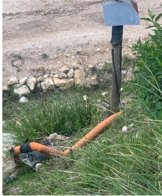
***Motor instalado en la intemperie con cables expuestos al medio ambiente***
