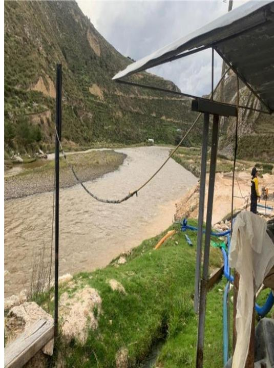
***Cables expuestos sin medidas de seguridad***
