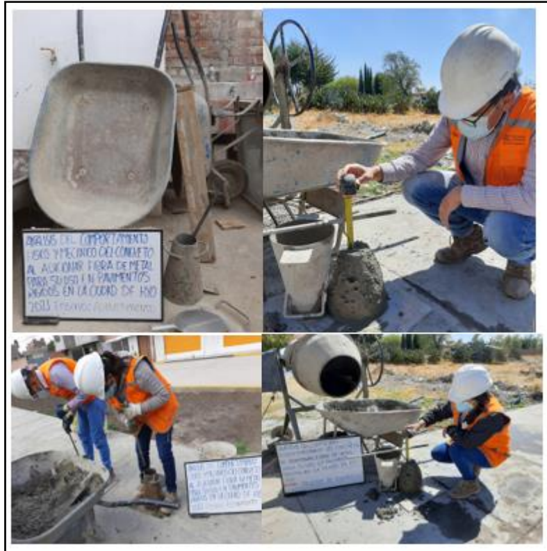
Figura 33: Ensayo de Asentamiento.
