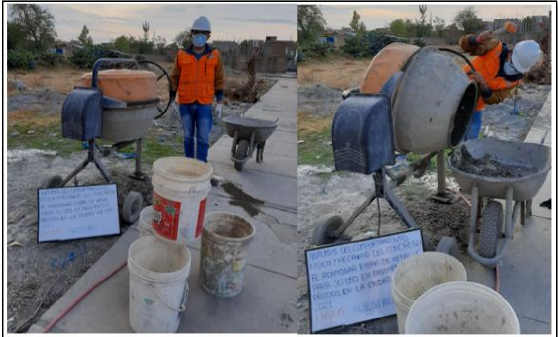
Figura 31: Toma de muestra del concreto.
