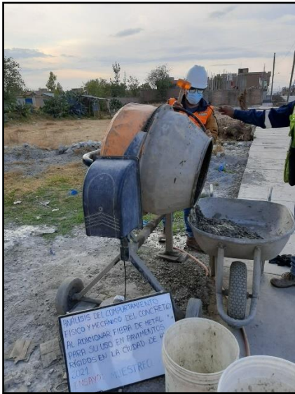
Foto 1: Preparación del concreto patrón para un f'c=280\text{kg/cm}^2 . Fuente: Elaboración propia
