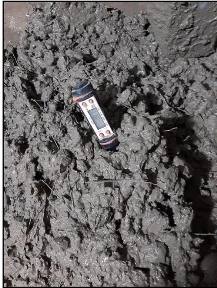
Foto 5: Medición de temperatura del concreto fresco con 30 kg/m 3 de fibra de metal. Fuente: Elaboración propia
