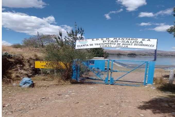
Figura 3. Entrada a PTAR-JAUJA
