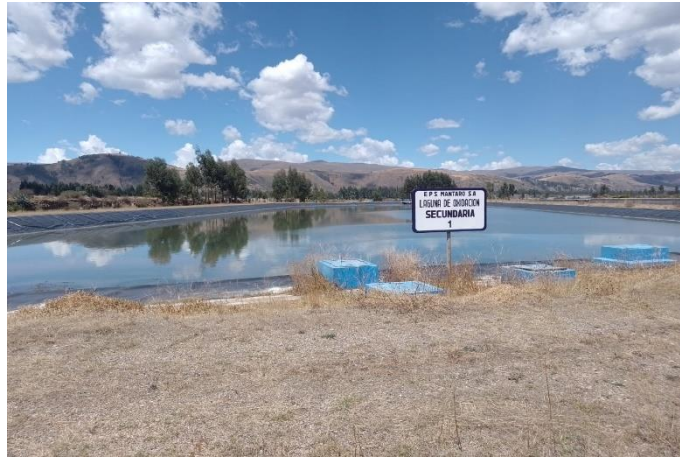
Figura 7.Laguna de oxidación secundaria
