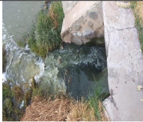
EFLUENTE -PTAR JAUJA
