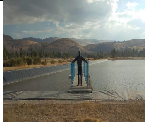
LAGUNA DE OXIDACIÓN SECUNDARIA II
