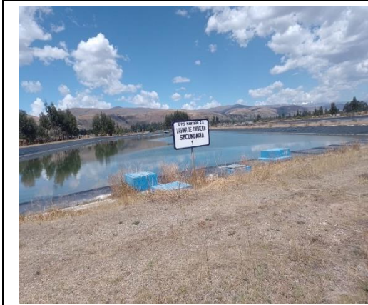
LAGUNA DE OXIDACIÓN SECUNDARIA I
