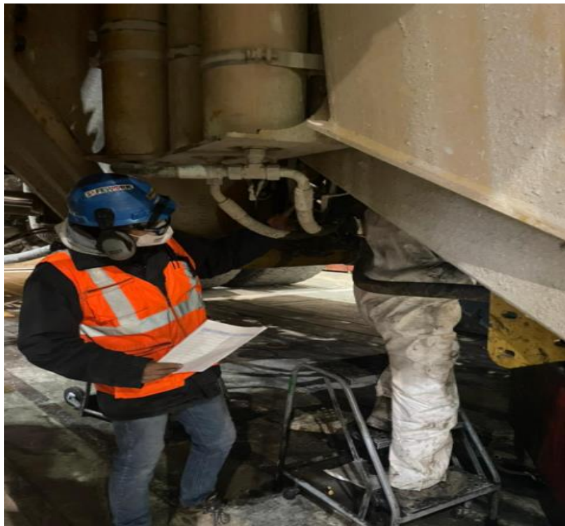
Figura 35: Supervisión de los trabajos de reubicación de la base de filtros
