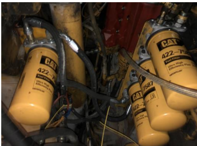
Figura 27: Reubicación de base de filtro terciario de combustible
