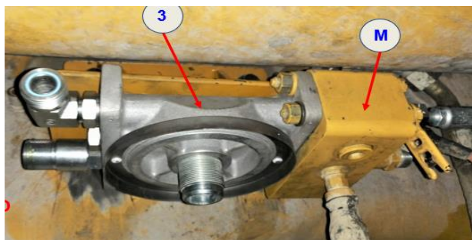
Figura 33: Base de filtro de combustible y manífull de filtros de combustible
