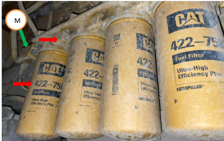
Figura 30: Partes a ser retiradas de la base de combustible y partes para ser almacenadas e instaladas posteriormente
