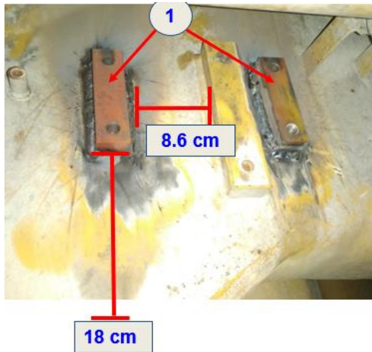
Figura 25: Bloques soldables para soporte de base filtros terciario de combustible
