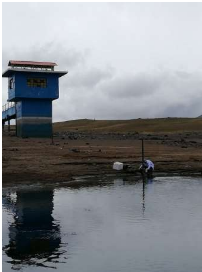
Anexo 12. Toma de agua de la represa para el canal de Ica.
