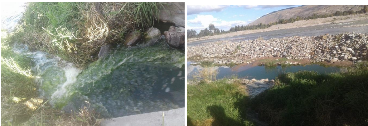
Fotografía 4. Efluente final del agua residual tratada de la PTAR Jauja
