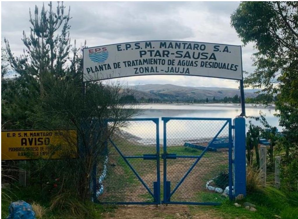
Fotografía 1. Puerta de ingreso a la PTAR Jauja
