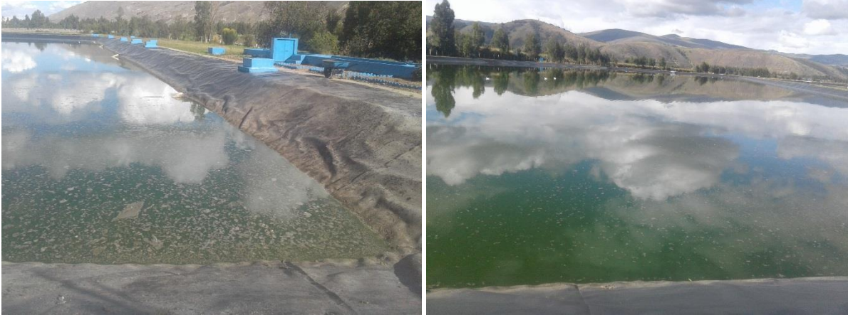
Fotografía 3. Tratamiento biológico en las lagunas de oxidación
