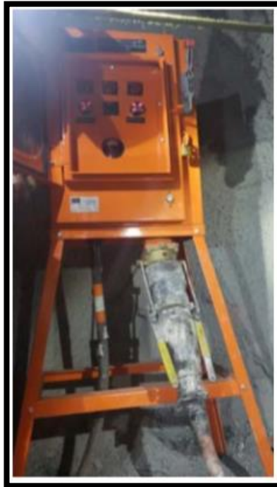
Figura 33. Funcionamiento correcto del tablero grounding check (19)
