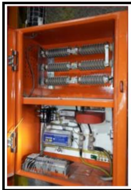
Figura 21. Tablero eléctrico de resistencia
