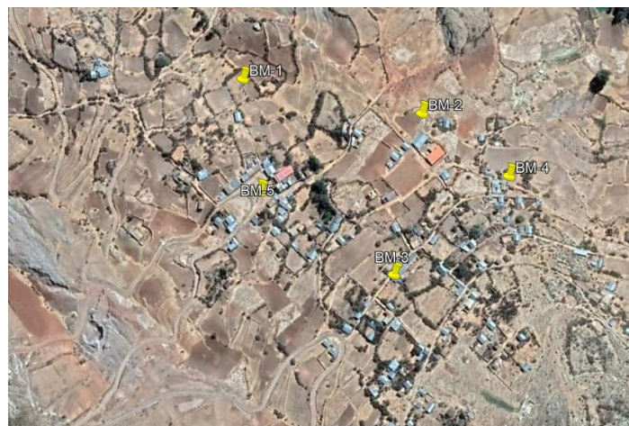
Figura 16. Vista panorámica del BM's tomados para la exploración y estudio de mecánica de suelo centro poblado de San Miguel
