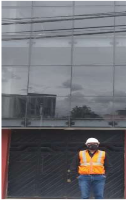
Foto 01: Evidencia en la edificación de la investigación.
