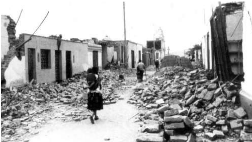
Figura 1. Edificios del terremoto de Lima 1940
